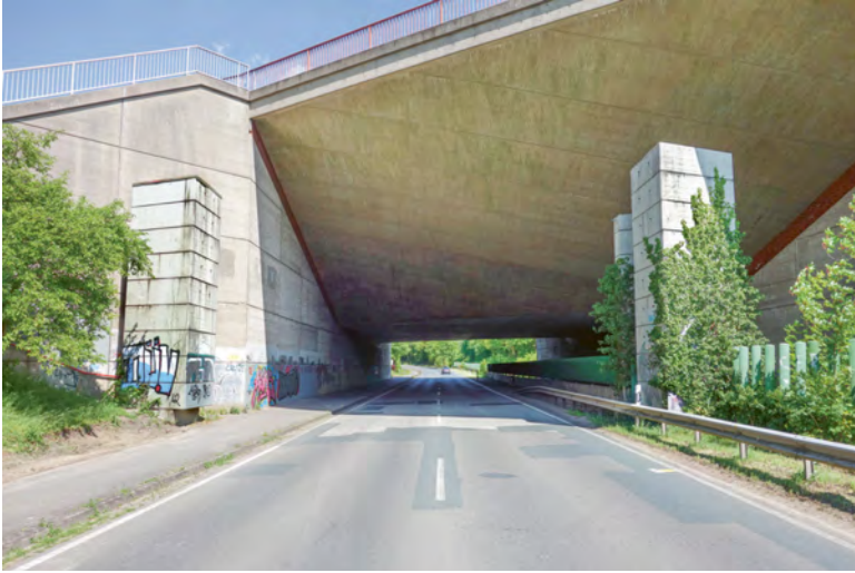
Abb. 8: Fallkörpersperre Erbstorf, Foto 2019.
