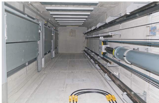
Bild 71 Seilhydraulische Aufzugsanlage ohne Triebwerksraum in einem Wohngebäude; Blick in Richtung Schachtkopf mit Hydraulikzylinder und Heber. Auf der rechten Seite, oben und unten im Bild, sind die Führungsschienen sichtbar.
