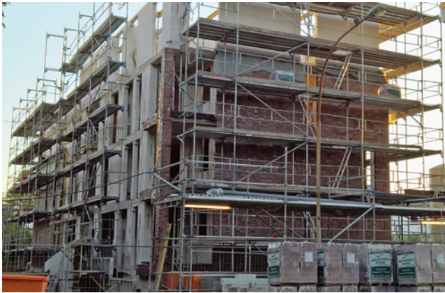
Bild 58 Wohnungsbau mit Mauerwerk aus Kalksand-Planelementen, Verblendmauerwerk und Stahlbetondecken aus Fertigteilplatten mit Ortbetonergänzung
