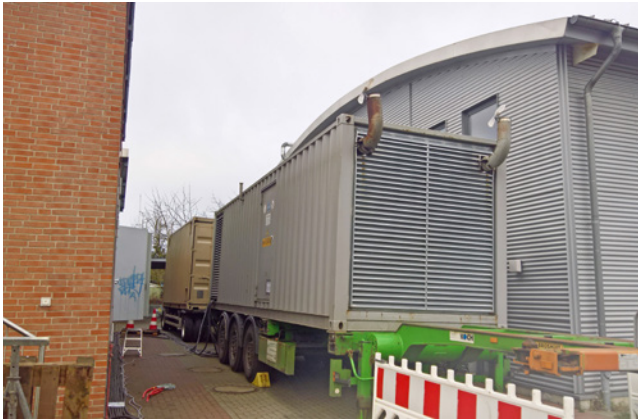
Bild 90 Beispiel zur Wirkung von Sekundärschall: mobile Notstromanlage neben einer Halle mit Büros und Arbeitsflächen (rechts im Bild)
