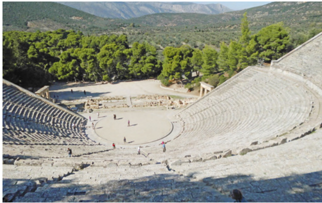
Bild 13 Das offene Theater in Epidauros, Griechenland, wurde im 4. Jh. v. Chr. für 10 000 Hörer unter dem Aspekt der optimalen Sprachverständlichkeit gestaltet.
