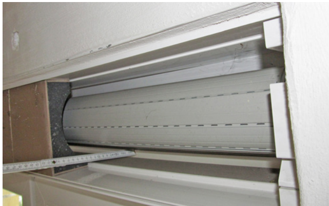
Bild 87 Gurtdurchführungen durch einen wandintegrierten Rollladenkasten. Die vordere Schalldämmeinlage wurde zur visuellen Untersuchung ausgebaut. Die rechte, unbenutzte Gurtdurchführung ist eine Schwachstelle der Schalldämmung.
