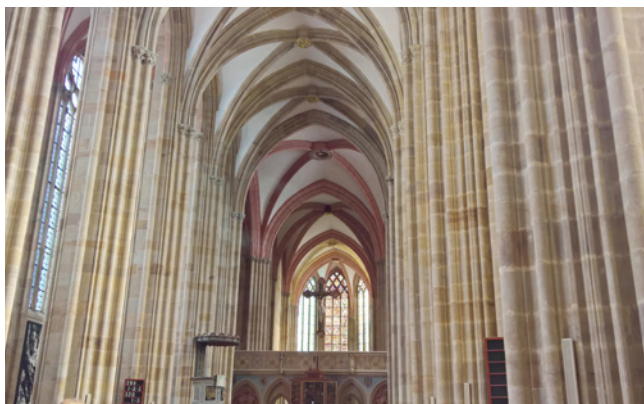
Bild 14 Innenraum des Doms zu Meißen. Gotische Hallenkirche mit sehr hoher Nachhallzeit. Zur Verbesserung der Sprachverständlichkeit bei der Predigt wurde über der Kanzel eine Haube als Reflektor angeordnet.
