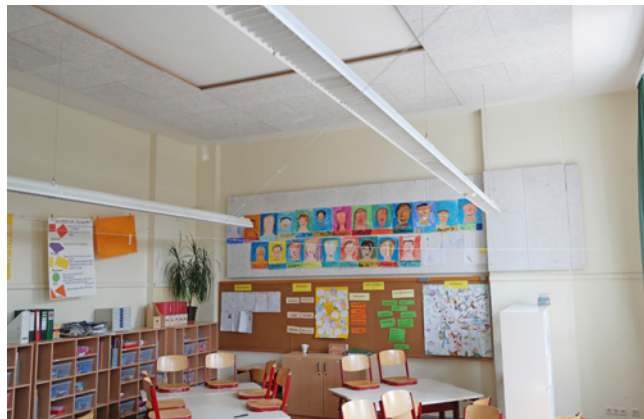
Bild 29 Nachträglich mit Schallabsorbern aus Holzwolle-Platten ausgestatteter Unterrichtsraum in einer Grundschule (Baujahr 1985)
