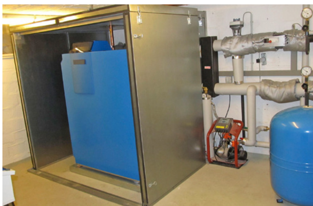
Bild 105 Heizungsanlage mit nachträglichem angebrachten Gehäuse
