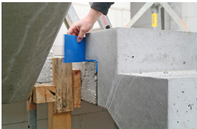
Bild 67 Auflagerung eines massiven Fertigteiltreppenlaufs auf einer Podestplatte mit Elastomer-Treppenlager. Der nachträgliche schwimmende Podest-Estrich ist sorgfältig körperschall-isoliert einzubauen.
