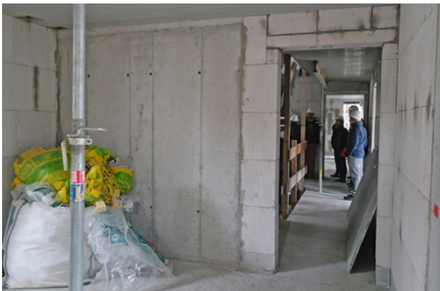
Bild 74 Aufzugsschacht aus Stahlbeton (Stärke: 25 cm) in einem Massivbau aus gemauerten Kalksand-Planelementen
