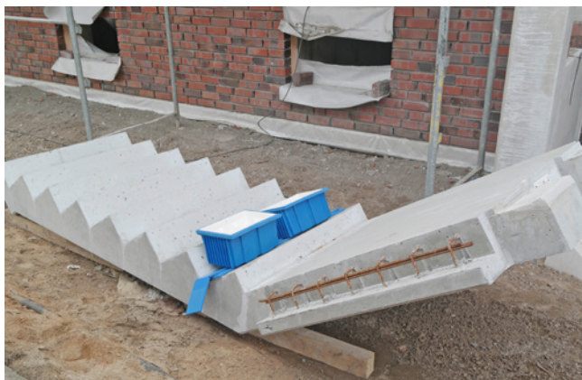
Bild 66 Massiver Fertigteiltreppenlauf mit unterem Zwischenpodestsegment, Auflagerkonsolen und Entkopplungselementen (blau). Die Podestsegmente werden später durch Ortbeton ergänzt.
