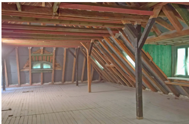
Bild 64 Alte Holzbalkendecke (Baujahr 1910), Ansicht vor der Instandsetzung
