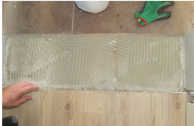
Bild 68 Körperschallbrücke infolge unzureichender Estrichtrennung zwischen Treppenpodest (Fliesenbelag) und Wohnung (Parkett) im Wohnungseingangsbereich
