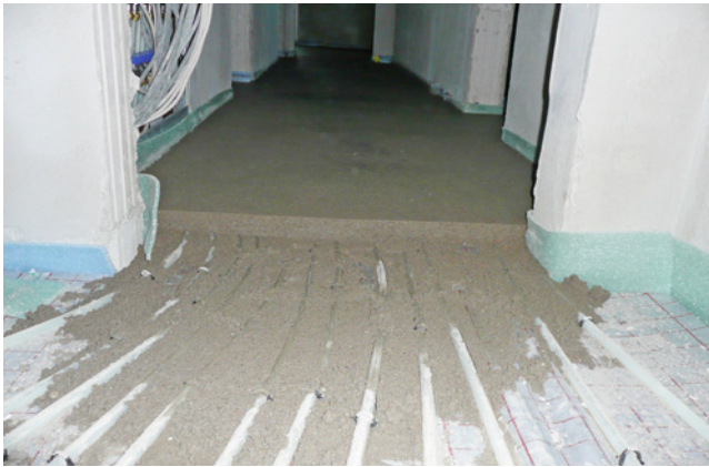
Bild 50 Einbau eines Heiz- estrichs: Zur Vermeidung von Schallbrücken sollten Trittschalldämmung und Randdämmstreifen vor dem Estricheinbau durch die Fachbauleitung kontrolliert werden.
