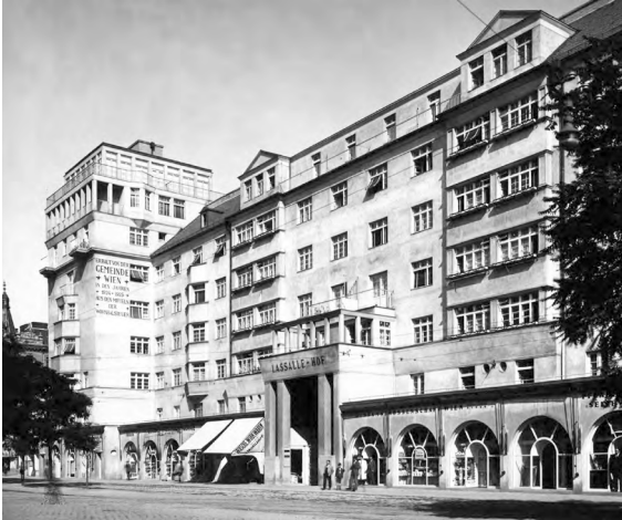
Abb. 105: Der Lassalle-Hof in Wien, fotografiert 1926 von der Lassallestraße aus. Quelle: Wiener Stadt- und Landesarchiv, 3.3.2.FC1.407M.
