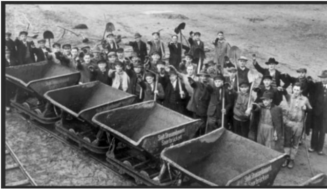
Abb. 41: Autobahnbauarbeiter im Saarland erbeiten den Hitlergruß für die Filmkamera, wahrscheinlich 1936; Quelle: NS-Propagandafilm/ Bundesarchiv.
