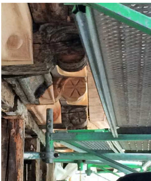
Abbildung 5: Fußwinkelbohlen und geschädigte Schiffskehlen und Tönnchenbalken
