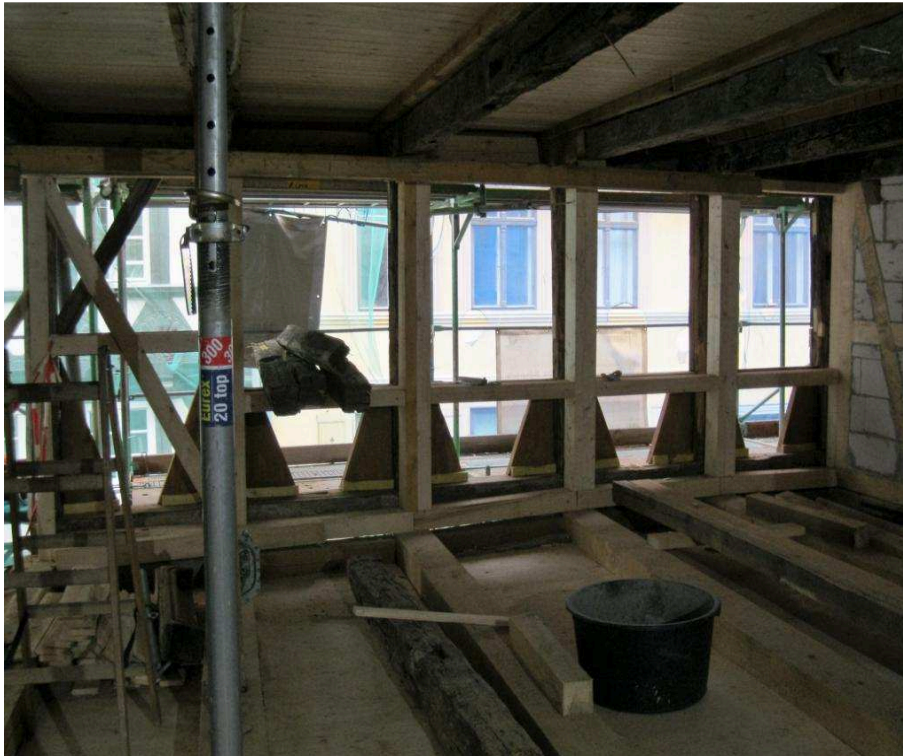
Abbildung 6: Zweites Fachwerk für Aufnahme von Innendämmungen errichtet
