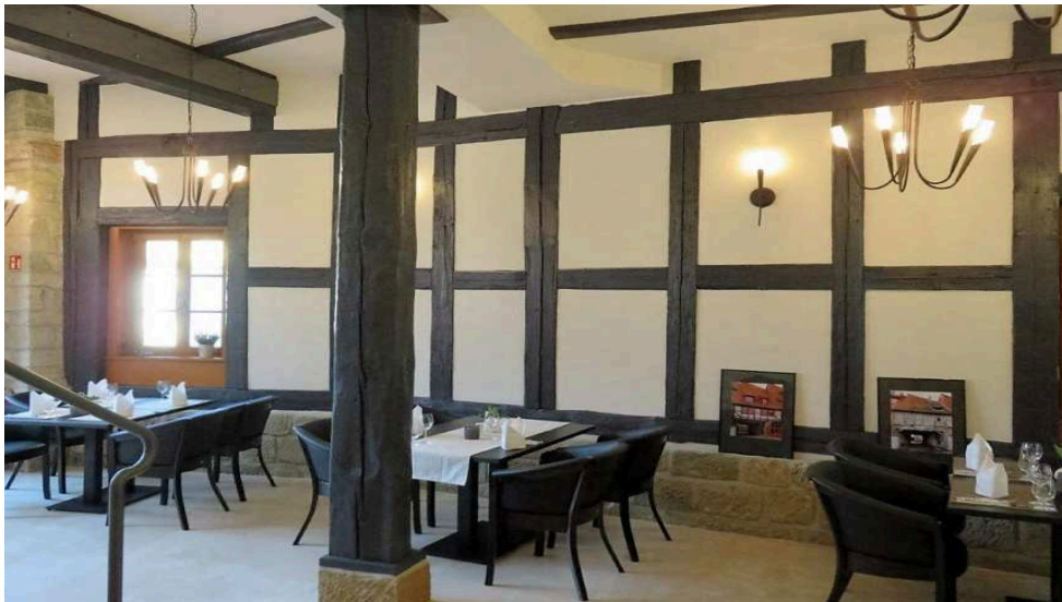
Abbildung 11: Inneres Fachwerk aus Altholz sichtbar im Gastraum
