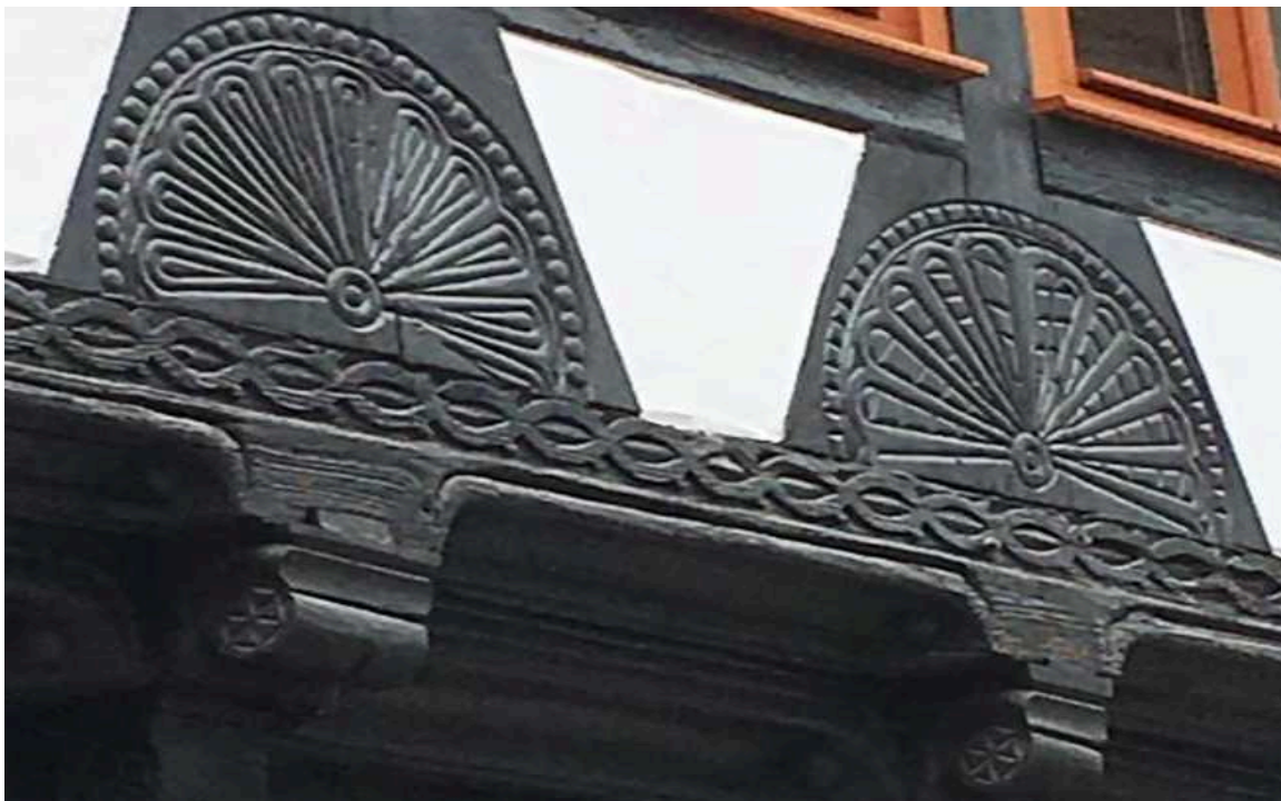
Abbildung 14: Rekonstruierte Fachwerkbrüstungen mit geschnitzten Fußwinkelbohlen
