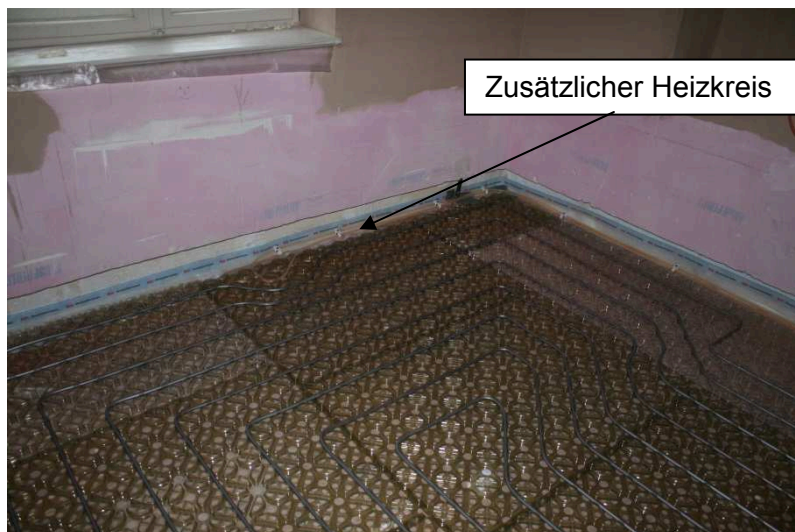
Abbildung 4: Schulgebäude Drebkau – Klimaboden (Balkenköpfe S22-S24)
