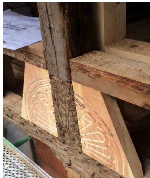
Abbildung 5: Fußwinkelbohlen und geschädigte Schiffskehlen und Tönnchenbalken
