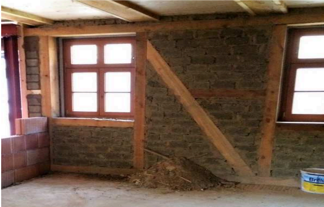
Abbildung 8: Lehmsteinausmauerung des inneren Fachwerkes
