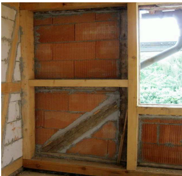
Abbildung 7: Ausmauerung der äußeren Gefache
