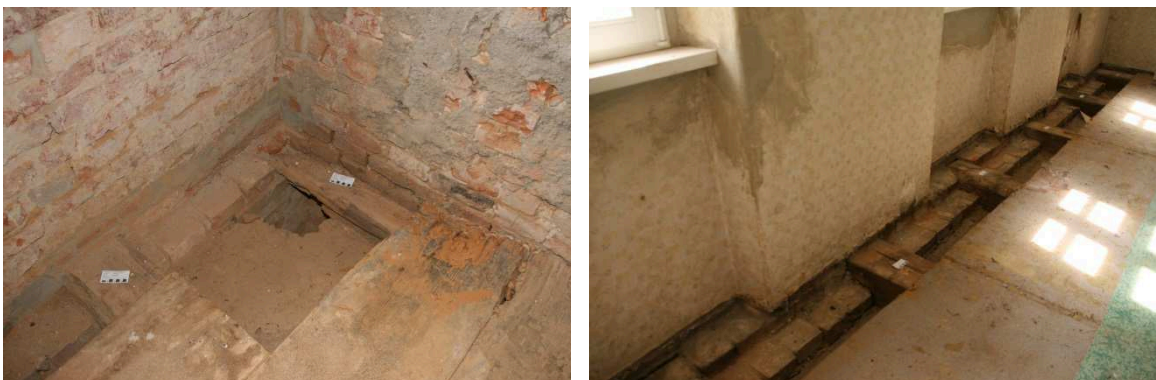
Abbildung 1: Auflagerbereich einer Holzbalkendecke (Baujahr um 1850)
