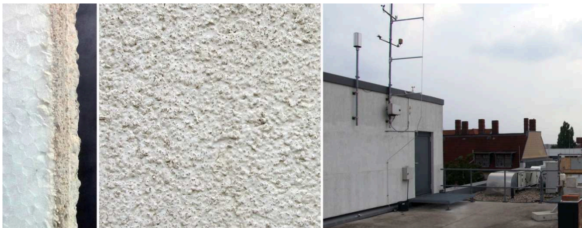
Abbildung 7: Untersuchtes WDVS-Dünnschichtputzsystem in exponierter Lage, Schnitt (links), Oberfläche (mitte) und Ansicht (rechts)
