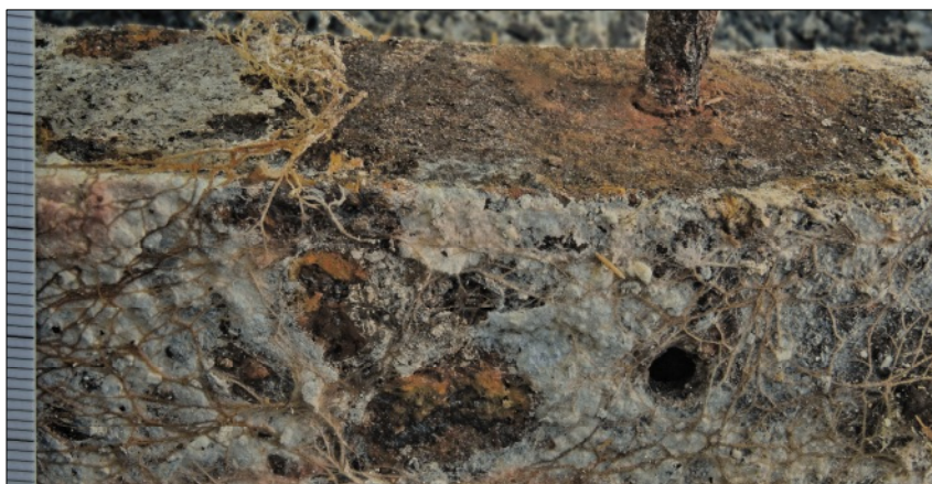
Abb. 11: Ockerfarbiger Sternsetenpilz: ockerfarbene Stränge zwischen Eisenträger, Mörtel und Mauerwerk. Der schwache Weißfäuleschaden ist nicht sichtbar, war aber in der Nähe; stärkere Weißfäule-Schäden sind selten bei dieser Gattung.
