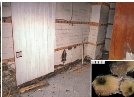
Abb. 6: Nicht einbezogene Bereiche und Schadorte in Altbau-Kellern ohne Balkenlage; Bild zeigt einen feuchten Keller mit Befall durch Echten Hausschwamm; Eckbild: Strang-Querschnitte.
