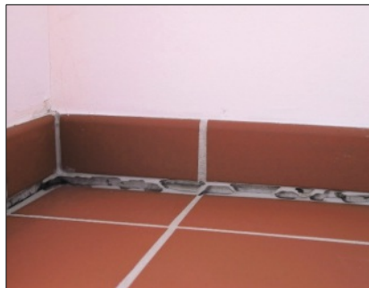
Abb. 5: Fußbodenheizung im Autohaus – Sockelleistenabriss bei einer Fußbodenheizung
