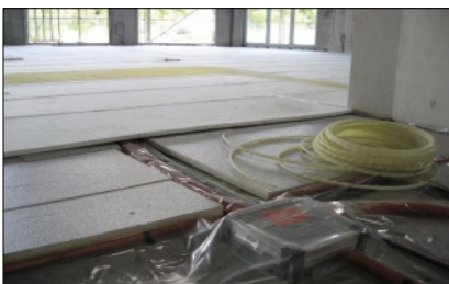
Abb. 22: Heizrohr-Übersprung und Hohlstellen. Baupfusch – ohne Abnahme?
