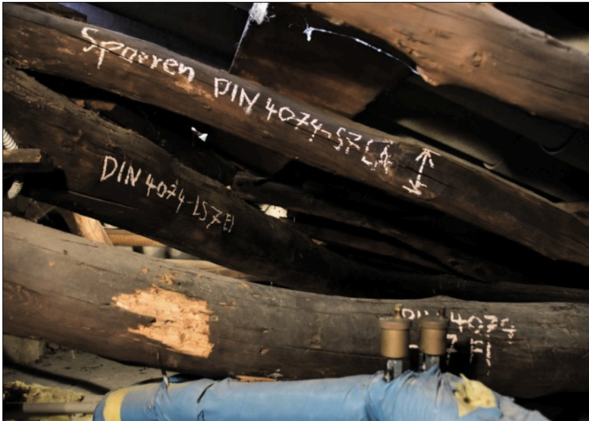
Abb. 13: Markierte puntoni (Streben) nach der Holzsortierung
