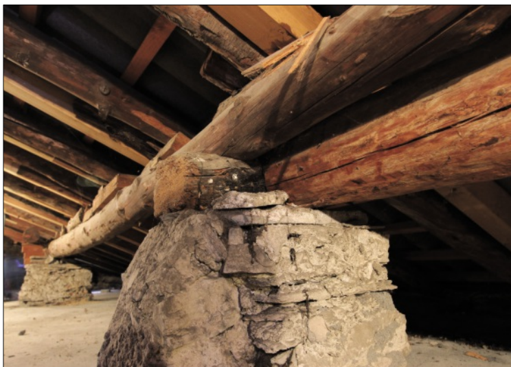
Abb. 8: Kalksteinpfeiler unterstützen die terzere (Pfetten)
