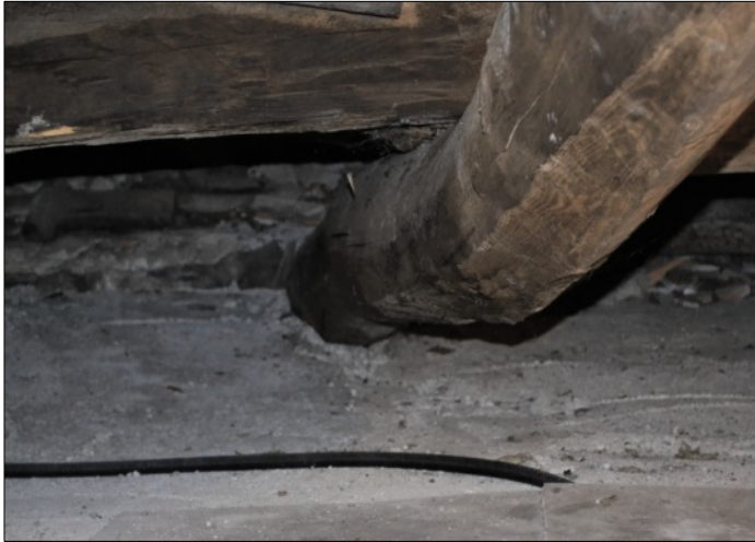
Abb. 10: Eingemauerte puntoni (Hängewerksstrebe)
