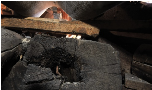
Abb. 22: Innenfäule, verursacht durch Moderfäulepilze in einer terzera (Pfette)
