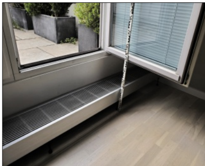
Abb. 8: Vollkommen gebrauchsuntaugliche Austrittshöhe auf eine Terrasse, jedoch ist die Einhaltung der 15 cm-Regel erfüllt.
