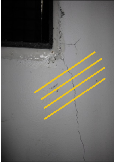
Abb. 2: Im Stahlbetonbau lässt sich anhand der Risslage sehr gut rückschließen, dass meist senkrecht zu den Rissen die „rissauslösende“ Zugkraft auftritt (hier fehlende diagonale Eckbewehrung an einer Fensterleibung)
