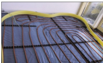
Abb. 22: Heizrohr-Übersprung und Hohlstellen. Baupfusch – ohne Abnahme?
