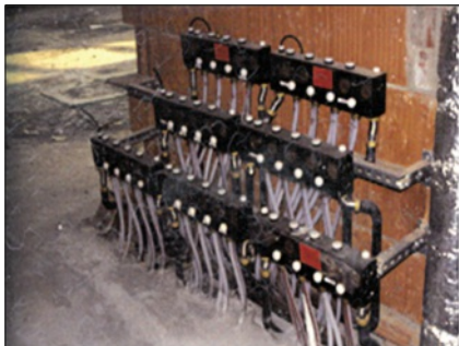
Abb. 16: Fehlerhafte Anordnung von Verteilern/Sammlern mit unnötiger Heizrohrkonzentration
