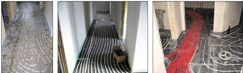
Abb. 12: Falsche Planung und Ausführung – unzählige Anschlussrohrleitungen von Heizkreisen im Flur
