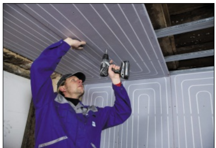
Abb. 4: Wand-Decken-Panelflächenheizung Uponor Renovis und beheizter MERO-Doppelboden
