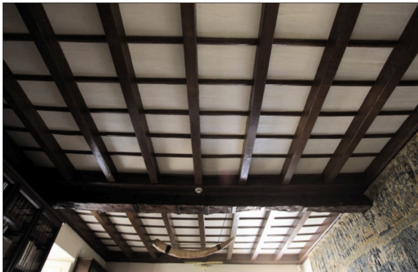
Abb. 4: Einfache schlanke Balkendecke mit Unterzügen
