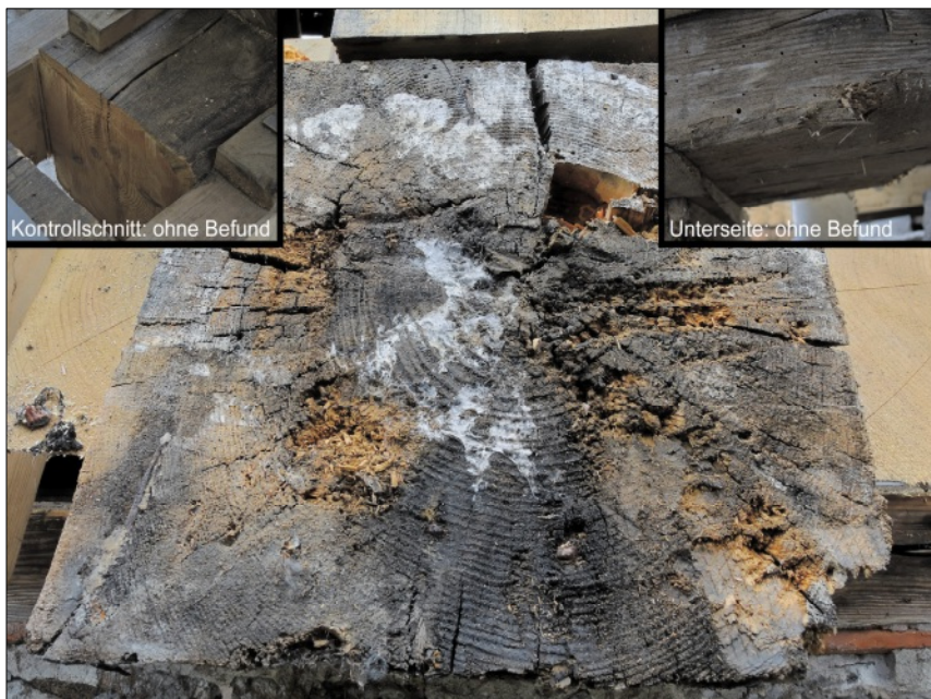
Abb. 8: Eine lokale Durchfeuchtung an einem Balkenkopf schafft einen Lebensraum für den Echten Hausschwamm – ein minimaler Hausschwammschaden, der eng auf diesen Balken beschränkt blieb.
