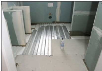
Abb. 2: Bauarten nach DIN EN 1264: Nassbau- und Trockenbausysteme
