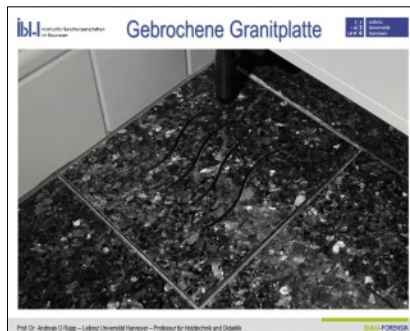
Tageslichtnormalbild einer reparierten Granitplatte
