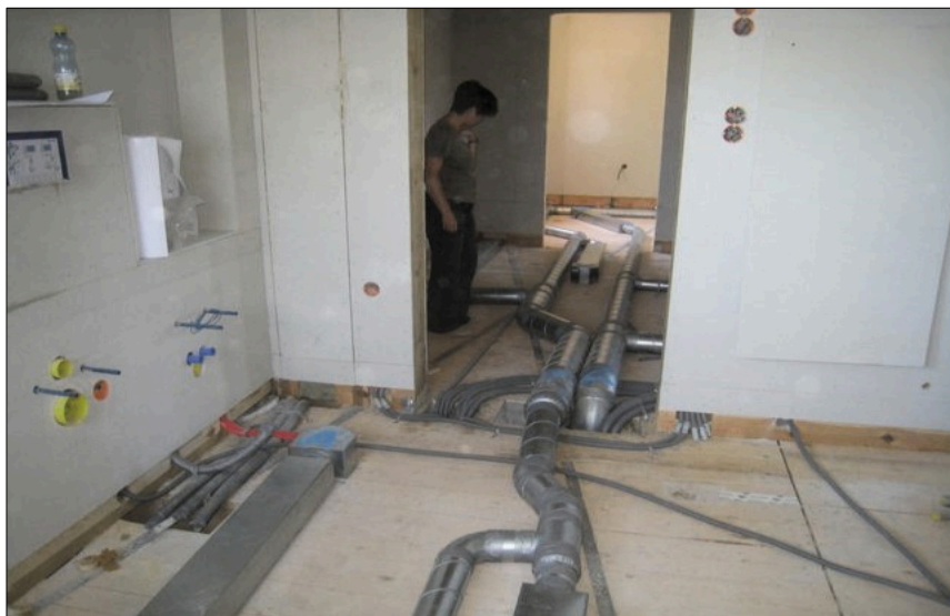
Abb. 27: Luftleitungen im Fußboden als Herausforderung für sämtliche weiteren Baubeteiligten
