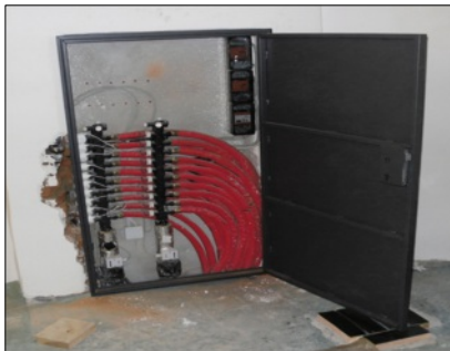
Abb. 16: Fehlerhafte Anordnung von Verteilern/Sammlern mit unnötiger Heizrohrkonzentration
