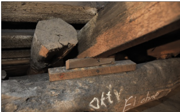
Abb. 25: Aktiver Nagekäferbefall in den gatelli (Unterlagshölzern)
