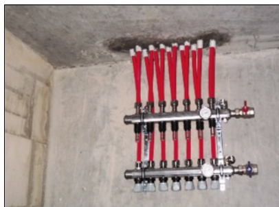
Abb. 17: Kernbohrungen zum kurz geführten Anschluss der Heizkreise auf der Rückseite des Verteiler/Sammlers sowie Verteiler/Sammler unter der Heizebene
