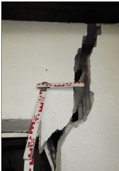
Abb. 3: Querdehnung: \nu = \epsilon_x / \epsilon_y kann > 0,50 sein. Beispiel einer sehr großen Rissöffnung, um zu zeigen, dass die Querdehnung – bei klassischer Betrachtung – größer als 0,5 wäre, was eine Fehlinterpretation wäre.
