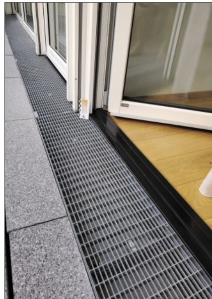
Abb. 9: Beispiel eines Terrassenaustritts, wie dieser für eine gebrauchstaugliche Nutzung ausgeführt sein soll; keine Einhaltung der 15 cm-Regel gegeben, jedoch auch keine Schäden nach fünf Jahren der Nutzung vorhanden.
