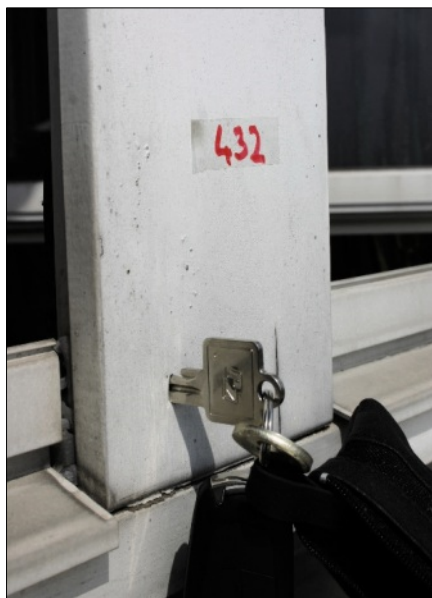
Abb. 6: Obwohl äußerlich fast intakt erscheinend, ist dieser Pfosten stark verfäult.
