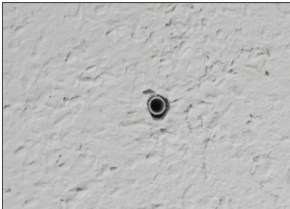
Tageslichtnormalbild: Ausschnitt aus dem oben gezeigten Übersichtsbild; auch aus der Nähe kein Schimmelpilzbefall mit bloßem Auge erkennbar.
