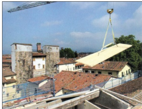
Abb. 24: Brettspertholz als Sparrenersatz in Lucca Toscana, aus Bausubstanz 4/2019
