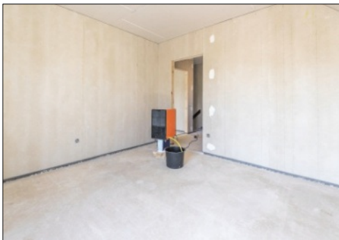
Abb. 8: Trocknungsdauer eines Estrichs in Abhängigkeit (raum-)klimatischer Bedingungen (TKB Merkblatt 14) und Bautrocknung in situ (Entfeuchtung)
