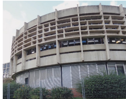
Abb. 115: Gebäude mit einem feststehenden Sonnenschutz aus freistehenden Lamellen mit einem F_c -Wert von 0,50
