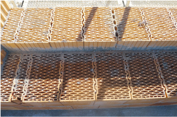
Abb. 130: Draufsicht auf die Brüstung in der Rohbauphase im Fensterbereich durch den monolithischen Wandaufbau des hochgedämmten Mauerwerk des Gebäudes »2226« von Baumschlager Eberle (Quelle: Fa. Wienerberger Ziegelindustrie GmbH).
