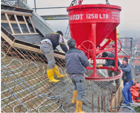
Abb. 75: Betonage des Dachs von Haus 36 (MBA/S, Stuttgart)
