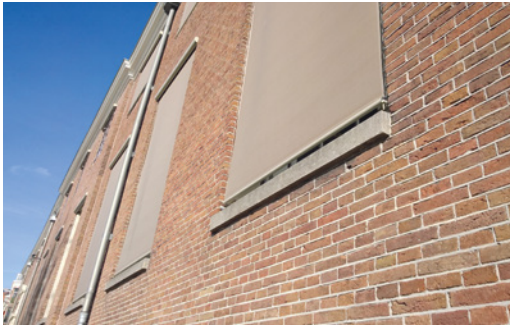
Abb. 114: Außenliegender Sonnenschutz – fassadenbündig integriert mit einem F_c -Wert von 0,10
