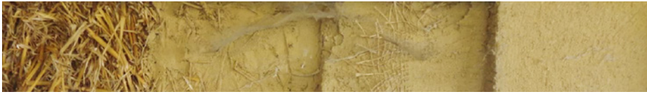
Abb. 89: Schichtaufbau einer Strohballenwand mit mehreren Lagen an Lehmputz und Jutegewebe-einlage
