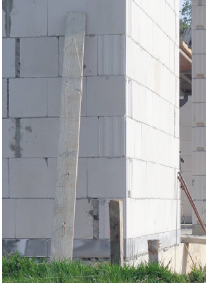
Abb. 125: Fußpunkt einer Kalksandsteinwand mit einem dämmenden Kimmstein am Materialwechsel zwischen Betonbodenplatte und aufgehender Wand
