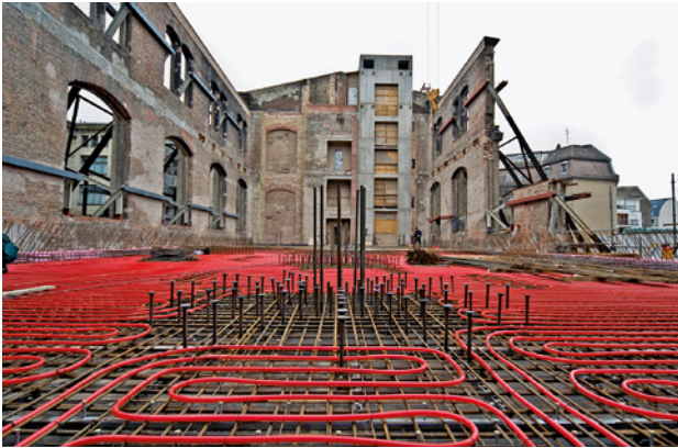
Abb. 62: Verlegtes Rohrnetz einer Betonkernaktivierung auf der unteren Bewehrungslage einer Deckenplatte (im Durchstanzbereich der Innenstützen sind die Rohrnetze aus konstruktiven Gründen nicht verlegt) (Quelle: Museum für Naturkunde Berlin)
