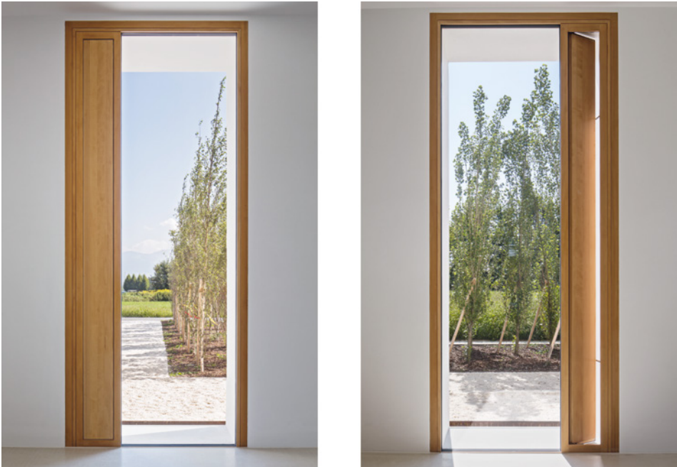
Abb. 132: Innenansicht der Fensterelemente im Gebäude »2226« mit geschlossener und geöffneter Zuluftklappe (Quelle: Baumschlager Eberle)
