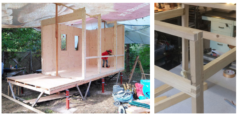
Abb. 7/8: Das linke Bild zeigt den Zusammenbau eines ersten Prototyps für ein CNC-gefrästes Tiny House bei WBZ. Auf dem rechten Bild dokumentiere ich zeitgleich die neu erlernte Steckverbindung für das Grundgestell meines Stuhls, den ich während des Lockdowns baue.
