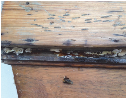
Bild 6 Unter der Schwelle hervordringendes Myzel und Fruchtkörper
