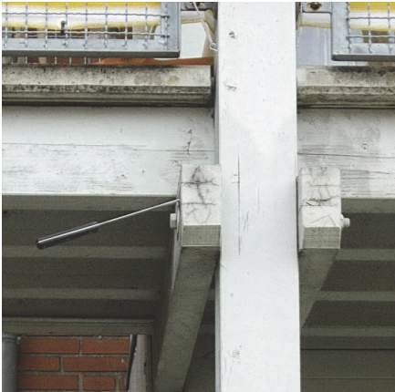
Bild 7 Zangenverbindung mit Einpressdübel. Niederschläge können ungehindert an den Knotenpunkt gelangen jedoch kaum abtrocknen. Ein Messer lässt sich mühelos in das faule Holz stechen.
