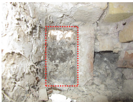
Bild 20 Blick von innen in die Auflage des Streichbalkens, Durchsicht bis auf den Estrich und nach außen nach Putzentfernung
