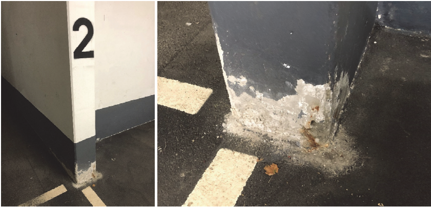
Bild 1 Typisches Schadensbild mit visuell erkennbarem Schaden am Stützenfuß
