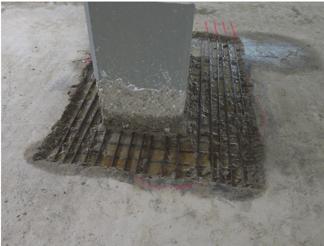
Bild 5 Schaden an der Deckenbewehrung
