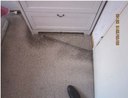
Bild 7 Abbildung der Luftströmung auf Teppich
