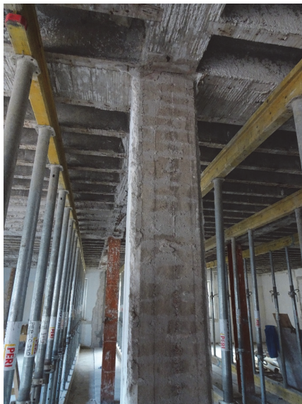
Bild 6 Ziegelsplitt im Ortbeton der Stützen (rechts Detail)
