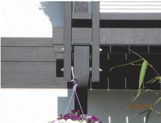
Bild 12 Brüstungspfosten als Zange mit Abstandhaltern aus Kunststoff vom Balken getrennt
