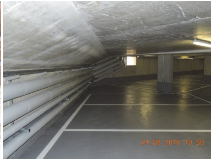
Bild 6 „Weiße Wanne“, Leitungsführung an der Außenwand
