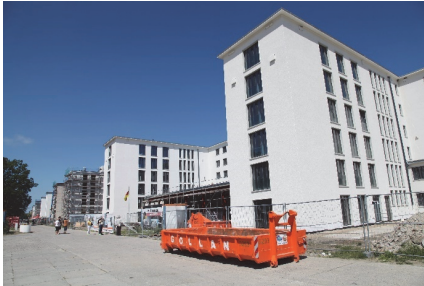
Bild 9 Juni 2015: Das Bauen in Abschnitten ist deutlich zu erkennen: im Vordergrund fertige Fassaden, dahinter eingerüstete Bereiche, im Hintergrund wieder fertig sanierte Abschnitte
