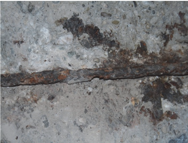
Bild 7 Lochfraßkorrosion im Detail
