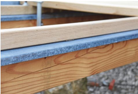
Bild 15 Abgedeckte Träger mit auf Abstandhaltern aufgelegten Unterkonstruktionshölzern und Dielen in dauerhafter Holzart (Foto: Robert Ott, Gammertingen).
