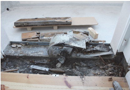
Bild 8 Rückbau von Schwelle und Dielung, alte Materialien unter der Schwelle
