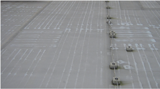
Bild 4 Auf einer alten Bitumenabdichtung geklebte PVC-Bahn (vlieskaschiert)
