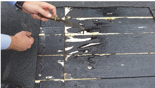
Bild 1 Dachöffnung – ölige, bitumenhaltige Substanz
