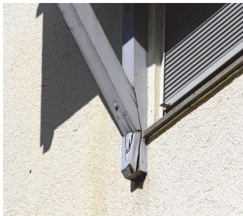
Bild 6 Im Knoten des Strebenfußes hat sich ein gefährlicher Fäulnis Schaden entwickelt (Foto: Robert Ott, Gammertingen).
