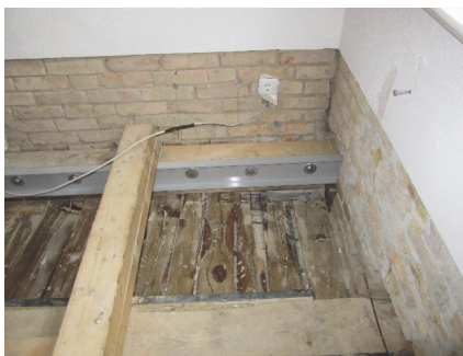
Bild 26 Streichbalken mit GFK und Füllholz
