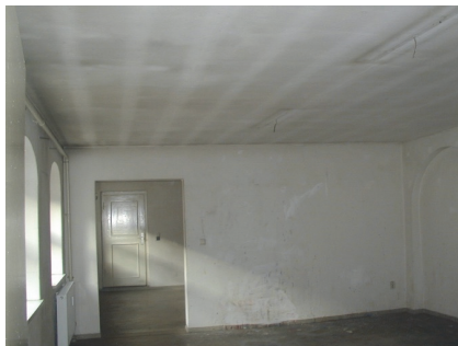
Bild 4 Sichtbare Deckenstruktur durch Fogging
