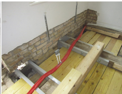
Bild 23 Anlaschung mit GFK-U-Trägern
