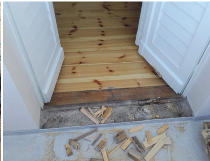
Bild 7 Ansicht nach Ausbau der Schwelle, erkennbare Aufkantung vor der Öffnung
