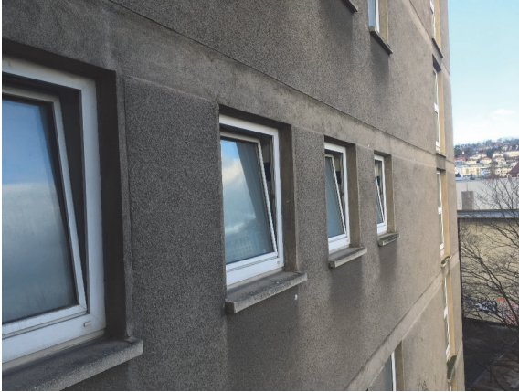
Bild 5 Originalputz (Kratzputz) von 1953 (Zustand 2018)
