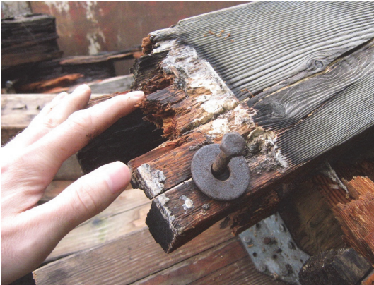
Bild 11 Pilzzerstörter Knotenpunkt zwischen Balken und Brüstungspfosten, obwohl relativ dauerhaftes Lärchenholz verwendet wurde.
