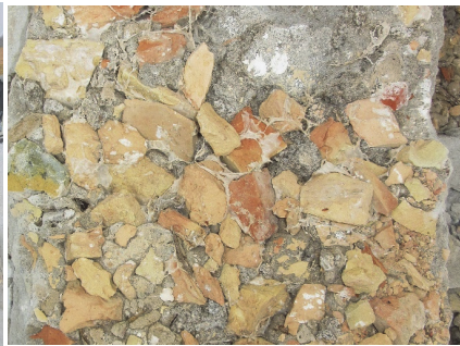
Bild 13 Ziegelsplittbeton vollständig mit Myzel durchwachsen
