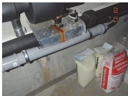
Bild 3 Diverse Undichtigkeiten der „Weißen Wanne“
