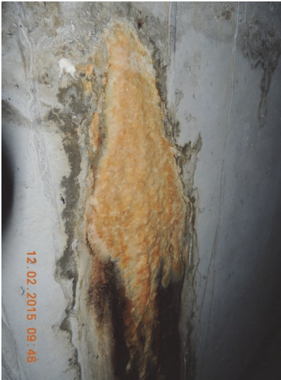
Bild 9 Schüttlagen = ungeplante Arbeitsfugen: undicht
