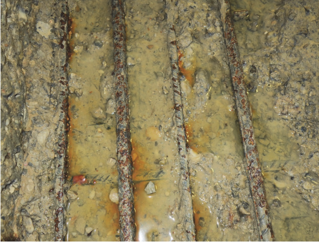
Bild 6 Typischer Schaden (Lochfraßkorrosion) infolge Chlorid-Einwirkung auf den Baustahl
