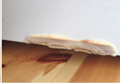
Bild 5 Fruchtkörper am Türblatt
