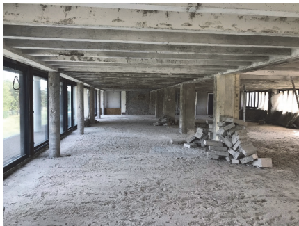
Bild 16 Decken der Liegehallen mit Rippenstruktur, links die historischen Stahlbetonsäulen
