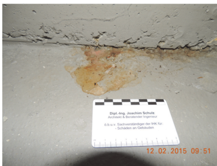
Bild 4 Wasseraustritt aus der Arbeitsfuge
