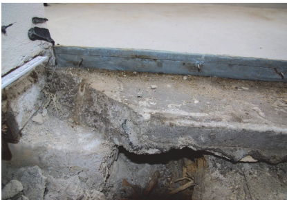
Bild 10 Balkenkopf unter dem Estrich der Tür mit Braunfäule
