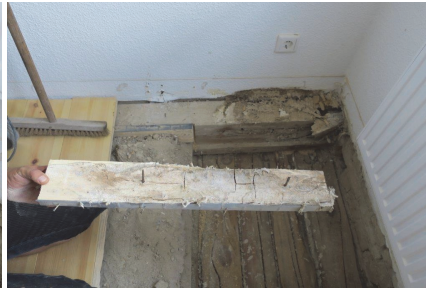
Bild 17 Bohlen aus der letzten Sanierung mit Myzel überwachsen
