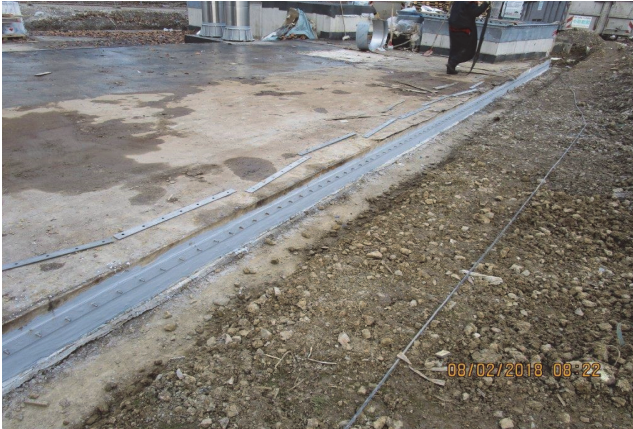
Bild 8 FLK als „Ersatz“ für Losfestflanschkonstruktion
