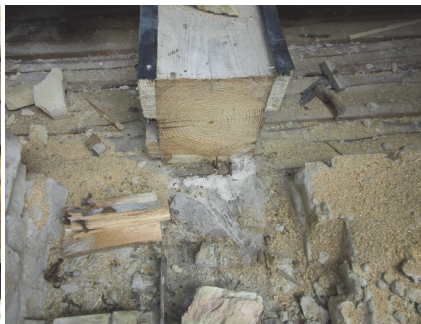
Bild 25 „Scheibchenweiser“ Rückschnitt
