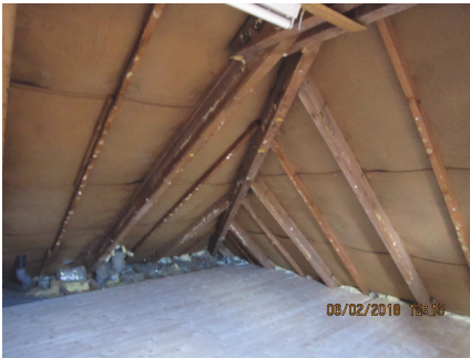
Bild 17 Dachgeschoß entkernt
