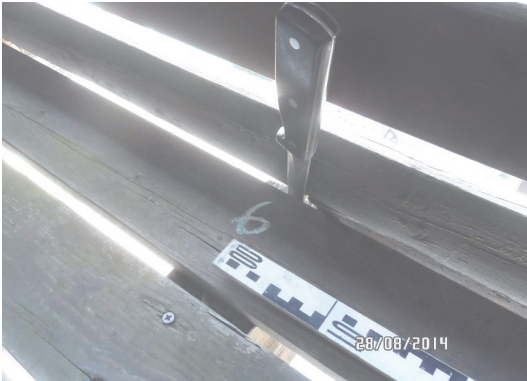
Bild 4 An der Oberseite des Balkenkopfs war das Holz bereits zerstört. Auffällig ist, dass zwischen Dielenbelag und Balken keinerlei Abdeckungen oder Abstandhalter angeordnet sind.
