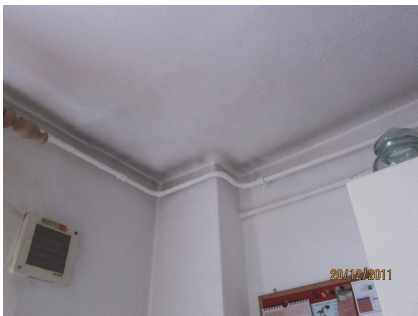
Bild 3 Fogging über dem Heizungsrohr
