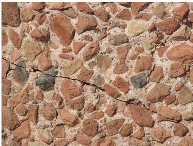
Bild 2 Detail des Zisternenputzes mit keramischen und natürlichen puzzolanischen Zuschlägen
