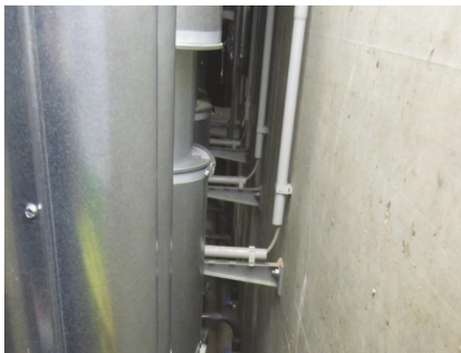
Bild 2 Leitungsführung nahe der Außenwand
