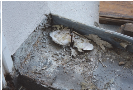
Bild 9 Detail der Einbaurichtung der Schwelle gegen Blech und Putz, Myzelwuchs
