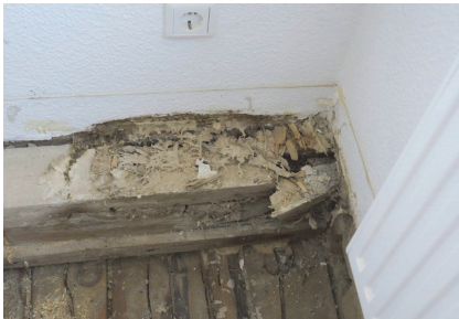
Bild 18 Balkenkopf vollständig bewachsen...
