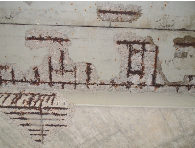
Bild 3 Typischer Schaden infolge Karbonatisierung und zu geringer Betondeckung
