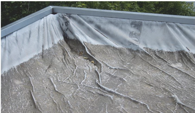
Bild 6 Flüssigkunststoff auf PVC-Altabdichtung
