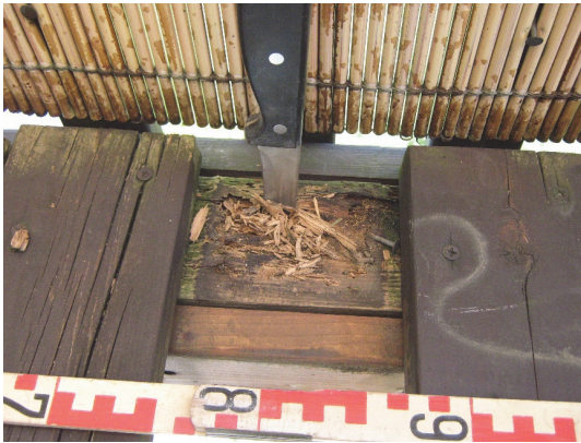
Bild 13 Übergang Diele-Balken ohne irgendwelche Feuchtschutzmaßnahmen. Das Holz ist durch Weißfäule zerstört. Wenn die Dielen hier versagen, können Personen abstürzen.
