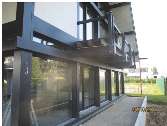
Bild 5 Auch dieser Dachüberstand kann nicht vor Bewitterung des Balkons schützen. Durchbindende Balken sind zusätzlich ungünstig.
