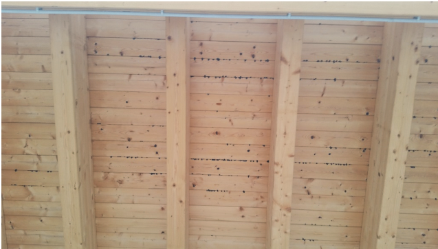
Bild 2 Ölige, schmierige, bitumenhaltige Substanz, die aus den Fugen tropft
