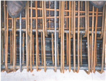
Bild 5 Wie soll der Beton verdichtet werden? Planung/Bauleitung
