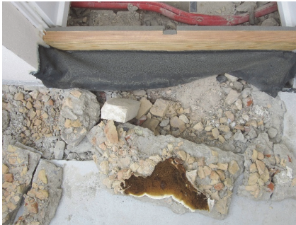
Bild 12 Frischer Fruchtkörper unter dem Estrich (Juni 2017)
