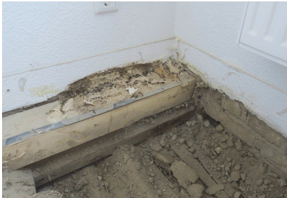
Bild 16 Streichbalken und Bohlen nach Entfernung der Dielung
