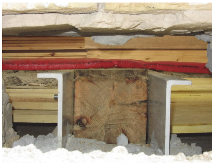
Bild 24 Ansicht von außen mit Doppellasse
