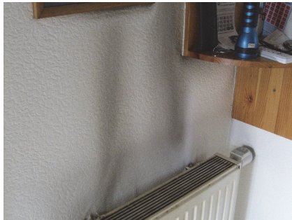
Bild 2 Flämmchenmuster über Heizkörper
