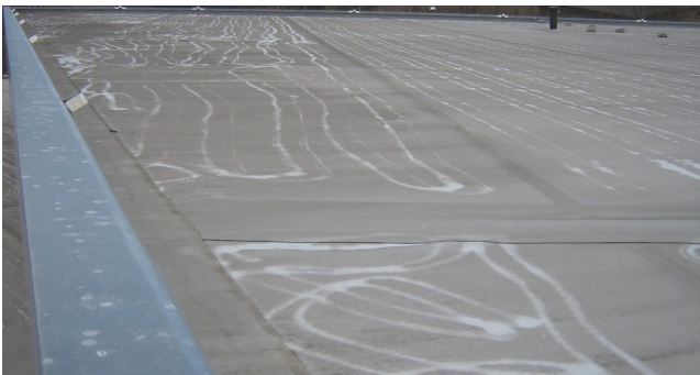
Bild 5 Auf einer alten Bitumenabdichtung geklebte PVC-Bahn (vlieskaschiert)
