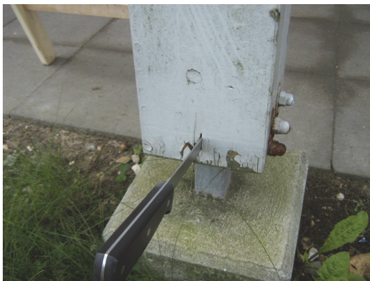
Bild 9 Stützenfuß im Spritzwasser
