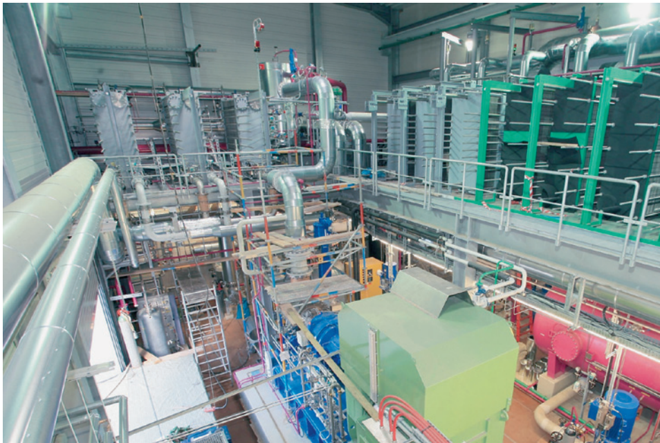
■ Abb. 51: Kalina-Turbine im Heizkraftwerk Unterhaching
