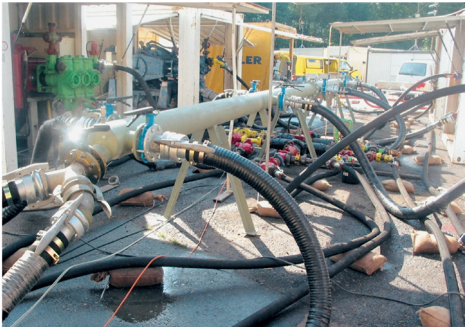
■ Abb. 32: Pumparbeiten zur Verbesserung der hydraulischen Durchlässigkeiten
