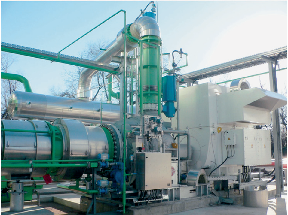
■ Abb. 80: ORC-Stromerzeugungsanlage des Projekts Landau, Mitte: Turbine, rechts: Generator
