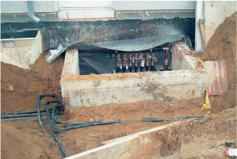
■ Abb. 111: Erdwärmesondenverteiler außerhalb des Gebäudes
