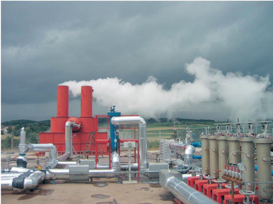
■ Abb. 84: Teil der Versuchsanlage für einen Zirkulationstests im Triplettsystem des Forschungsvorhabens Soultz. Rot: Separator, Silbergrauer Block im Hintergrund rechts: Wärmetauscher, vorn rechts: Filter
