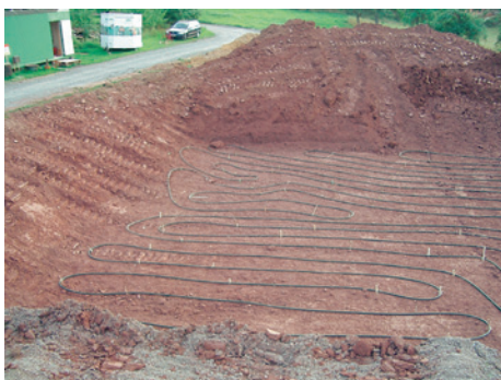
■ Abb. 117: Horizontalkollektor, verlegt auf abgeschobener Fläche
