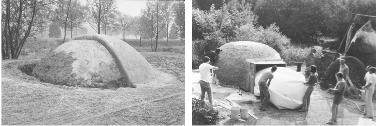
Abbildung 47: Versuchsanordnungen Islers mit unterschiedlichen Materialien. 138
