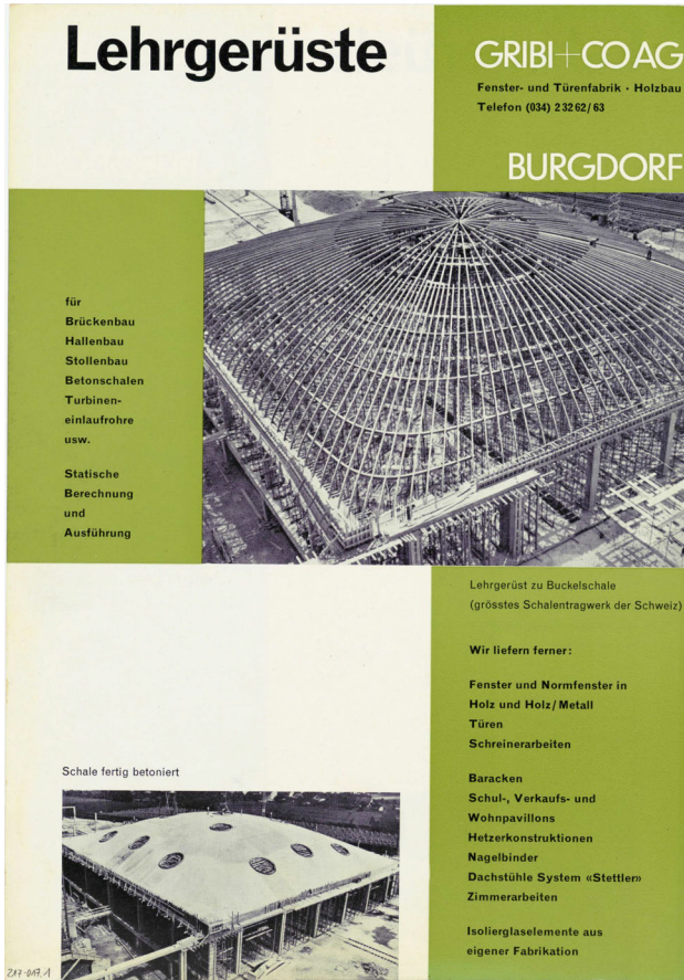
Abbildung 31: Das Werbeblatt der Firma Gribi, die die hölzernen Lehrgerüste für Isler-Schalen produzierte. 41
