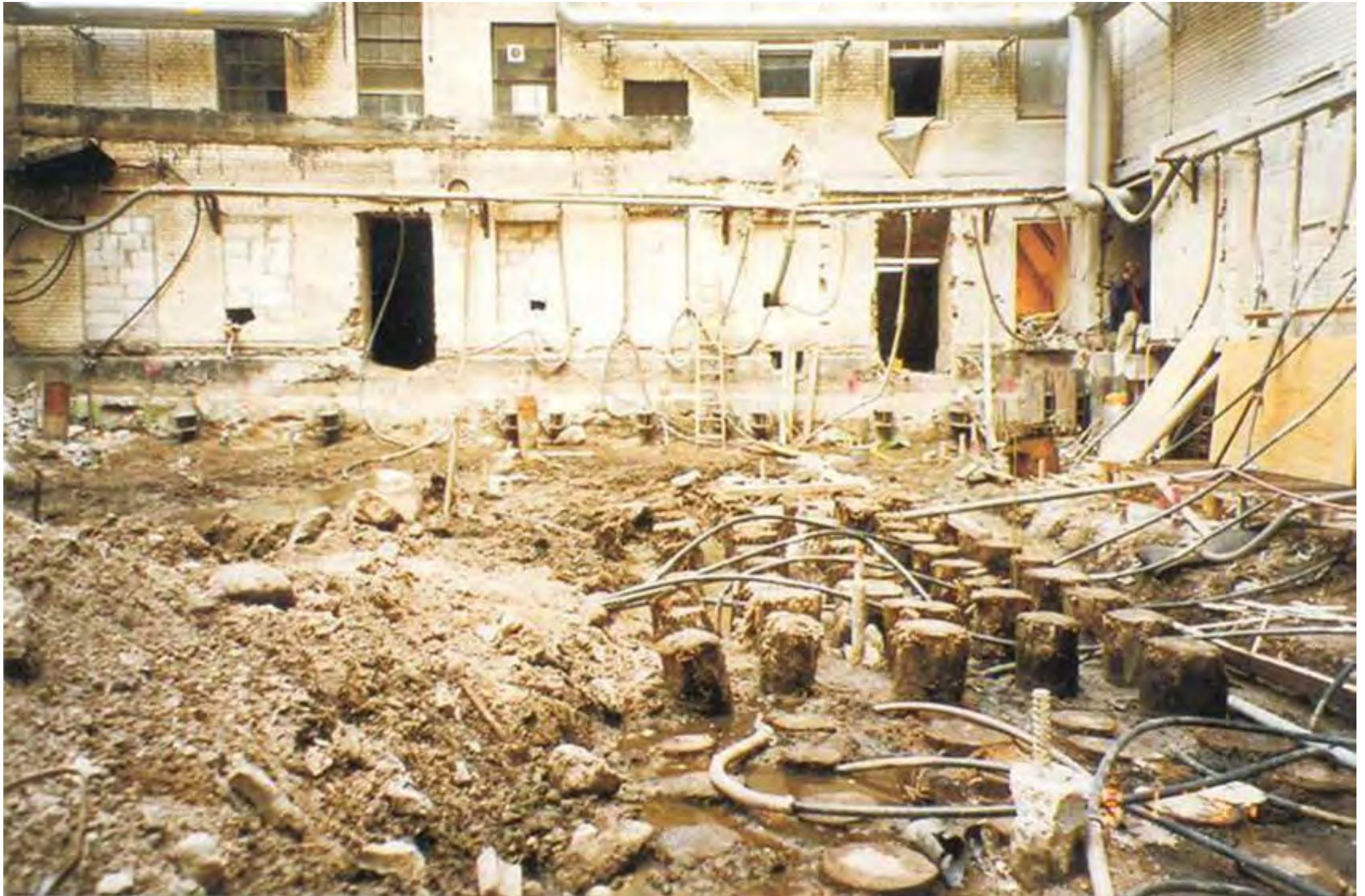
Abb. 3: Gründungssanierung, Freilegung der alten Kiefernpfähle
