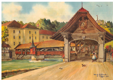
Abb. 4: Ansicht von Ulrich Gutensohn 1935: Nordportal der Spreuerbrücke mit der Verschalung der Bogenträger bis Brüstungshöhe und den damals noch bestehenden Bugstreben beim südlichen Widerlager
