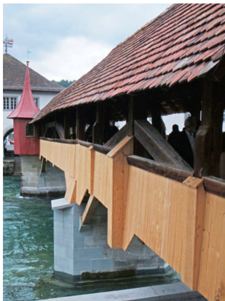
Abb. 70: ... und nach der Einhausung der Hängewerkzangen
