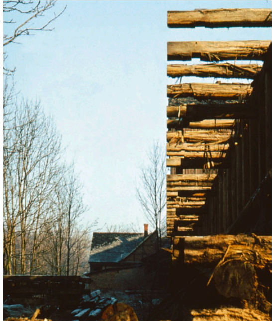
Abb. 11: Bad Sulza/Thür., »Holzkorrosion« durch Salzsole, hier an den Resten des (jüngeren) Reservoirs
