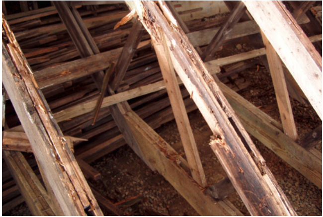
Abb. 9: Gitterträgerschäden 2006
