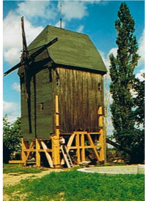
Abb. 6: Bockwindmühle 2004, Anbau der unteren Fachwerkwände, Umbau zum Paltrock
