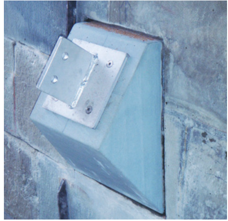
Abb. 39: Eingesetzte Konsole
