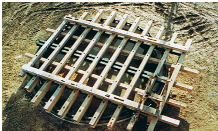
Abb. 7: untere Balkenlage (neues Fundament) 2004, Umbau zum Paltrock
