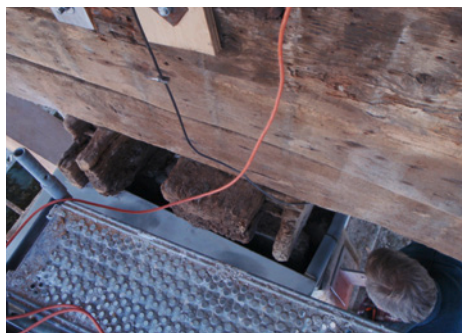
Abb. 10: Unter dem Zuggurt und Sattelholz schauen die beiden von 1450/55 stammenden Jochbalken hervor mit den Einhalungen für das Aufliegen auf den ehemaligen Pfahljochen
