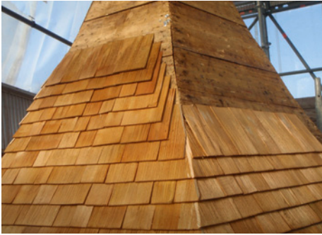
Abb. 84: Angeschlagene handgespaltene Schindeln
