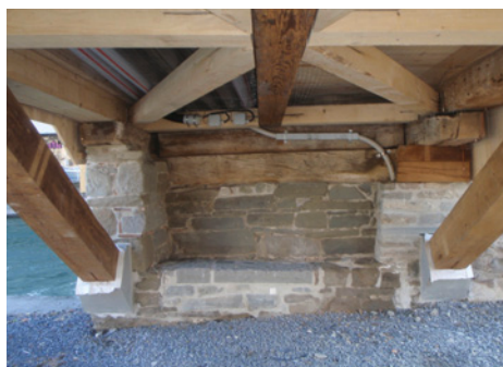
Abb. 64: Restauriertes Widerlager D auf der Insel mit neuen Bug-/Sprengwerkstreben des Brückenfeldes 3 auf die Sandsteinkonsolen und den Windverbänden zwischen Zuggurten und Mittellängsträger
