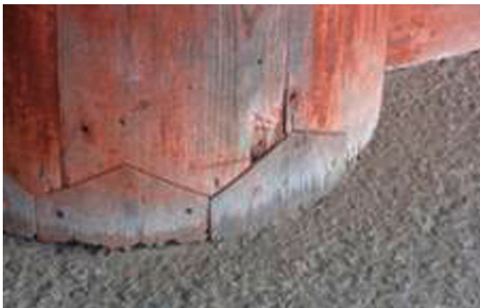
Abb. 19: Holzergänzungen im Fußbereich
