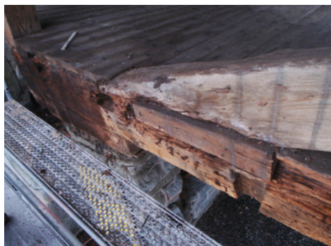
Abb. 35: Geschädigte Zuggurte im BF 3 Unterwasserseite
