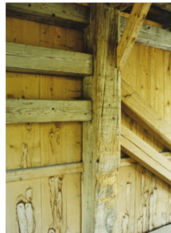
Abb. 13: Anschluss von Spannriegel und Streben
