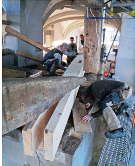
Abb. 46: Das Reparaturstück
