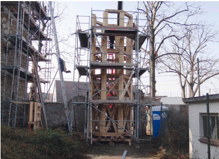
Abb. 9: Das Gestell der Laterne vor dem Turm montiert [Quelle: www. kirche. pißdorf.de]
