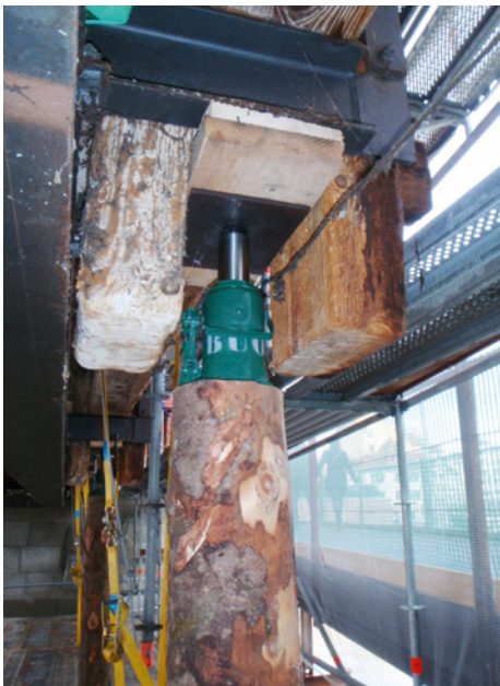
Abb. 43: Abspriegung einer Hängesäule
