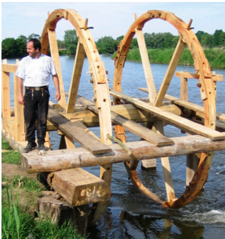
Abb. 10: Die zwei Radkränze sind zusammengebaut
