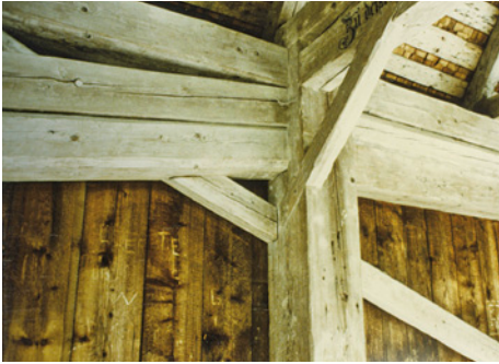
Abb. 21: Anschluss der Hängewerkstreben an einen Hängepfosten mit angeblatteter Gegenstrebe sowie eingearbeitetem Kopfband
