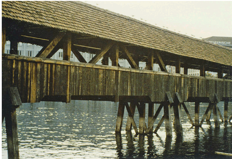
Abb. 6: Kapellbrücke Luzern; trapezförmige Joche und Durchfahrt- öffnung mit Hängewerk
