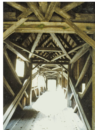
Abb. 20: Innenansicht der Tobelbrücke mit fünfseitigem Polygontragwerk
