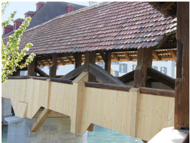
Abb. 10: Hängewerk Süd
