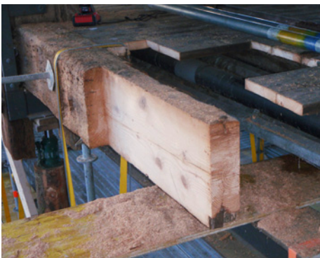
Abb. 47: Gesund geschnittener Zuggurt mit vorbereitetem Zapfen
