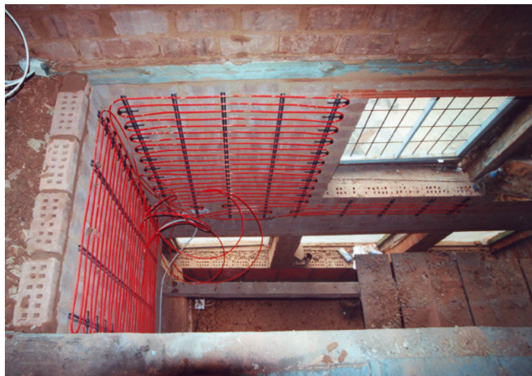
Abb. 14: Lehm-Innenschale mit Wandtemperierung
