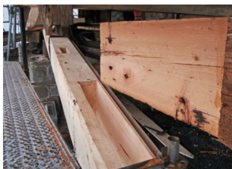
Abb. 62: Zuggurtreparaturstück Nord im Brückenfeld 3 wird eingesetzt
