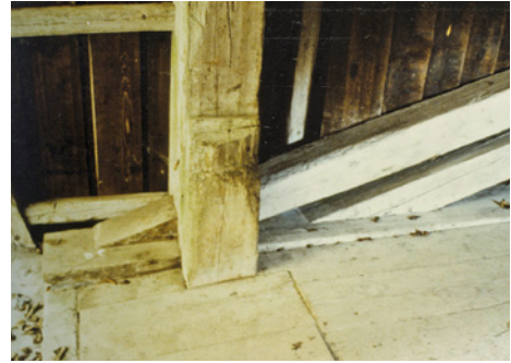
Abb. 22: Anschluss der Hängewerkstreben an den Streckbalken am massiven Endportal
