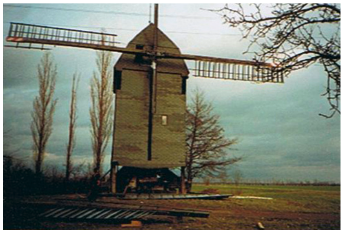
Abb. 5: Bockwindmühle 2002, Abnahme der restlichen Flügel (Sturmschaden)
