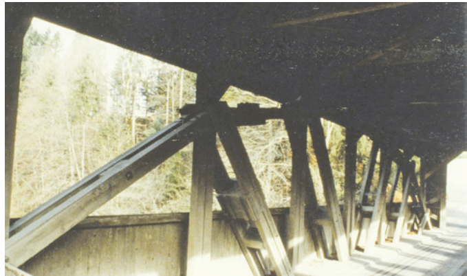
Abb. 45: Das stabbogenförmige Fachwerk der Sitterbrücke
