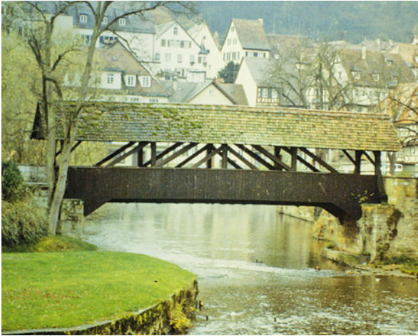
Abb. 15: Straßenbrücke mit Trapezhängewerken
