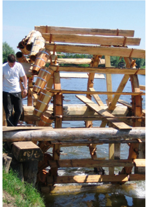
Abb. 13: Kümpfe, Schaufelbretter, Schöpftrog und Rinne sind montiert. Das Schöpfrad ist komplett eingehängt
