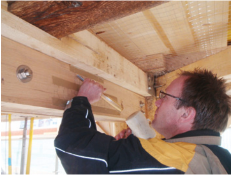
Abb. 77: Ein Zimmermann beim Schnitzen der Jahrzahl und Monogramme
