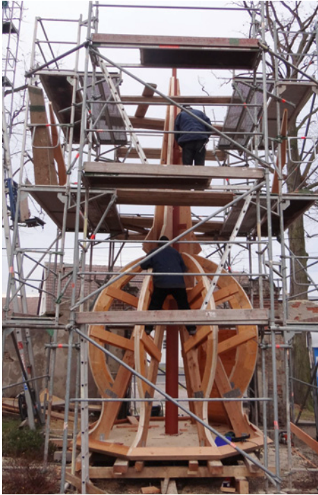
Abb. 12: Zimmermannsmäßiger Zusammenbau der Turmspitze [Quelle: www.kirche.pissdorf.de ]
