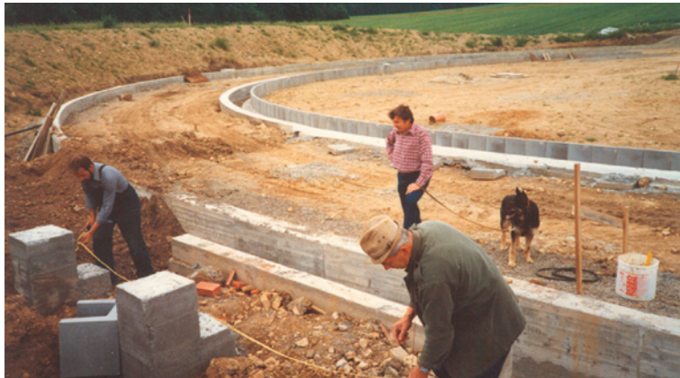
Abb. 3: Bahnfundamente 1985
