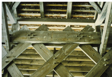
Abb. 41: Anschluss der Latten mit Holzdübeln
