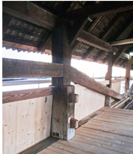
Abb. 56: Neuer Brüstungsriegel, Schalung und Boden BF 1 mit den Latten eingebaut
