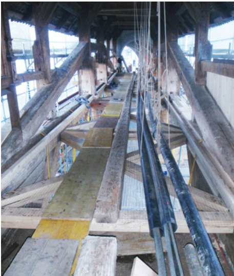
Abb. 55: Brückenfeld 1 mit dem Taubenschutz auf den Windverbänden
