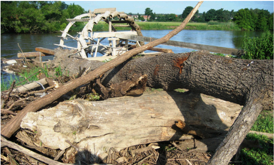
Abb. 2: Durch Hochwasser und mitgeführtes Treibholz beschädigtes Wasserschöpfrad
