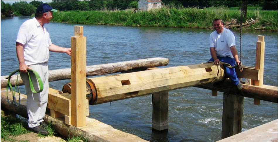
Abb. 7: Die Welle ist eingebaut und ausgerichtet. Gut erkennbar sind der Wellenzapfen mit Schrumpfung und die Löcher zum Aufnehmen der Arme
