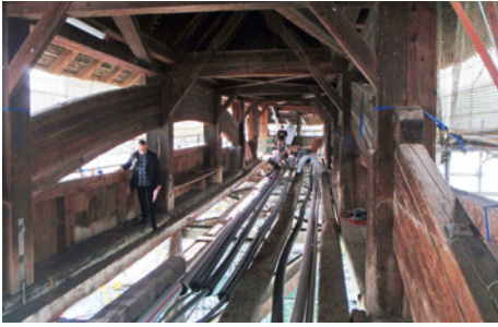
Abb. 65: Bogenbrücke während der Instandsetzung, die Trägerbalken werden neu fixiert
