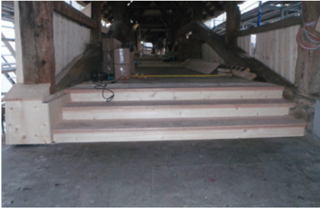
Abb. 57: Die drei neuen Tritte vom Widerlager Süd auf die Brücke
