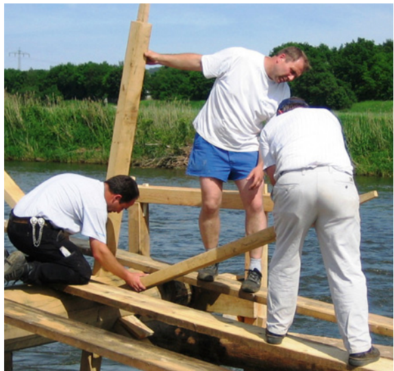
Abb. 7: Die Welle ist eingebaut und ausgerichtet. Gut erkennbar sind der Wellenzapfen mit Schrumpfung und die Löcher zum Aufnehmen der Arme
