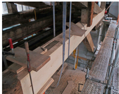
Abb. 48: Das eingepasste Reparaturstück des Zuggurts vor der Verbohrung für die Passbolzen
