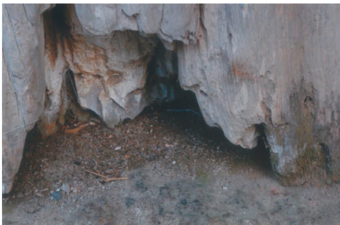
Abb. 18: Fäulnissschaden
