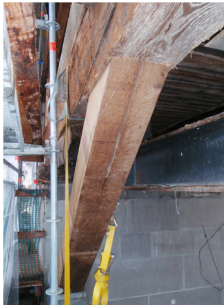
Abb. 44: Neu eingesetzte Bug- / Sprengwerkstrebe
