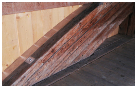
Abb. 68: Die neu gegen Ausknicken verschraubten Bogenträger
