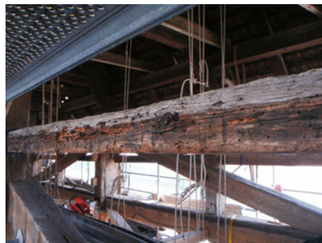
Abb. 9: Brüstungsriegel mit den Zeichnungen der Wandschalung
