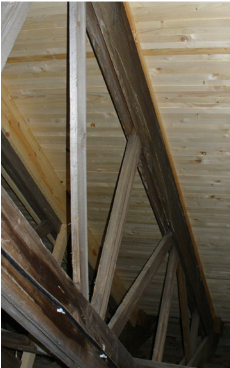
Abb. 13: Fachwerkträger mit Belag 2009
