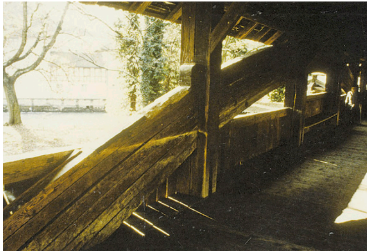
Abb. 26: Lamellenbogen der Spreuerbrücke aus sechs übereinander liegenden, unverbundenen Balken; Verspannung des Bogens an Hängepfosten mit großen Holzkeilen
