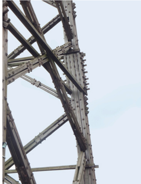
Abb. 25: Turmverschraubungsdetails
