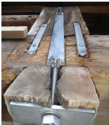
Abb. 61: ... an den Hängesäulen des Brückenfeldes 2 eingebaut
