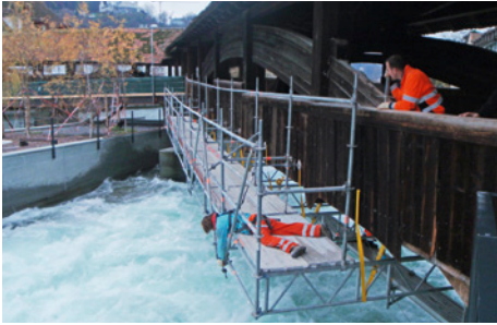
Abb. 31: Das Hängegerüst an der Bogenbrücke entsteht.
