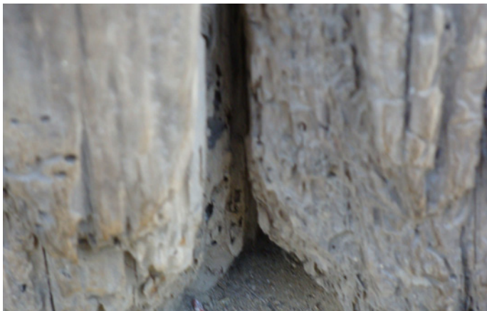
Abb. 17: Fäulnis und Insektenbefall
