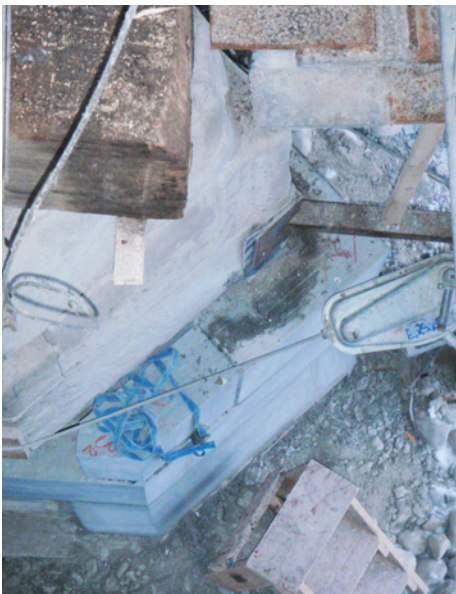
Abb. 40: Die oberwasserseitige Verlängerung des Pfeilers C in Arbeit ...
