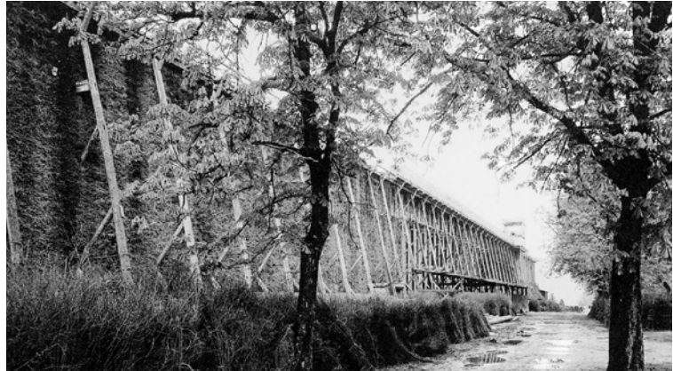
Abb. 4: Gradierwerk mit innen verstreben Gebinden in Bad Kösen/ Sa.-Anh.
