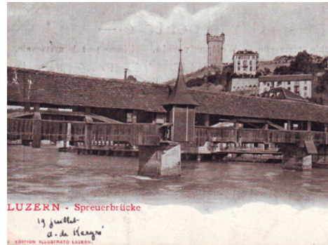
Abb. 3: Die Postkartenaufnahme zeigt, wie viel um diese Zeit noch auf der Oberwasserseite zugeschalt war.
