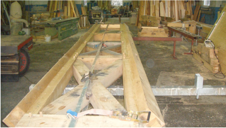
Abb. 8: Vorbereitung der Laterne in der Werkstatt [Quelle: Zimmerei und Holzbau Meissner GmbH]
