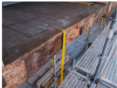
Abb. 34: Geschädigte Zuggurte im mittleren Brückenfeld
