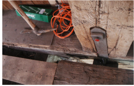
Abb. 66: Neue Chromstahlteile zur Aufhängung der Unterbrücke an die Hängesäulen der Bogenbrücke
