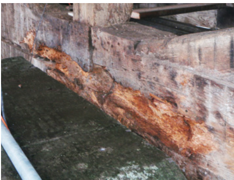
Abb. 33: Nach Zurückschneiden der Mauerabdeckung Einsicht an die massiv geschädigten Zuggurtenkopfteile
