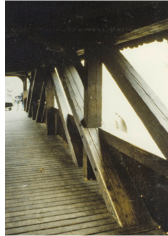
Abb. 16: Anschluss von Spannriegel und Streben
