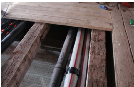
Abb. 67: Bodeneinbau, elektrische Leitungen erhielten neue Schutzrohre, Taubenschutz neu eingebaut
