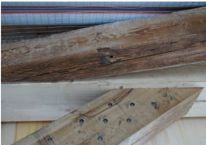
Abb. 7: Bugstrebenanschluss
