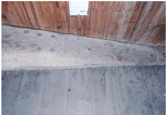
Abb. 20: Mit Flickzapfen abgedeckte Spaxschraubenverstärkungen
