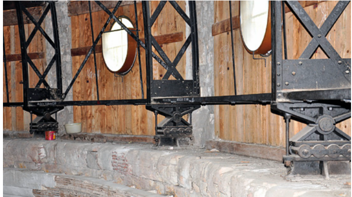
Abb. 8: Fußpunktverankerung der Fachwerkträger
