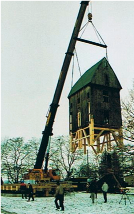
Abb. 8: Kraneinsatz am 26.01.2005, Umbau zum Paltrock
