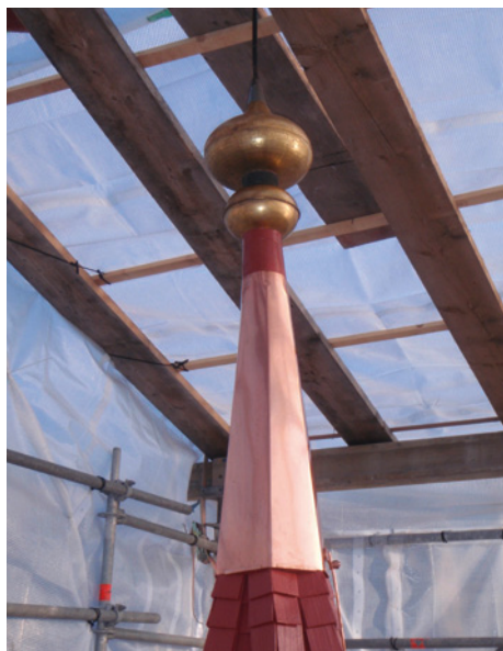
Abb. 88: ... und mit Kupferhut als Schindelabschluss
