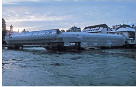
Abb. 32: Die ganze Brücke ist eingestüst.
