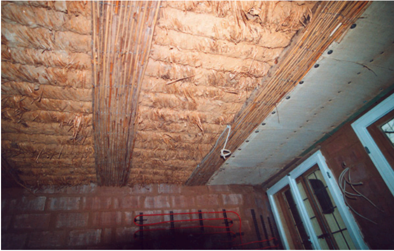
Abb. 17: Lehmdecke mit Holz-Stroh- lehmstakung
