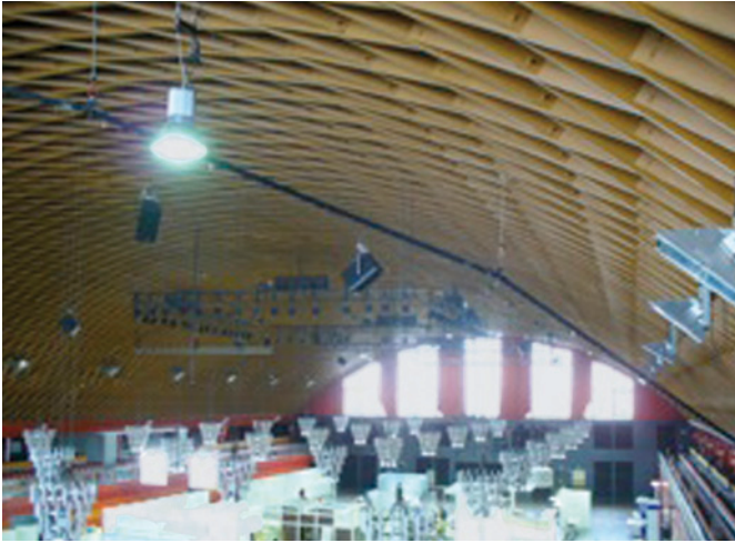
Abb. 19: Tragwerk von unten
