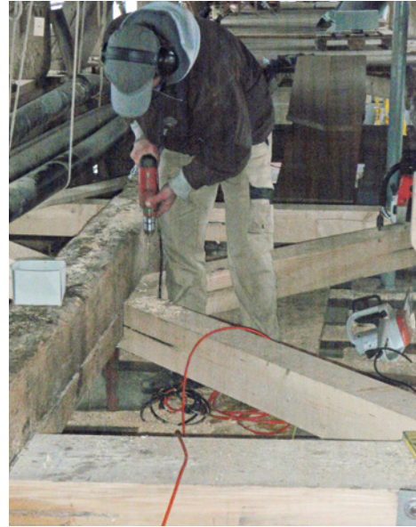
Abb. 53: ... und Fixieren der Windverbände
