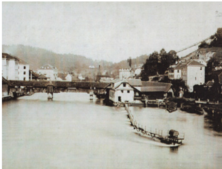
Abb. 2: Fotografie von der Reussbrücke in Richtung Westen nach 1875, vor 1890 zeigt, dass die Unterwasserseite bis zum Dachansatz verschalt war.
