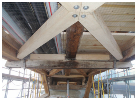
Abb. 59: BF 2 mit verstärktem Windverband und den neuen Bug-/Sprengwerkstreben
