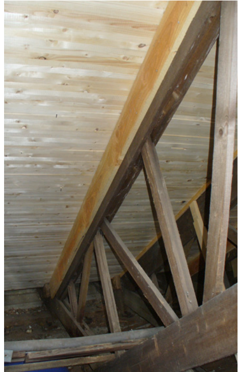
Abb. 15: Gitterträger- verstärkung 2009
