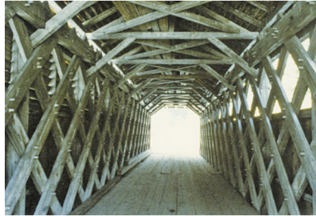
Abb. 39: Innenansicht mit Gitterträgern und Dachraum mit oberem Windverband
