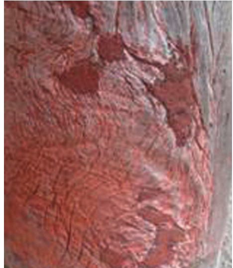
Abb. 21: Holzergänzung mit mineralischem Mörtel
