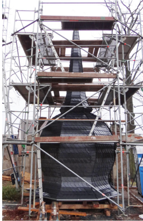
Abb. 13: Die auf dem Montageplatz fertiggestellte Turmspitze ist bereit für den Kran [Quelle: www.kirche.pissdorf.de ]
