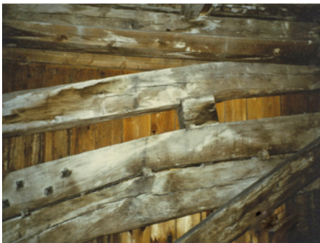
Abb. 30: Aus je drei kurzen, natürlich gekrümmten Balkenstücken zusammengesetzter Bogen; zwei Balken verdübelt, der dritte einzeln mit Abstandsholz
