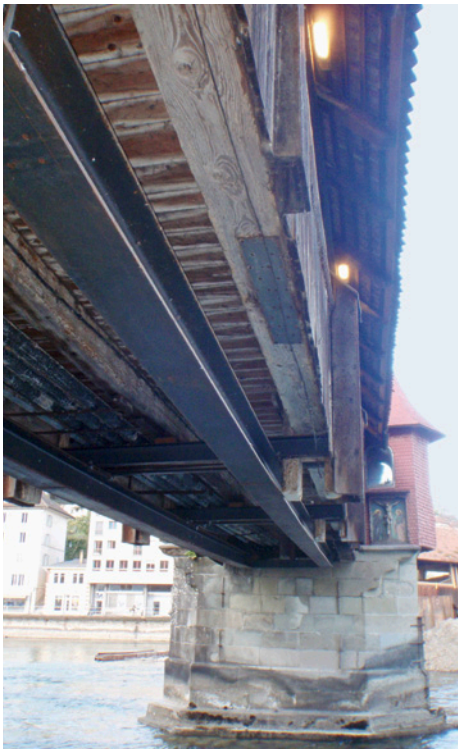
Abb. 16: Längsträger unter Brückenfeld 1
