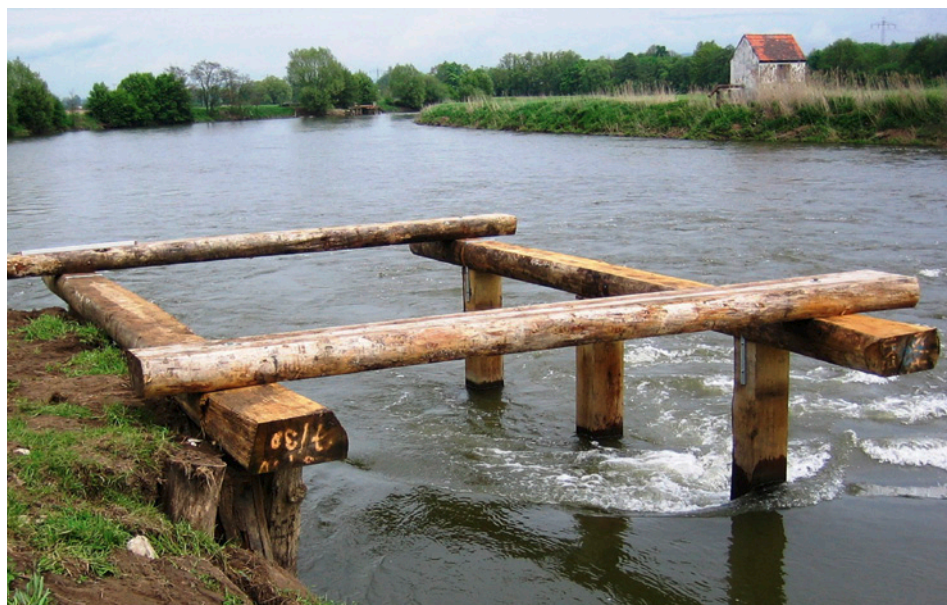
Abb. 5: Eine Radstatt bleibt für 10 bis 15 Jahre im Fluss. Am anderen Flussufer ist eines der Pumpenhäuser zu sehen
