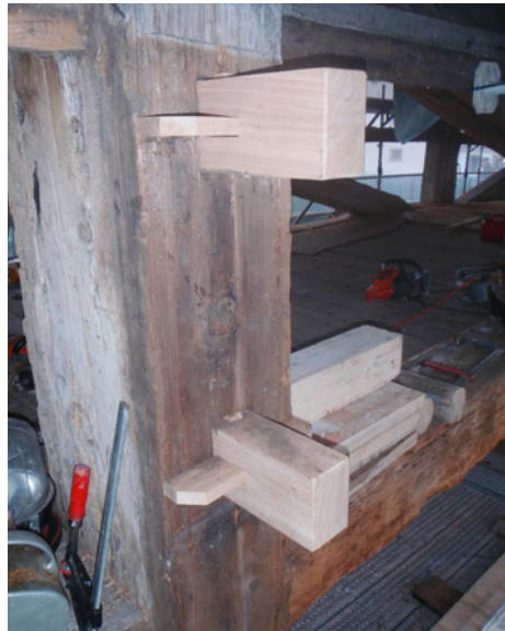
Abb. 51: ... und mit den Tragbolzen und Keilen auf der Außenseite
