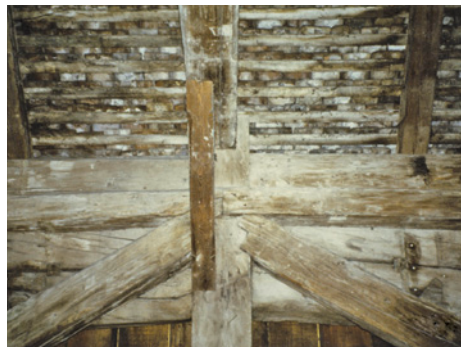
Abb. 31: Versatzartiger Anschluss der Fachwerkstreben
