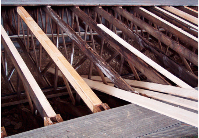
Abb. 10: Gitterträgerreparatur 2006
