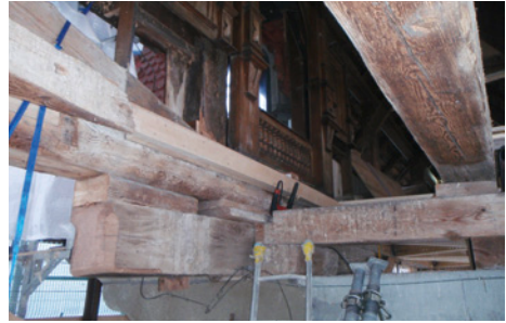
Abb. 58: Zurückgeschnittenes, überlanges Sattelholz bei Pfeiler B
