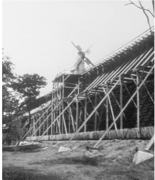
Abb. 7: Zweistöckig abgebundenes Gradierwerk der einstigen Saline in Schönebeck/Sa.-Anh.
