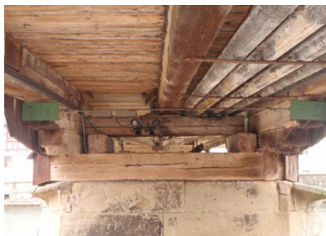
Abb. 11: Pfahljochbalken als Schwelle auf Pfeiler C
