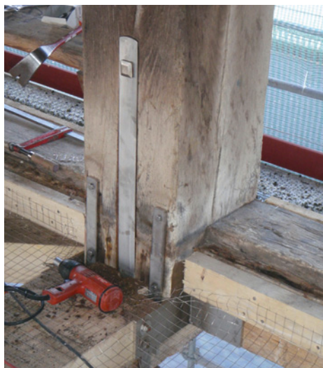
Abb. 60: Die neuen Aufhängungen in Chromstahl sind an den Hängesäulen ...
