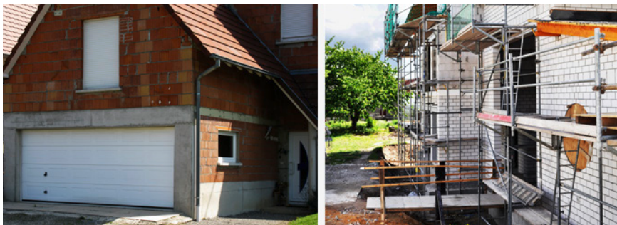
Bild 6.1 Mauerwerk aus Ziegeln (links) und Kalksandstein (rechts)
