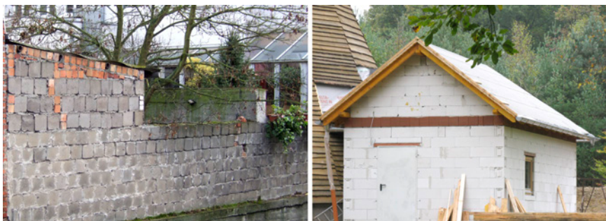
Bild 6.2 Mauerwerk aus Betonsteinen (links) und aus Porenbetonsteinen (rechts); das Häuschen rechts wird noch mit Holz verkleidet
