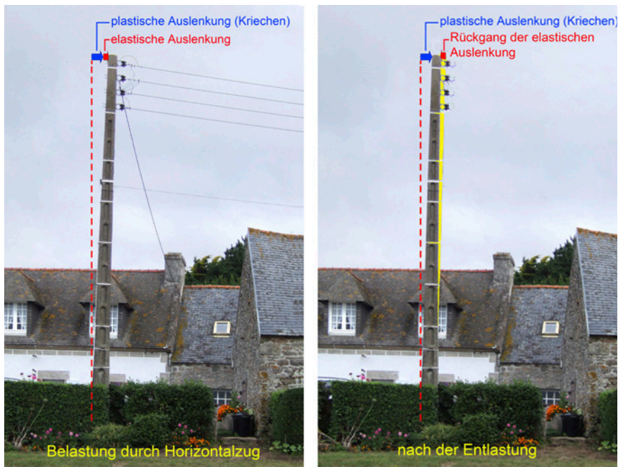
Bild 4.8 Kriechverformung eines Stahlbetonmastes für die Stromversorgung unter Last und nach der Entlastung; rechtes Foto etwas verändert
