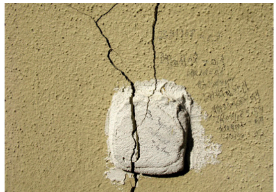
Bild 9.13 Messmittel für Rissufernverschiebungen: Rissmonitor (links oben), darunter ungerissene Gipsmarke, rechts gerissene Gipsmarke
