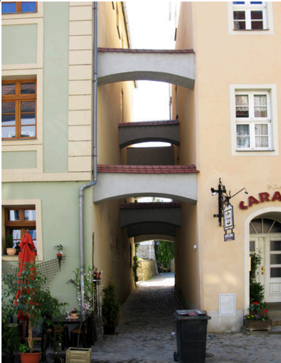
Bild 6.31 Stützbögen zwischen zwei Häusern dienen ebenfalls zur Gebäudeaussteifung
