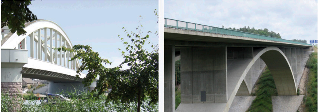
Bild 1.6 Bogenbrücken aus Stahlbeton; links mit angehängter und rechts mit aufgeständerter Fahrbahn
