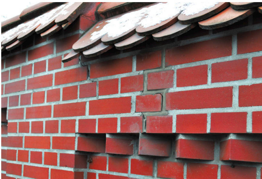
Bild 6.7 Die Bewegungsfuge entsteht bei Ersatz des Mörtels durch eine elastische Fugenmasse
