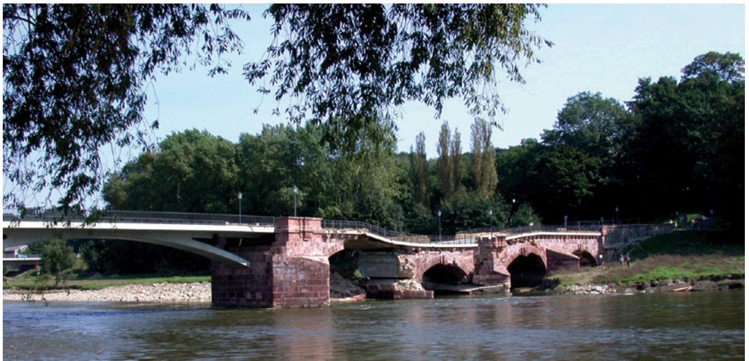
Bild 4.18 Beim August-Hochwasser 2002 unterspülte Pfeiler einer Muldebrücke in Grimma führten zur »ungleichförmigen Stützensenkung« und damit zum teilweisen Einsturz der Brücke
