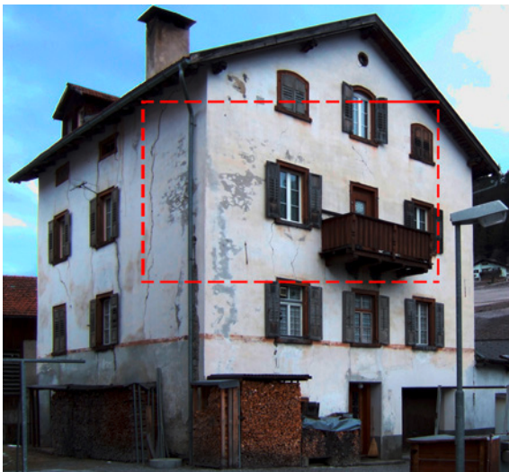
Bild 2.27 Wohngebäude mit Rissen in den Außenwänden, die aus einem gewissen Abstand kaum zu sehen sind
