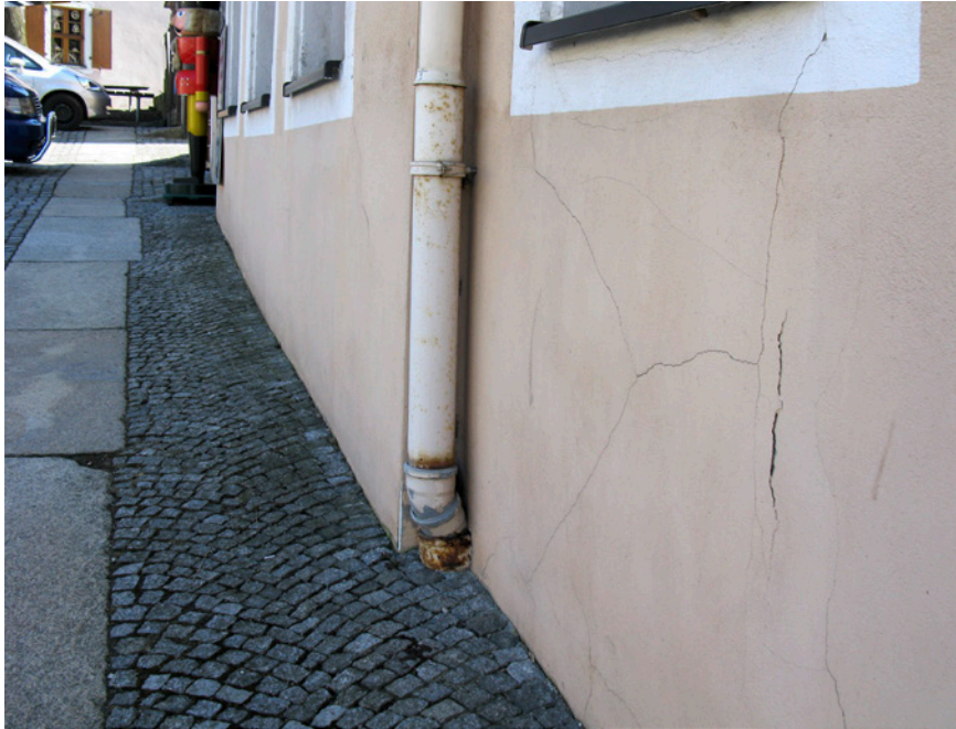
Bild 6.9 Putzrisse erkennt man an ihrer ungerichteten Verteilung und am hohlen Klang beim Klopfen
