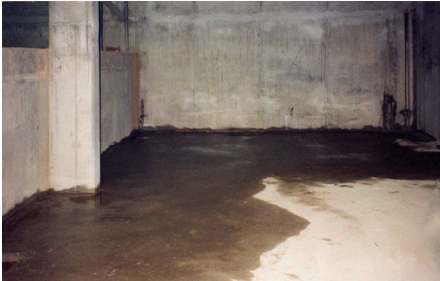
Bild 5.13 Undichte Arbeitsfuge einer Tiefgarage im Grundwasser
