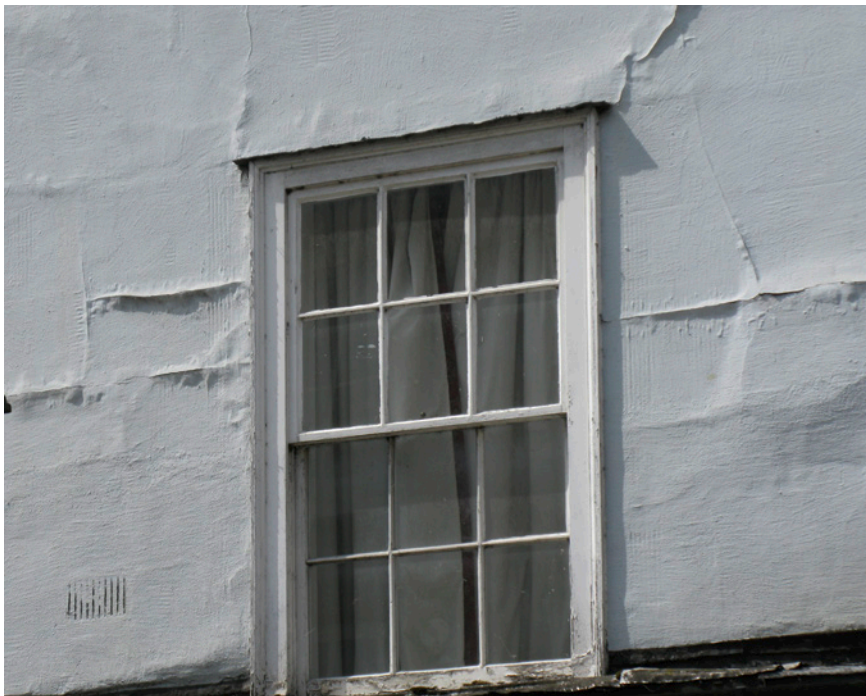
Bild 6.10 Putzrisse und andere Putzschäden
