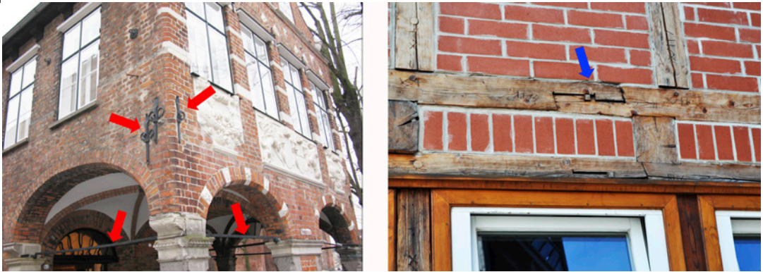
Bild 2.10 Zugelemente in einem Mauerwerksbau (links) als Maueranker und freiliegende Bogenzugbänder und in einem Fachwerkbau (rechts) als zugfester Balkenstoß
