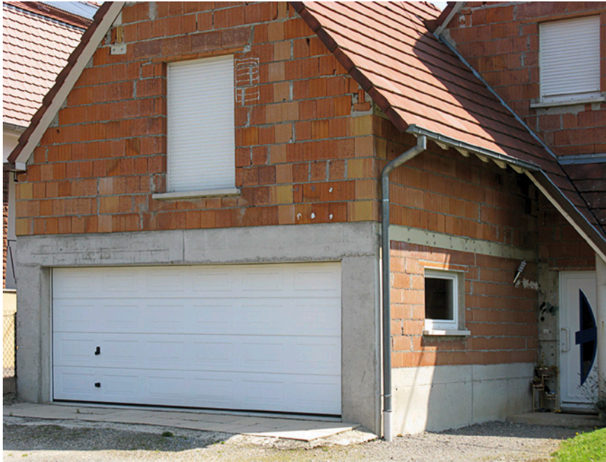
Bild 8.12 Beton und Ziegel- mauerwerk im direkten Kontakt
