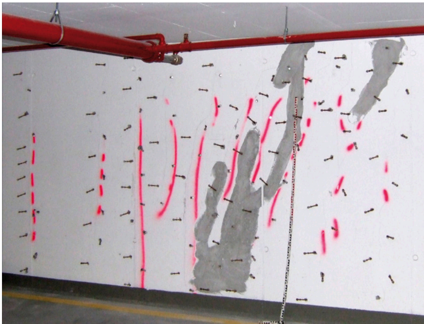
Bild 9.3 Zahlreiche Packer an feinen Rissen in einer neuen Tief- garage
