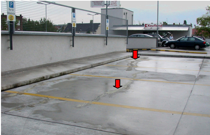
Bild 4.3 Parkplatz- befestigung aus unbewehrten Betonplatten auf dem Dach eines Super- marktes mit Längsrisse in der Mitte der Plat- ten mit einer Seitenlänge von fünf Metern
