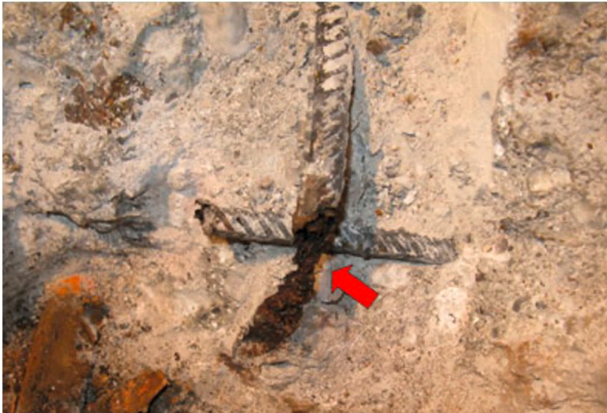
Bild 2.25 Durch Korrosion zerstörter Bewehrungsstab in der Bodenplatte einer Tiefgarage (ursprünglicher Stabdurchmesser 8 mm)
