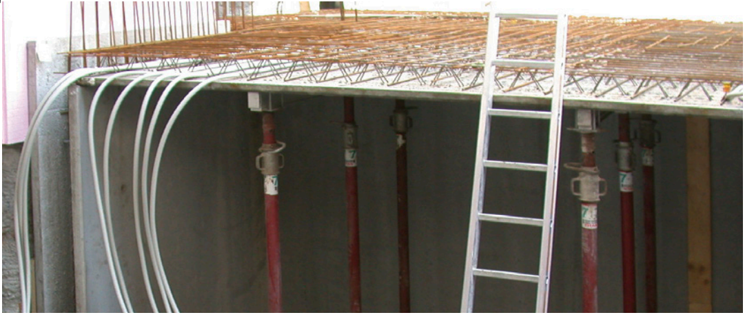
Bild 5.17 Element- decke vor dem Betonieren
