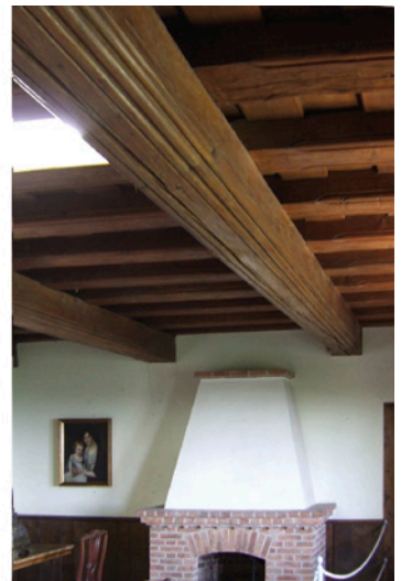
Bild 1.11 Risse in Holzfachwerk und in einer Holzbalkendecke
