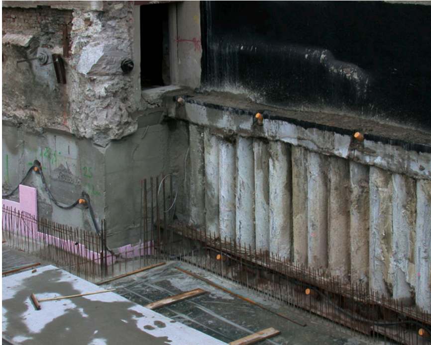
Bild 4.17 Sicherung einer tiefen Baugrube an einer bebauten Grundstücksgrenze mit einer Bohrpfehlwand
