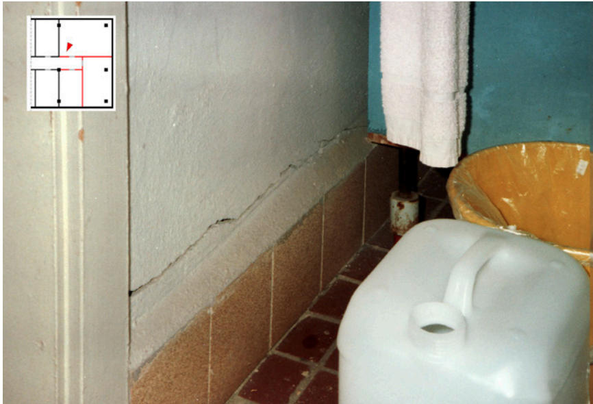
Bild 6.47 Horizontaler Abriss des unteren Wandteils etwas oberhalb der Decke; links im Bild eine Türöffnung mit Türrahmen
