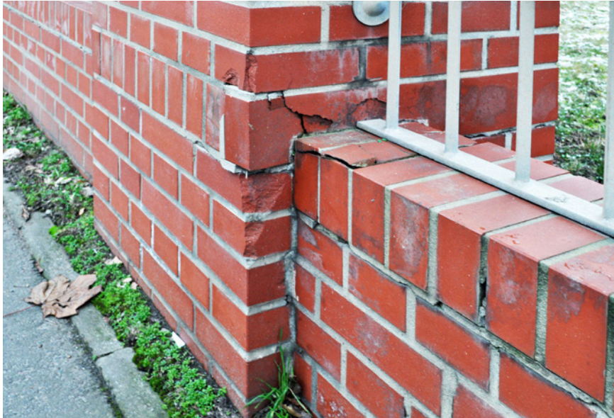
Bild 6.6 Lokale Zerstörung des Mauerwerks durch die feste Verbindung von Metallgitter und Mauerwerk
