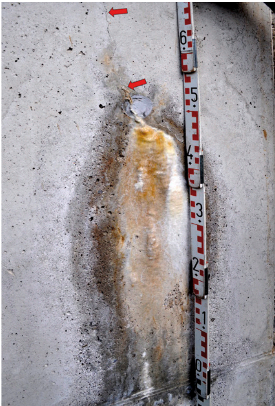
Bild 7.7 Wasser- führender Riss in der Wand eines Nachklär- beckens mit Aussinterungen
