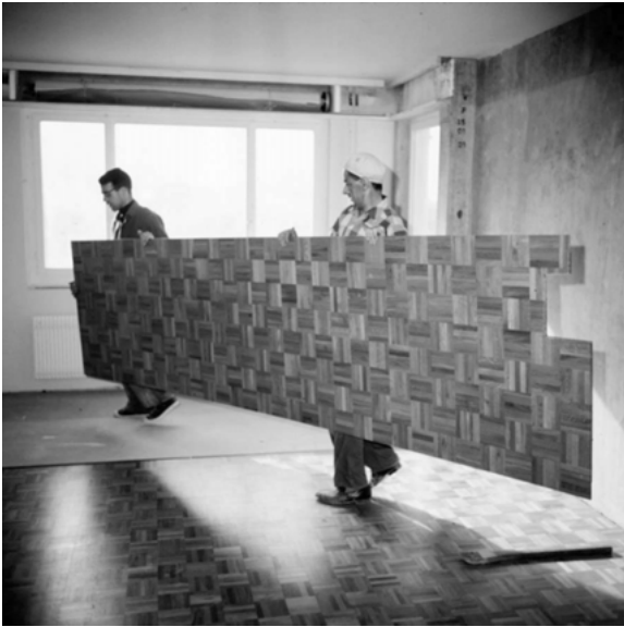
Abbildung 8: System Göhner, vorgefertigter Bodenbelag, September 1966
