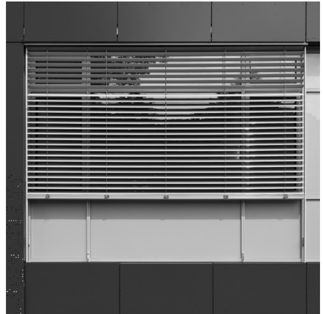
Abb. 2.3-21: Unterschiedliche Betriebsweisen von Lamellenraffstores: vollständig geschlossen (links), Cut-off -Betrieb (rechts), Lichtlenkung im oberen Behangteil (nächste Seite links) und Lichtlenkung im oberen Behangteil bei ungestörter Aussicht im unteren Behangteil (nächste Seite rechts).
