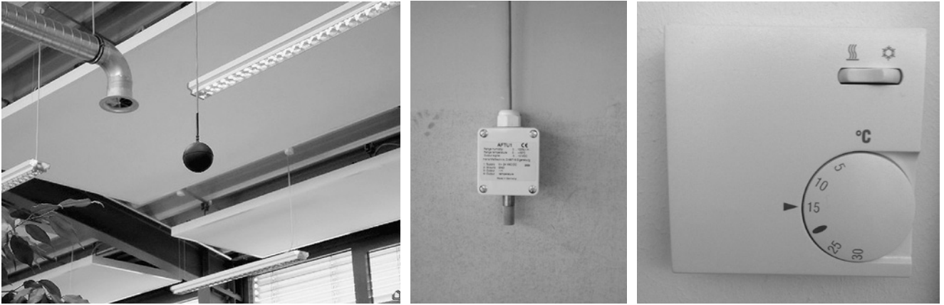
Abb. 2.1-21: Installierte Messtechnik für operative Raumtemperatur und relative Luftfeuchte.
