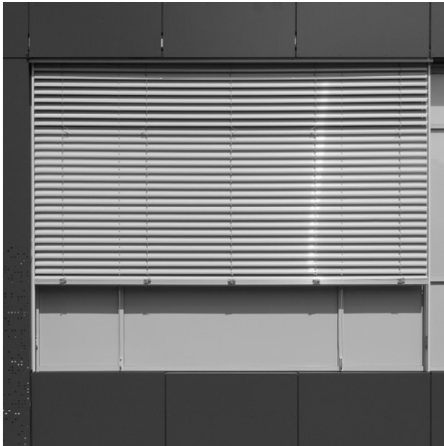
Abb. 2.3-21: Unterschiedliche Betriebsweisen von Lamellenraffstores: vollständig geschlossen (links), Cut-off -Betrieb (rechts), Lichtlenkung im oberen Behangteil (nächste Seite links) und Lichtlenkung im oberen Behangteil bei ungestörter Aussicht im unteren Behangteil (nächste Seite rechts).
