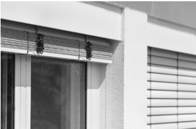
Abb. 2.5-3: Zusammengebundene und damit blockierte Sonnenschutzeinrichtung als Beispiel für »Sabotagemassnahmen« an automatischen Systemen.
