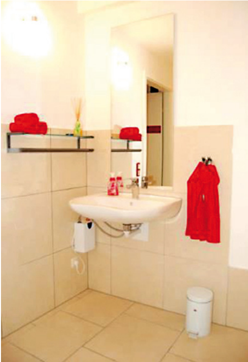
Abb. 7: Beispiel eines unterfahrbaren Waschtisches
