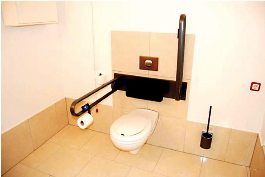
Abb. 6: Beispiel eines WC für Rollstuhlnutzer mit beidseitig anfahrbarer Bewegungsfläche und Stützklappgriff
