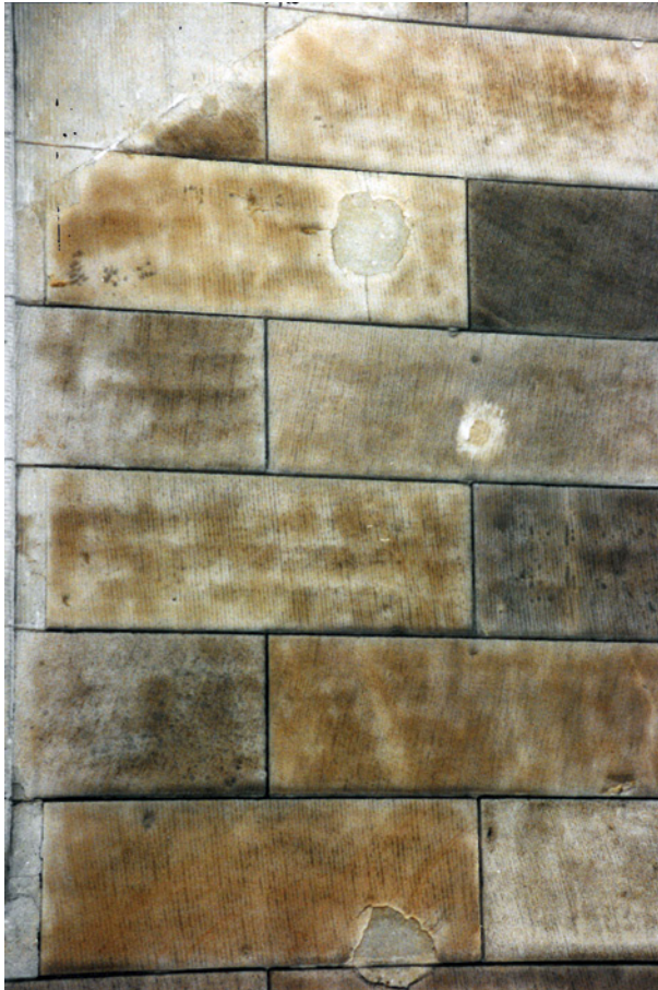
Bild 43 ■ Fleckenartige Verfärbung durch unterschiedlich abgebautes Hydrophobierungsmittel
