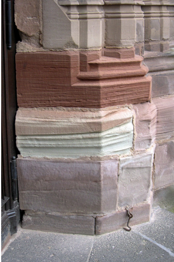
Bild 50 ■ Schichtparallele Reliefbildung durch Herauswittern weicherer, toniger Lagen
