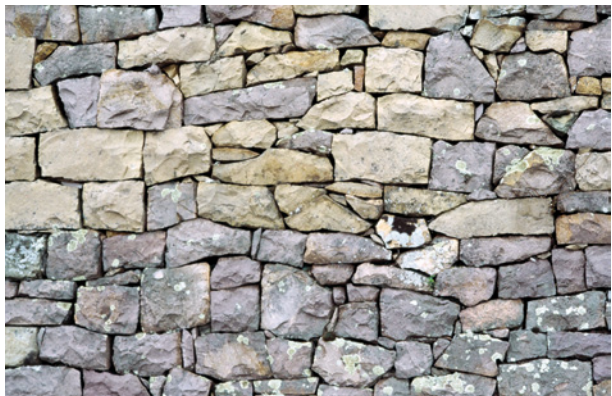
Bild 1 ■ Beispiel eines Trockenmauerwerks
