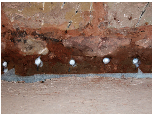
Bild 20 ■ Injektionslöcher, verfüllt mit Imprägniercreme. Das Foto zeigt eine Mauerwand mit mehreren horizontalen Bohrlöchern. Die Löcher sind mit einer hellen, cremefarbenen Substanz (Imprägniercreme) verfüllt. Die Mauer selbst ist hellbraun und zeigt einige Risse.
