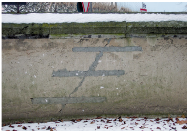
Bild 24 ■ Verklammerung eines durchgehenden Mauerrisses
