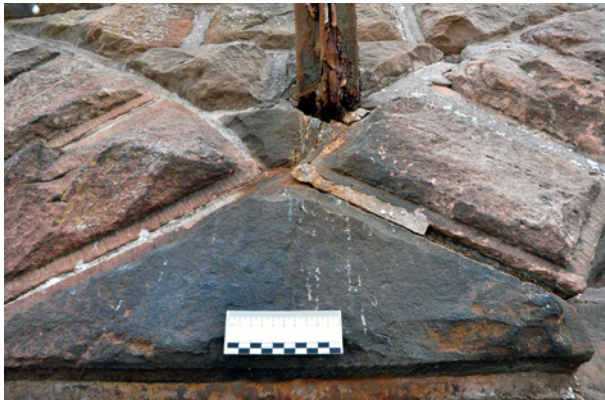
Bild 111 ■ Durch die Korrosion der Metalleinbindung entstanden Risse, Verfärbung der Gesteinsoberfläche und Fugenausbrüche
