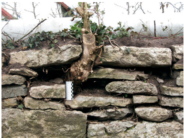
Bild 30 ■ Zerstörung des Mauerwerks durch Baumbewuchs
