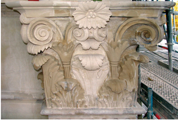
Bild 14 ■ Kapitell mit eingesetzten Vierungen
