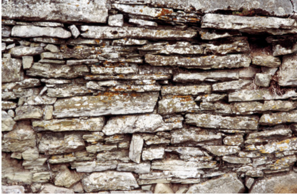
Bild 2 ■ Beispiel eines Bruchsteinmauerwerks
