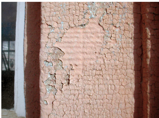
Bild 87 ■ Farbablösung mit krakeleeartigen Rissen eines dampfdichten Anstrichs
