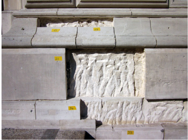
Bild 13 ■ Einsatz von Platten am Sockelmauerwerk
