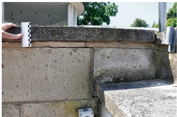
Bild 75 ■ Ausbruch des Fugenmörtels durch Abscherung der Gesteinsquader
