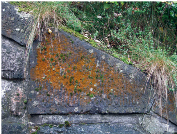
Bild 35 ■ Verfärbung durch biogene Kruste und Flechtenuflagerung
