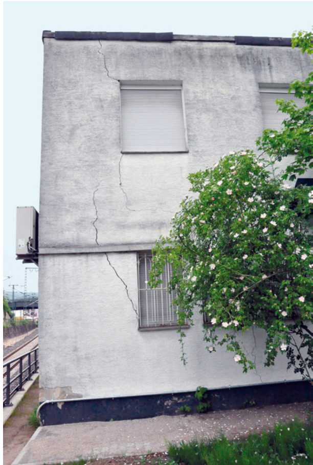
Bild 83 ■ Risse im Putz durch Baugrundbewegungen aufgrund einer angrenzenden Tiefbaumaßnahme
