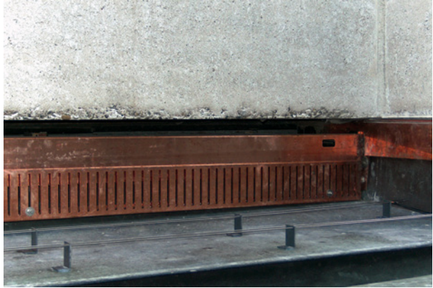
Bild 34 ■ Anordnung von elektrifizierten Spanndrähten vor einer speziell angefertigten Blechabdeckung auf dem Gesims
