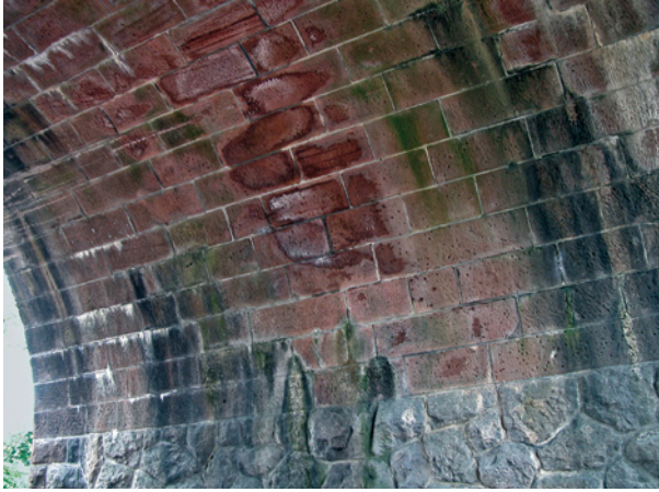
Bild 113 ■ Starke Durchfeuchtung der Tunnel-schale mit Salz-bildung
