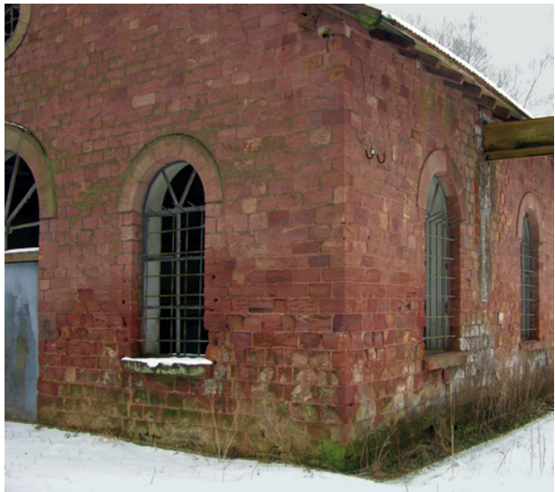
Bild 37 ■ Starke Durchfeuchtung des Mauerwerks mit Salzausblühungen
