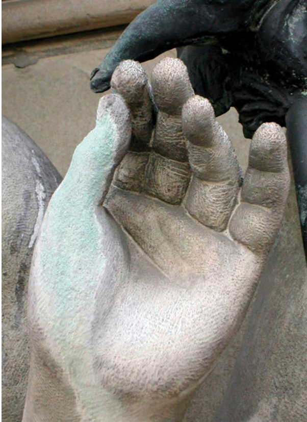
Bild 45 ■ Grünliche Verfärbung durch ablaufendes Wasser der oxidierten Kupferfigur
