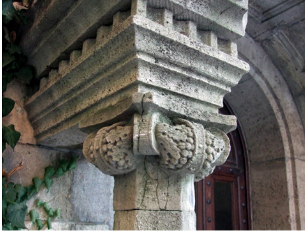
Bild 64 ■ Auflagernder Druck hat zur Durchschlagung des Kapitells geführt
