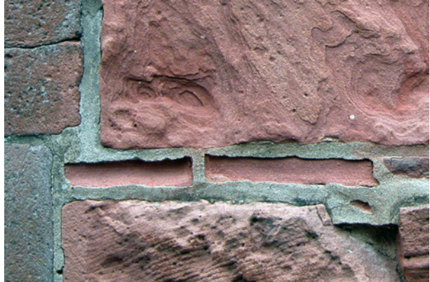
Bild 76 ■ Skelettartig vorstehender Fugenmörtel bei zurückgewitterten Steinoberflächen
