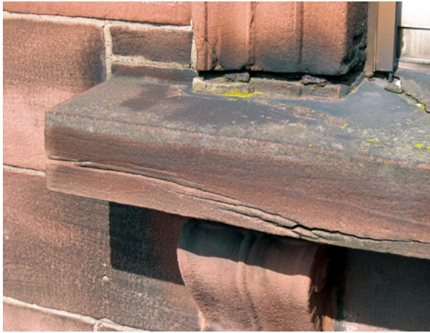
Bild 96 ■ Mehrfache Schädigung einer Sohlbank durch Schalenbildung an der Oberfläche, Risse entlang von Tonlagen und Korrosion am Auflager des Gewändes
