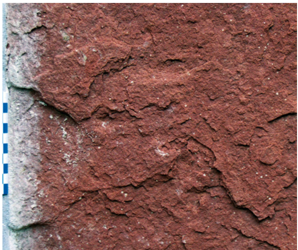
Bild 52 ■ Starke Schuppenbildung auf der Oberfläche eines Sandsteins
