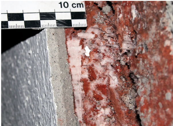
Bild 80 ■ Mehrere mm dicke Salzschrift aus Epsomitkristallen ( \text{MgSO}_4 \cdot 7 \text{H}_2\text{O} ) unter der Putzschale
