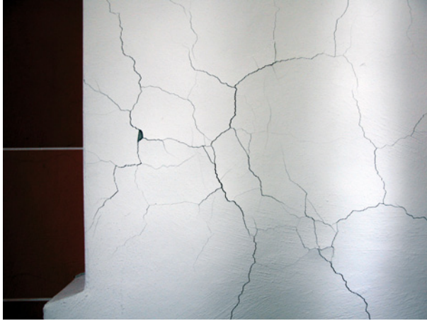
Bild 79 ■ Typisches Rissbild bei Vorhandensein von Ettringit
