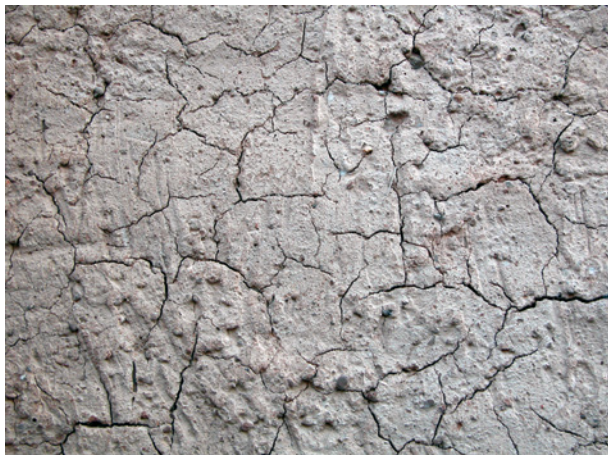
Bild 81 ■ Schwindrisse an der Putzoberfläche
