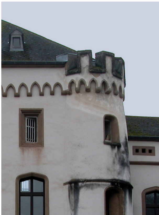
Bild 105 ■ Fehler am Dachanschluss zum Turmmauerwerk haben zu Feuchteschäden des Putzes geführt
