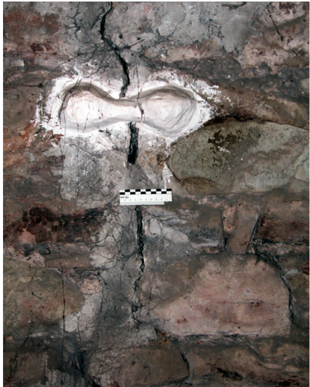
Bild 66 ■ Kontrolle von Rissbewegungen mit Rissmarken
