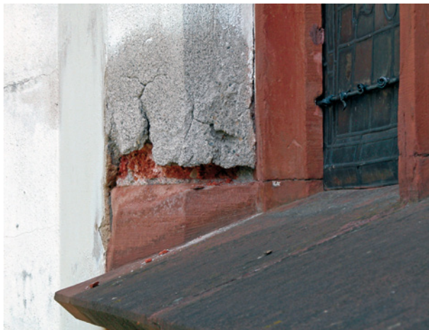
Bild 77 ■ Ablösung der Putzlage durch Gipsbildung und Feuchtigkeit
