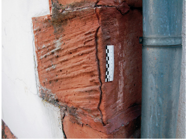
Bild 54 ■ Auskristallisation von Gips führte zur Schalenbildung
