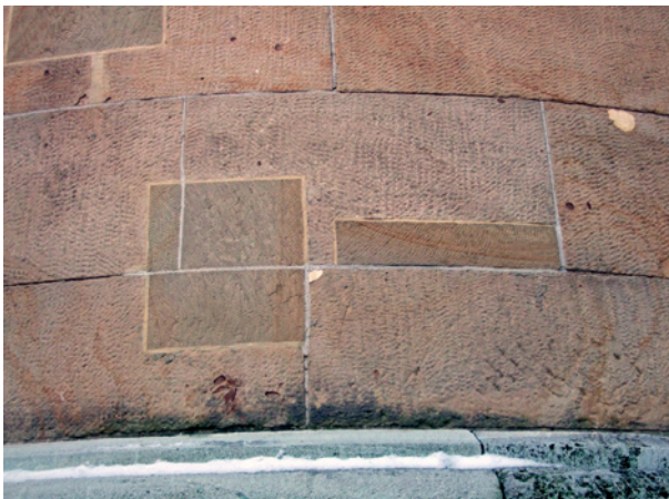
Bild 70 ■ Die Vierungen sind deutlich an der Oberflächenbearbeitung erkennbar
