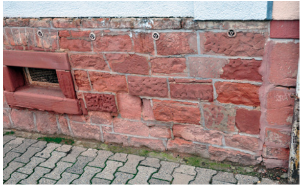
Bild 38 ■ Knapenröhrchen an der Oberkante eines Kellermauerwerks
