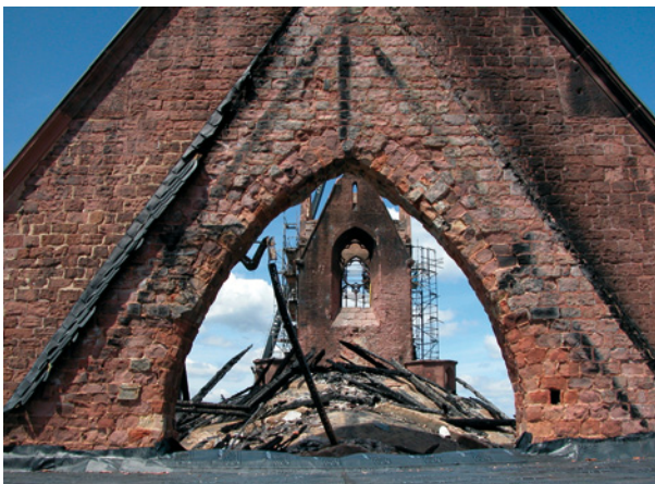
Bild 59 ■ Massive Ausbrüche und Bauwerkschäden nach Brandeinwirkung
