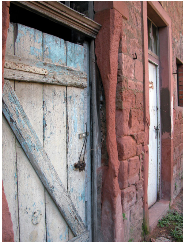
Bild 48 ■ Extreme Rückwitterung des versalzten Türgewändes
