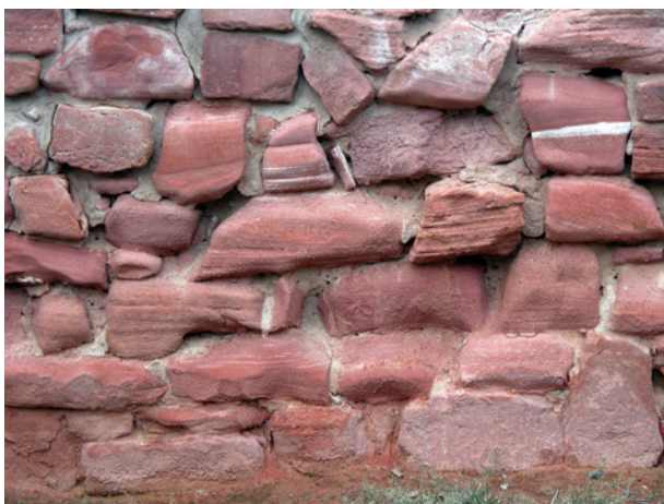
Bild 47 ■ Unterschiedlich starke Rückwitterung der Steinoberflächen durch Absanden
