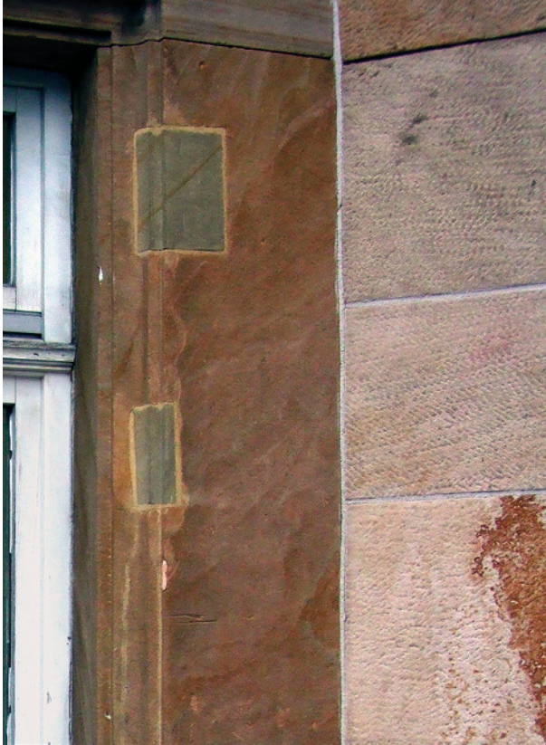
Bild 69 ■ Durch unpassende Färbung von Gestein und Fugenmörtel heben sich die Vierungen stark vom Umgebungsmaterial ab.
