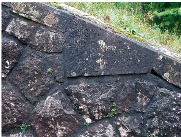
Bild 36 ■ Mauerwerk mit schwarzer Kruste an der Gesteinsoberfläche
