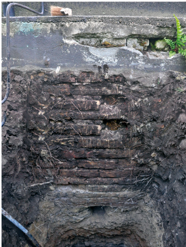
Bild 7 ■ Schurf zur Erkundung von erdbe-rührtem Mauerwerk und Erdreich
