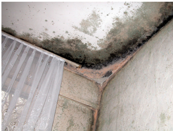
Bild 46 ■ Schimmelpilzbildung durch Kondenswasser in einer Raumecke
