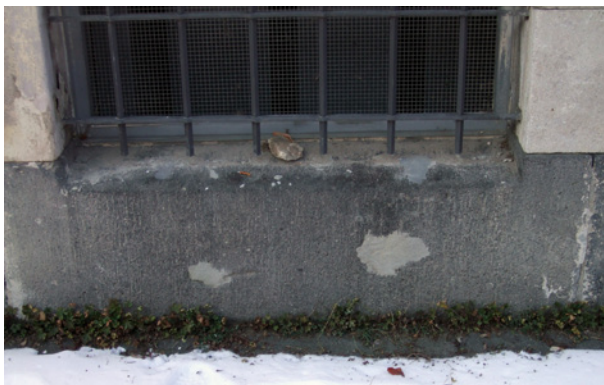
Bild 73 ■ Unbearbeitete Oberfläche von farblich nicht angepassten Restauriermörtelergänzungen
