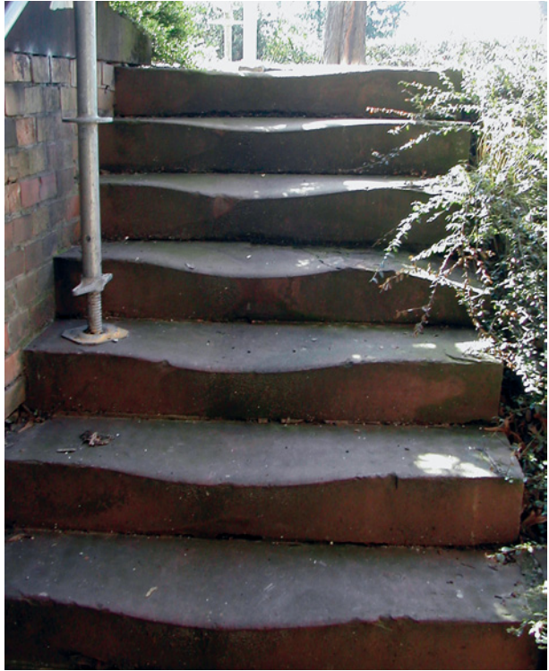
Bild 92 ■ Materialverlust an den Trittflächen
