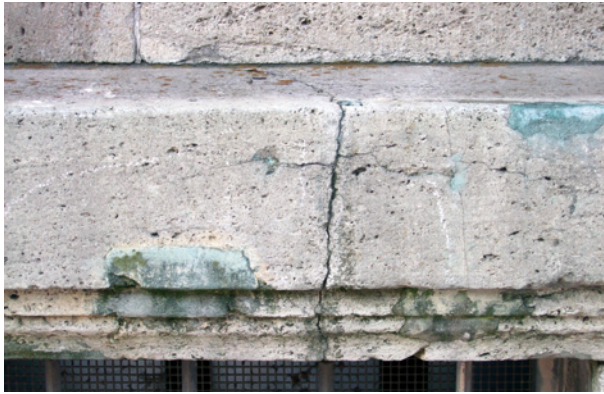
Bild 71 ■ Abplatzung und Verfärbung von Restauriermörtelergänzungen
