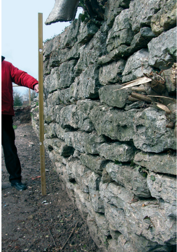
Bild 68 ■ Deutlich sichtbare Verformung des Mauerwerks
