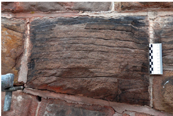
Bild 63 ■ Gesteinszerstörung durch schichtflächenparallele Risse
