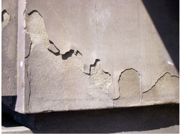
Bild 55 ■ Ablösung der hydrophobierten Schale eines Schilfsandsteins
