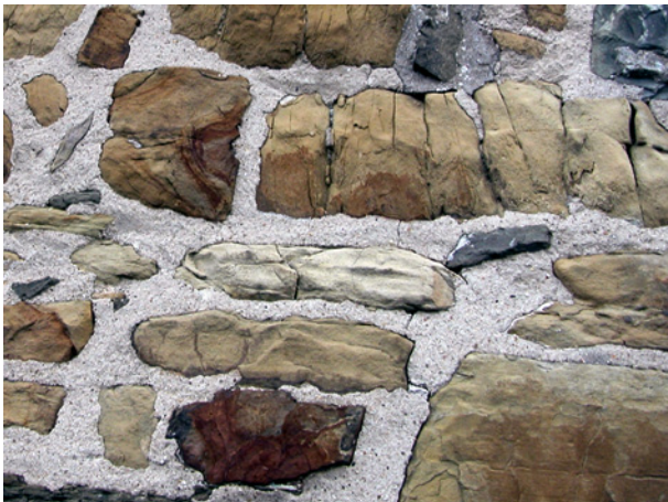
Bild 74 ■ Quer- und Flankenabrissse des harten Fugenmörtels, der gegenüber den Natursteinen eine zu hohe Festigkeit aufweist
