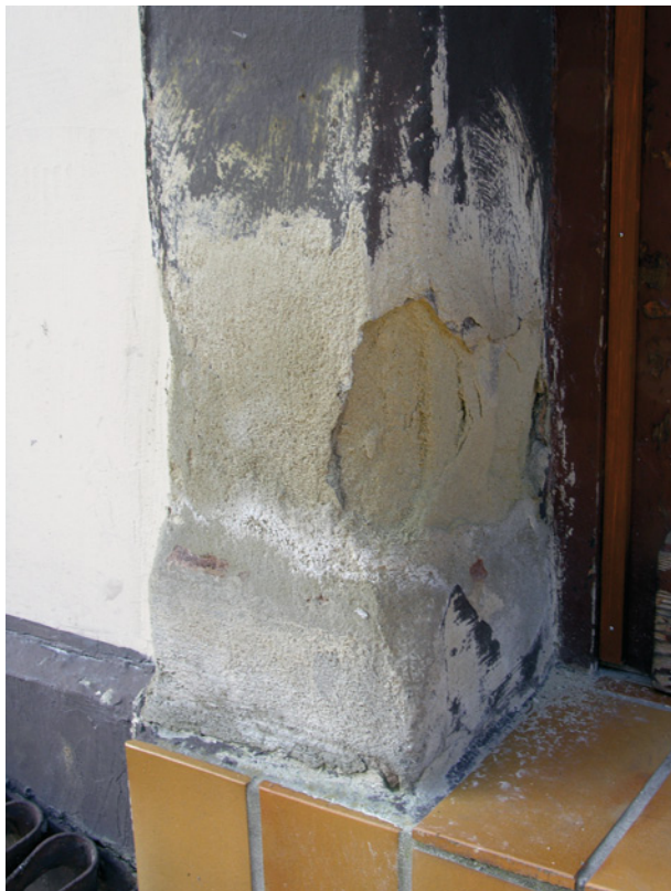
Bild 85 ■ Aufsteigende Feuchtigkeit führt neben dem Absanden des Gesteins auch zur Ablösung des wasserdampfdichten Anstrichs
