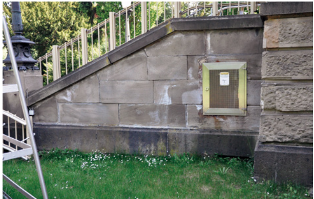
Bild 93 ■ Salzschiiden und Verfärbung durch von der Treppe ablaufendes Wasser
