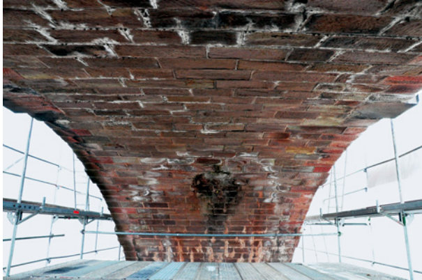
Bild 110 ■ Brückenuntersicht mit starker Sinterung entlang der Fugen
