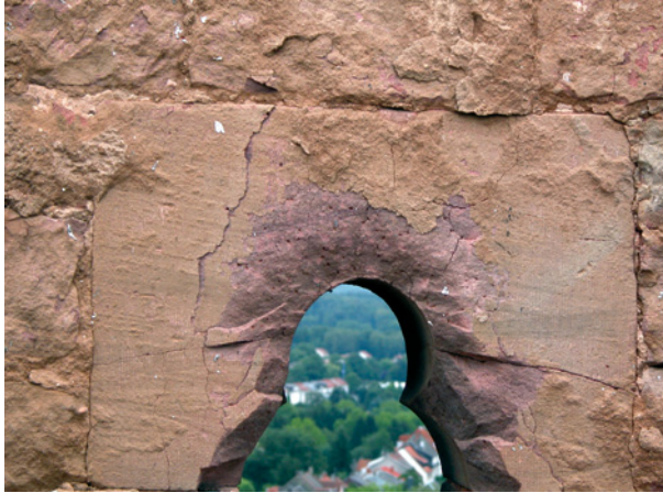
Bild 67 ■ Steindurchschlagende Risse nach Brandeinwirkung
