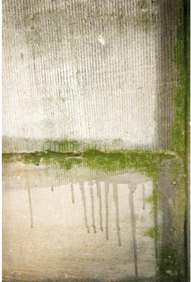
Bild 44 ■ Handwerkliche Mängel bei partieller Festigung
