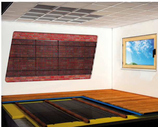
Bild 41 ■ Beispiel für eine Wandheizung [194]
