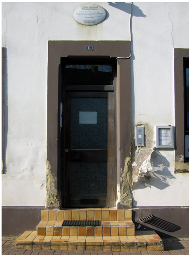
Bild 78 ■ Ablösung der Putzlage an dem durchfeuchteten und versalzten Mauerwerk
