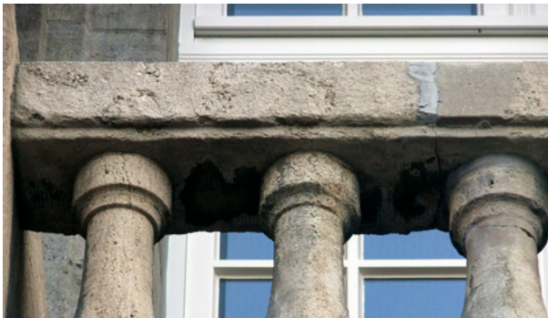
Bild 102 ■ Risse in Handlauf und Baluster durch Bauwerksbewegungen
