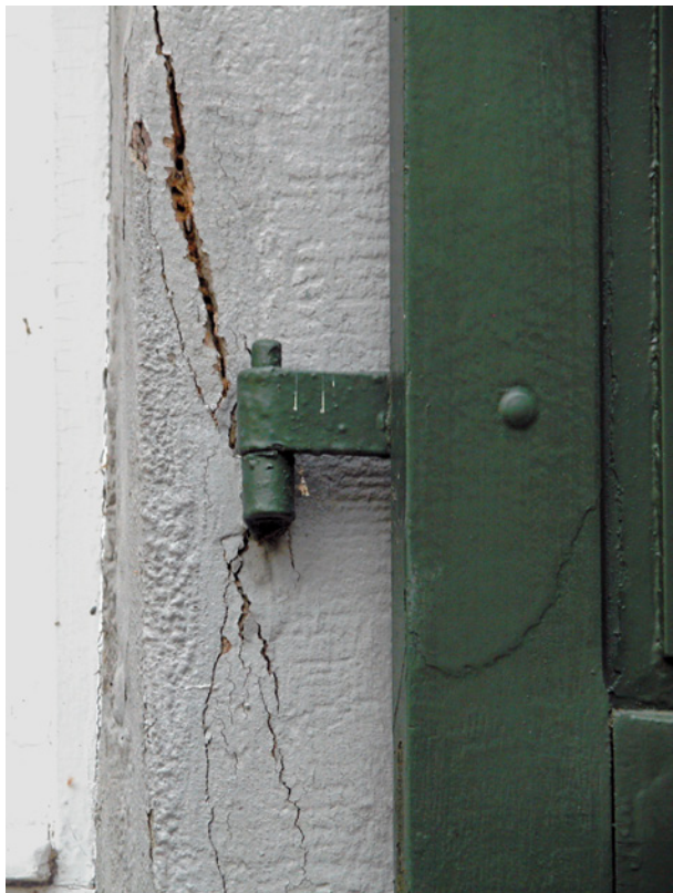
Bild 98 ■ Korrosionsrisse durch die Aufhängung des Fensterladens
