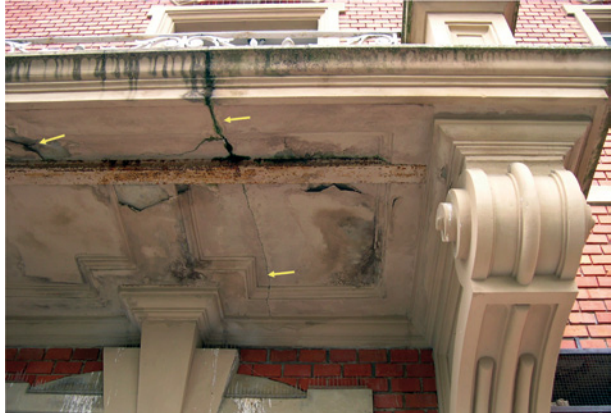
Bild 100 ■ Schalenbildung, Korrosion, Verfärbung der Balkonunterseite durch die entlang des Risses eingedrungene Feuchtigkeit
