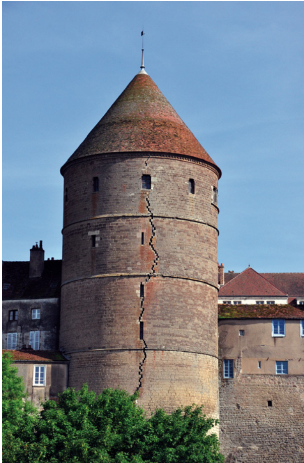
Bild 65 ■ Markante Risse des Turmbauwerks durch Baugrundsenkung
