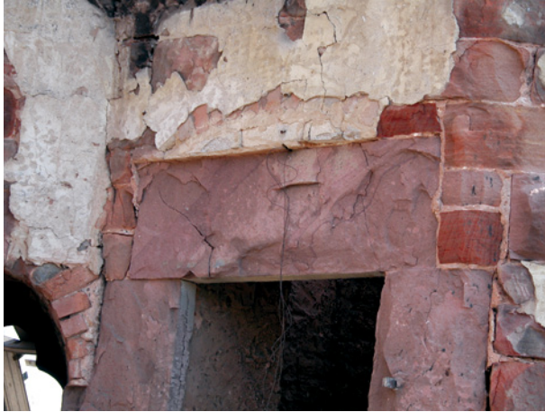
Bild 56 ■ Brand hat zur Abplatzung der Stein-oberfläche und Rissbildung geführt
