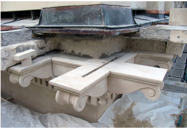
Bild 17 ■ Neu eingesetzte und verankerte Konsolen
