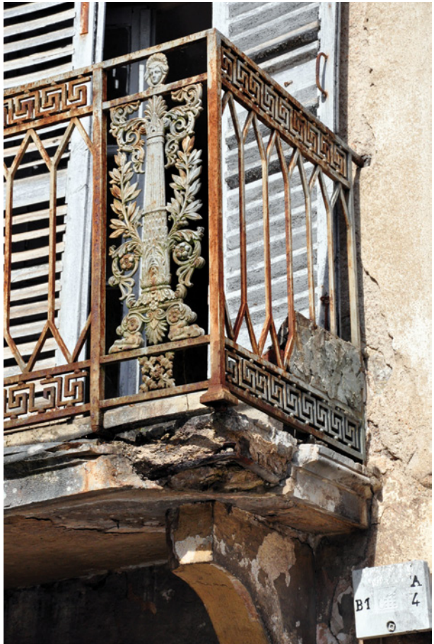
Bild 101 ■ Ausbruch durch Korrosion der Bewehrung und Schalenablösung an der Unterseite der Balkonplatte
