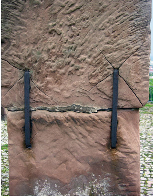
Bild 62 ■ Risse durch korrodierte Verklamm- erung
