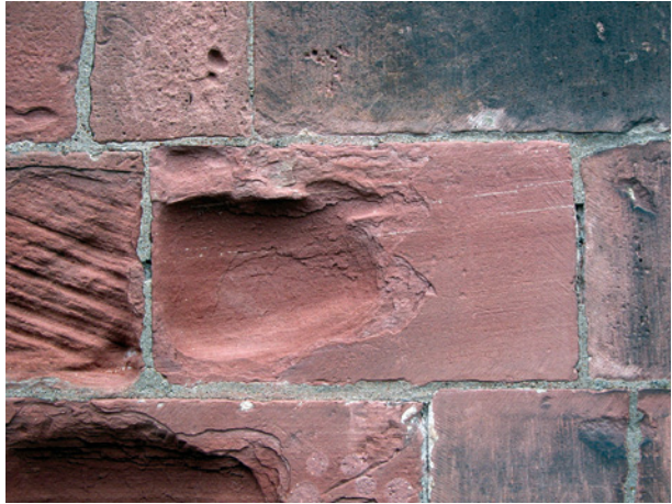
Bild 49 ■ Tiefe Rückwitterung durch Winderosion
