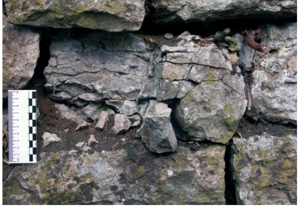
Bild 58 ■ Aufbröckeln eines Steins durch unregelmäßig verlaufende Risse
