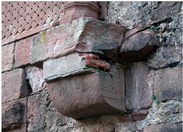
Bild 60 ■ Ausbrüche an einem mittelalterlichen Kapitell
