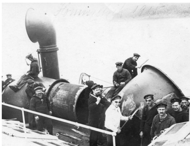
Abb. 4: Instandsetzungsarbeiten am Lüfter der BERLIN. (Foto: Euro-peana)
