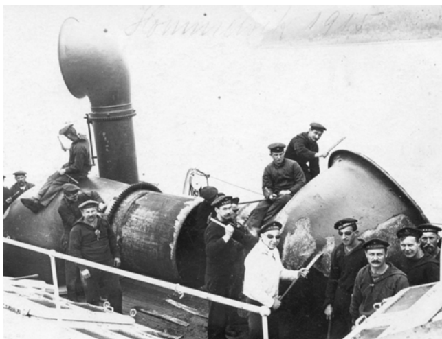
Abb. 4: Instandsetzungsarbeiten am Lüfter der BERLIN. (Foto: Euro-peana)
