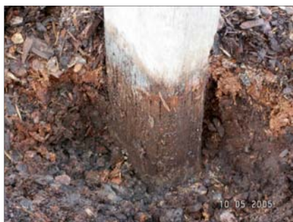
Standpfosten im Rindenmulch – überall Pilzmycel
