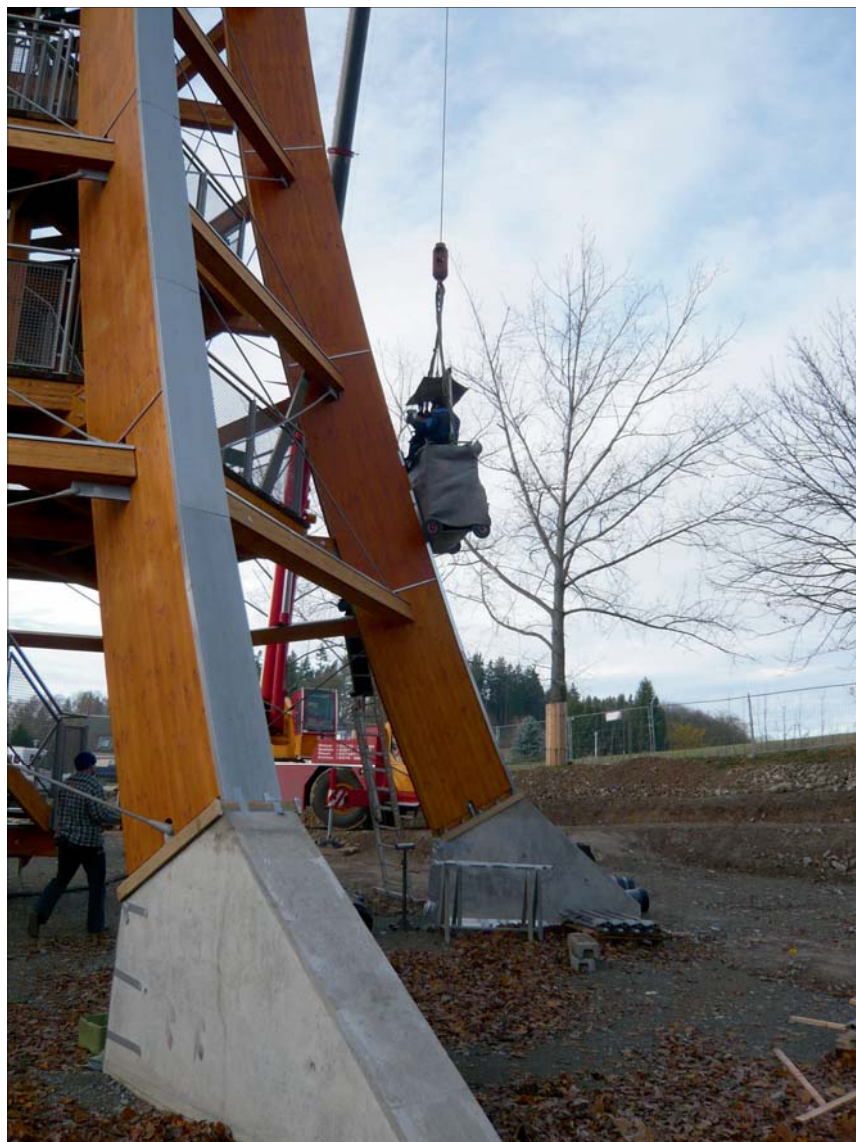
Auf den Außenseiten der Binder wurde eine Verblechung aufgebracht, die den BSH-Binder und die hinterlüftete Wetterschale regensicher abdeckt.
