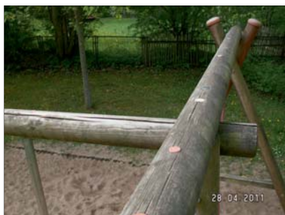
2 auf einen Streich – vorbildliche Abdeckungen aber Risse auf der Oberseite
