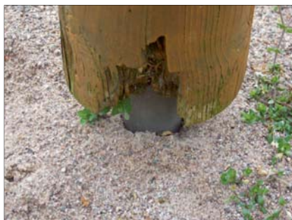
Fehl geschlagene Aufständerung, da geringer Abstand zum Fallschutz
