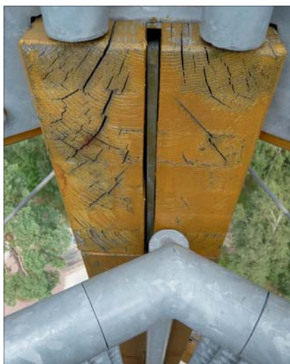
Felixsee 2015: Hirnholzflächen mit unzureichendem Schutz, die Risse begünstigen einen Befall mit holzerstörenden Pilzen, auf horizontalen Bauteilen sind die Schäden durch holzerstörende Pilze schon offensichtlich.
