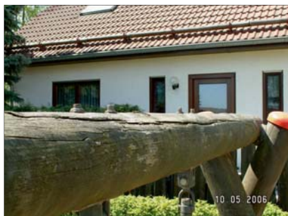
Vorbildliche Abdeckung aber nur am Standpfosten – an den Verschraubungen fehlen Abdeckungen
