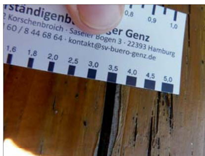
Felixsee 2015: Abgewitterte Oberflächenbeschichtung und Delamellierung der ungeschützten Brett-schichtholzkonstruktion aus Fichtenholz, die als baulich-konstruktiver Holzschutz lediglich mit einer Opferdecklamelle aus Lärche „geschützt“ wurde.
