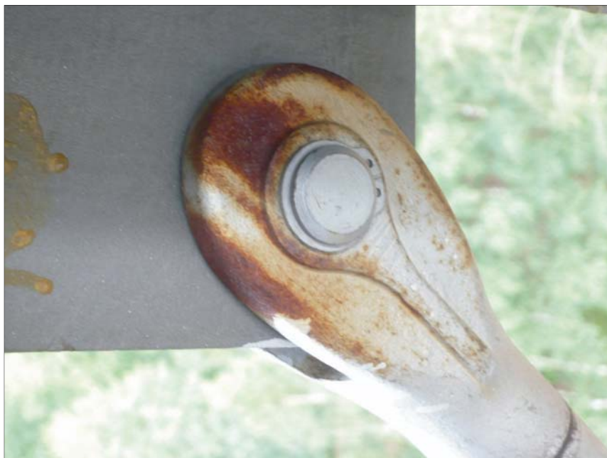
Felixsee 2015: Verzinktes Detan-Zugastabsystem nach 10 Jahren
