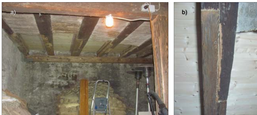
Abb. 8: a) Ansicht einer Instandsetzung von Deckenbalkenköpfen eines denkmalgeschützten Gebäudes aus dem 18. Jahrhundert im Bereich der Wandauflager mittels verklebter Überblattungen b) Detailansicht einer durch Klebung angeschlossenen Überblattung
