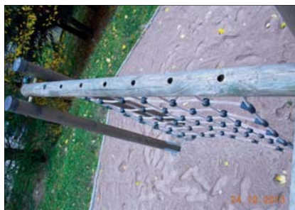
halbherzig: Standpfosten mit Abdeckung – Bohrlöcher ohne Abdeckung
