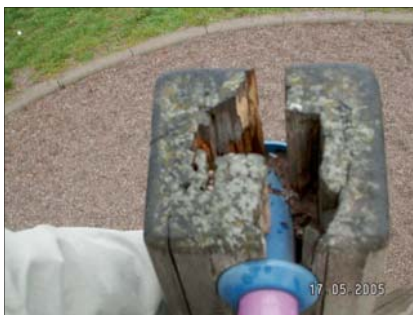
Defekter oberer Standpfosten infolge fehlender zu Abdeckung
