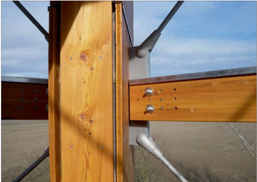
Burgk: glasperlengestrahlttes Edelstahl-Zugstabsystem im Anschluss an den mit einer hinterlüfteten Wetterschale geschützten Binder
