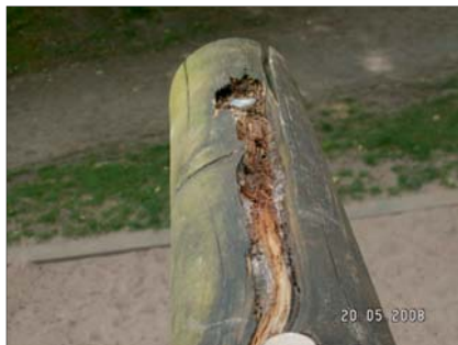
Schaden durch fehlende Abdeckung
