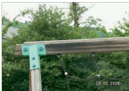
Gute Lösung mit Opferbrett bzw. Abdeckung
