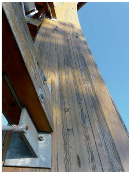
Felixsee 2015: Abgewitterte Oberflächenbeschichtung und Delamellierung der ungeschützten Brett-schichtholzkonstruktion aus Fichtenholz, die als baulich-konstruktiver Holzschutz lediglich mit einer Opferdecklamelle aus Lärche „geschützt“ wurde.
