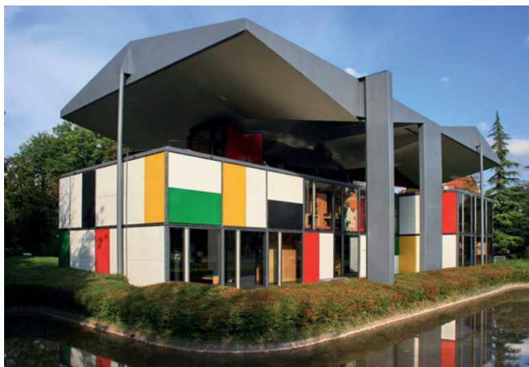
Fig. 7: Le Corbusier, Centre Le Corbusier, Zurich, 1967.
