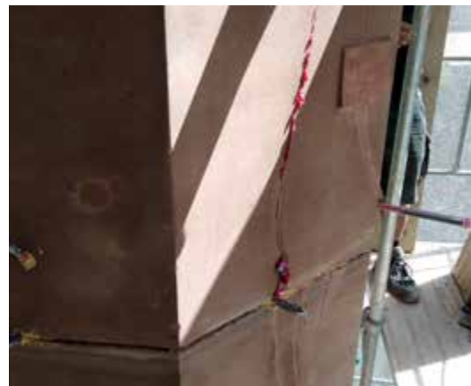
Bild 18 Kontrolle Viskosität Epoxidharzmörtel bei Haarrissen, Probeverpressung
