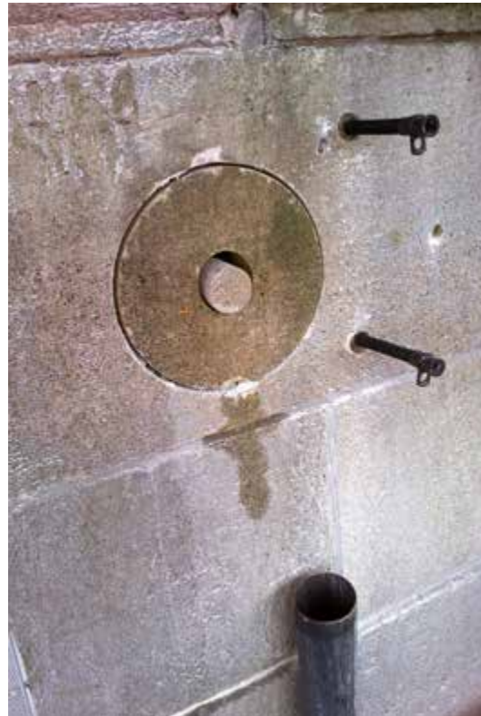
Bild 31 Kernbohrstücke DN 300 + DN 90 wieder in Ausgangslage versetzt
