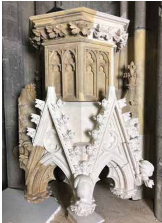
Bild 6 Baldachin G2 vorbereitet zum Einbau von Vierungen
