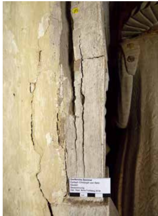
Bild 4 Seitenansicht einer Schriftplatte mit Aufspaltung und Putzschäden am Epitaph Christoph von Behr
