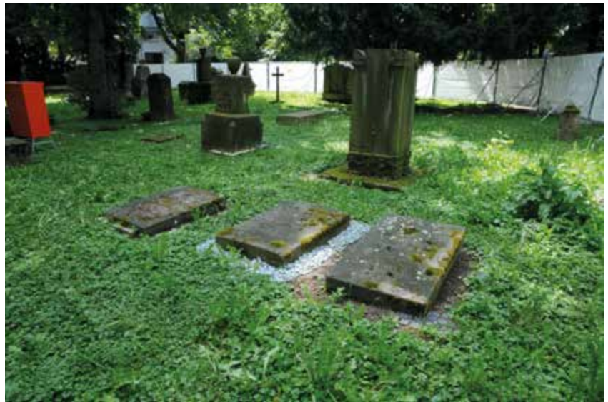
Bild 18 Mustereinfassungen; links ohne Einfassung, mittig Einfassung mit Steinsplittler, rechts Einfassung mit Plastersteine
