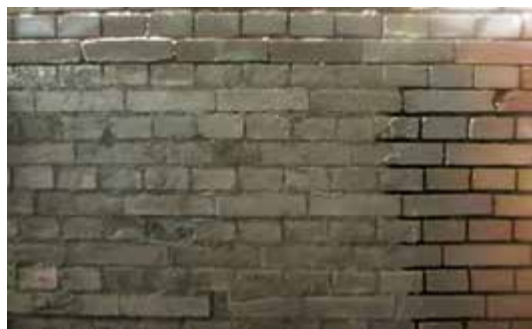
Bild 14 Mauerwerkoberfläche nach dem Entfernen des über- schüssigen Mörtels
