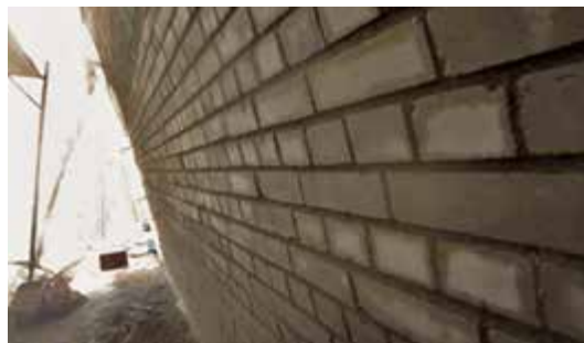
Bild 16 Mauerwerkoberfläche nach der ersten Handreinigung
