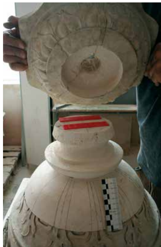
Bild 17 Herstellung einer Vierung aus Kelheimer Kalkstein
