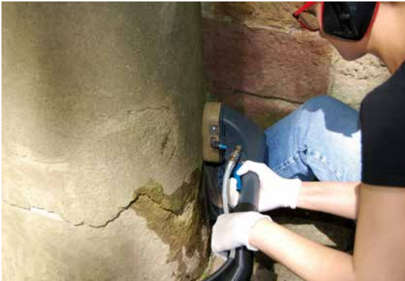
Bild 25 Reinigungs- und Entsalzungsmaßnahmen mit dem Gregomatic® Sprüh-Sauggerät
