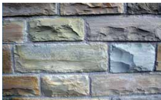
Bild 20 Natursteinoberfläche mehrere Monate nach der Mörtelapplikation und Reinigung
