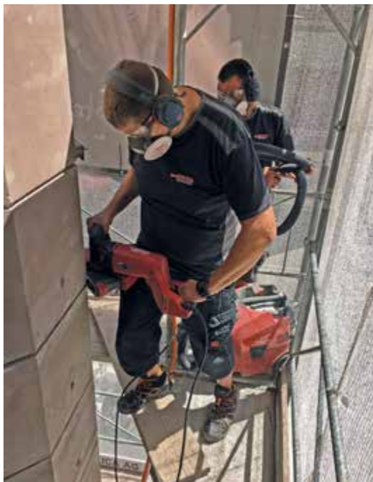
Bild 14 Aufweiten der Fuge mittels Schlitzfräse
