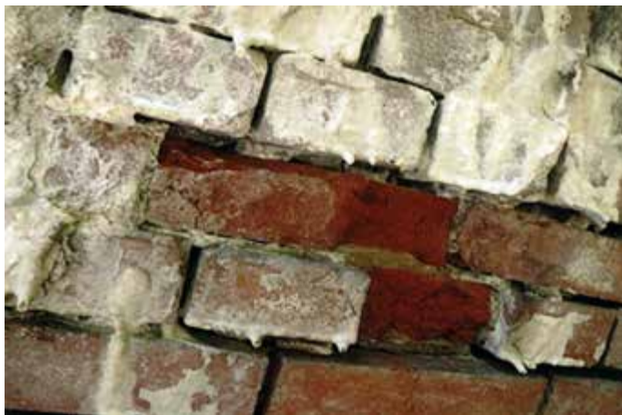
Bild 5 sichtbare Ausblühungen und Aussinterungen an der Gewölbeleibung der Brücke
