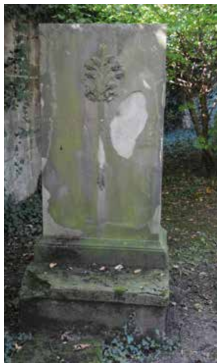
Bild 8 Grabmal von Friedrich Karl Kapff, Handlungsvorsteher (Nr. 8), Zustand 2012 mit großflächiger Schalenbildung als Folge der Hydrophobierung
