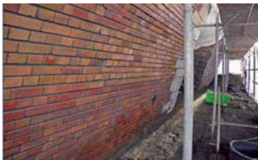
Bild 17 Mauerwerkoberfläche nach der letzten Reinigungsstufe
