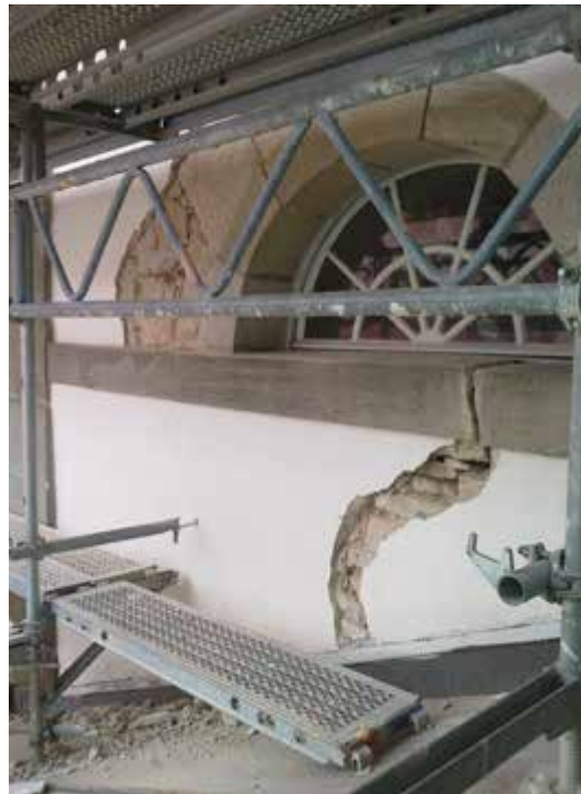
Bild 23 Turmfenster stark ausgeprägtes Rissbild exemplarisch (nach Abnahme Putz)
