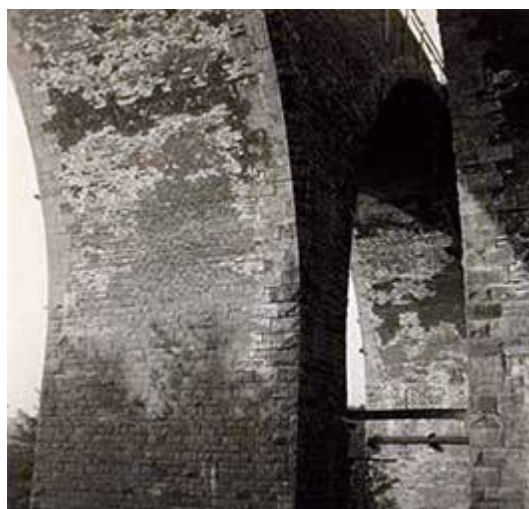
Bild 26 Ausblühungen am Mauerziegelmauerwerk der Talbrücke bereits im Bauzustand im Jahre 1938
