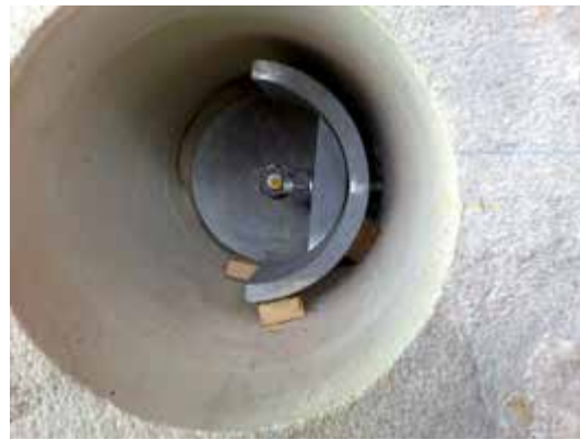
Bild 29 Spannanker Gewindestangen DIN 976 A2 mit Abstandshalter
