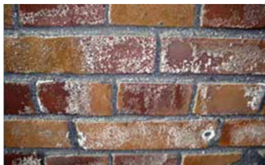
Bild 19 Ausblühungen im Wesentlichen auf den Mauerziegeln – mehrere trockene Nachreinigungen sind erforderlich (Wartung)
