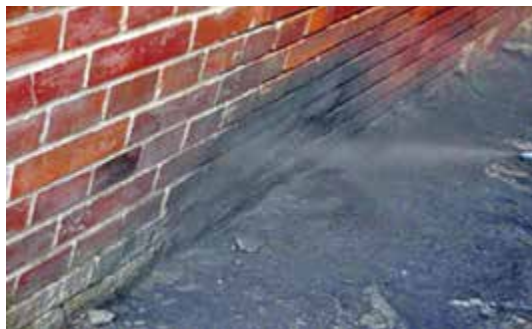
Bild 12 Verfugung im Spritzmörtelverfahren
