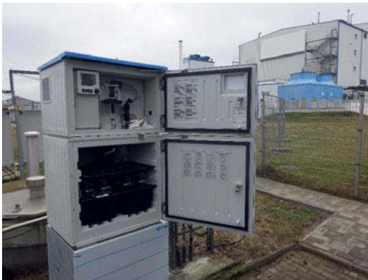
Bild 1: Probenahme- und Analysestation zur Überwachung von Schmutzabwassereinleitungen in das Abwassernetz der Chemieparks
