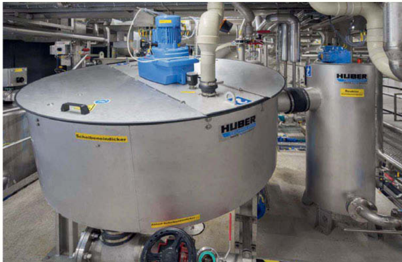
Bild 5: Eindickung Flotat- und Überschussschlamm mit Huber S-Disc Scheibeneindicker
