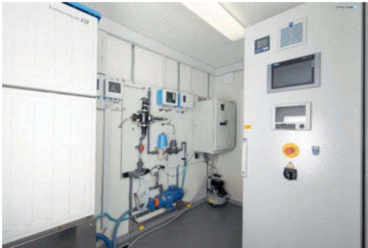
Bild 2: Begehbarer Messcontainer für die Überwachung der Gewässereinleitung
