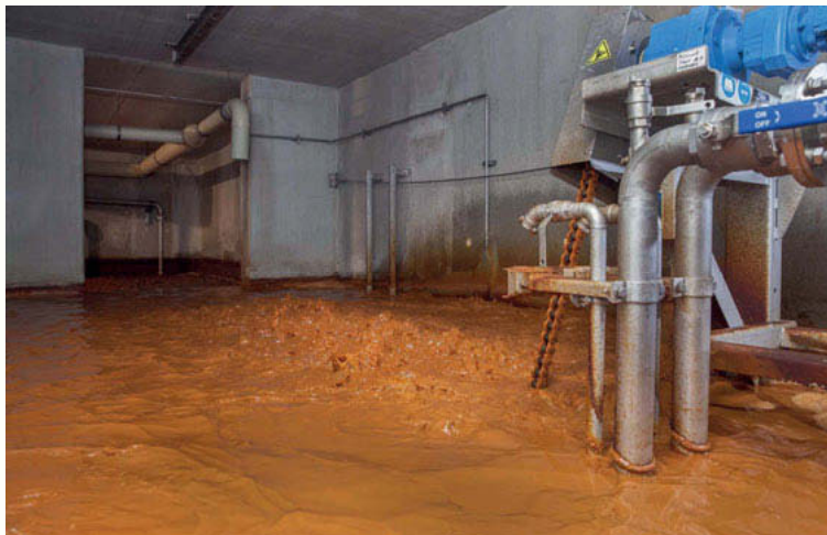
Bild 4: Membranbiologie, eine Filtrationskammer mit Huber VRM 30/18 RF
