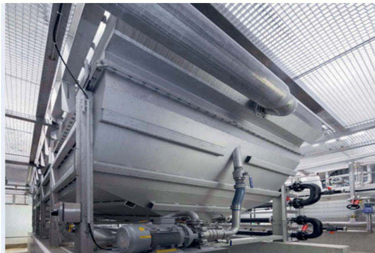
Bild 3: Druckentspannungsflotation Huber HDF S 20
