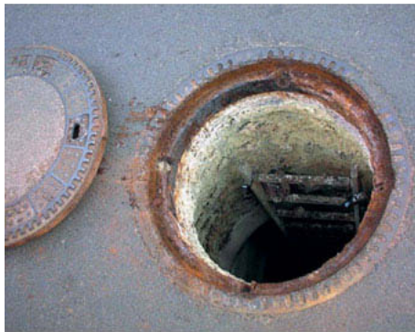
Bildfehler in einem Kanalschacht durch biogene Schwefelsäureproduktion (SSAP)
