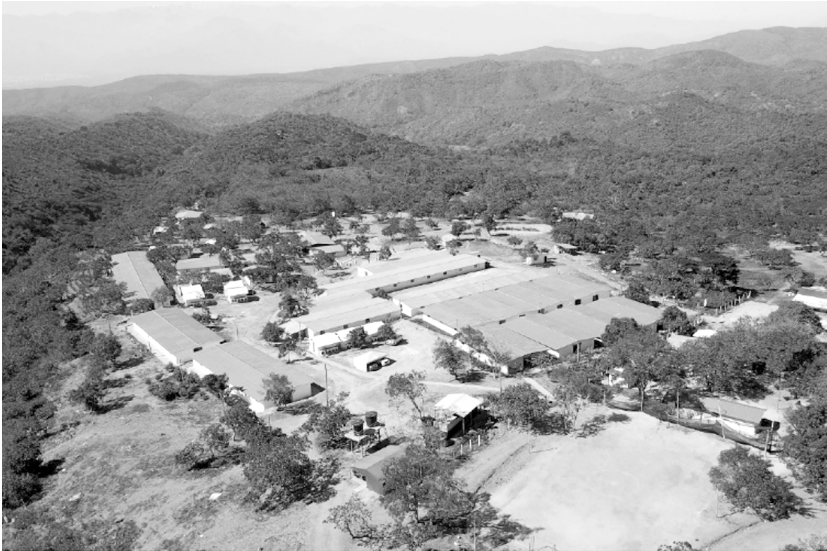
Foto 2: Blick auf das Lager Tierra Grata
