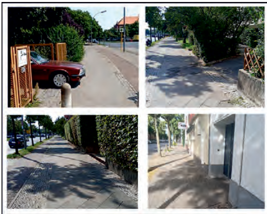
Bild 3: Beispiele von ausgewählten Grundstückszufahrten mit Sichtbehinderung in Berlin (Quelle: UDV)
