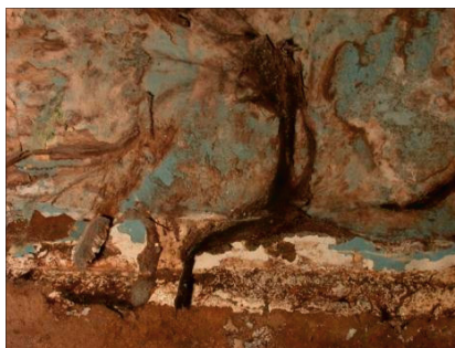
Abb. 13: Derber Strang des Braunen Kellerschwammes durchwächst das Mauerwerk hinter einem Küchenschrank; feinere Mycelien wachsen in alle Richtungen aus.
