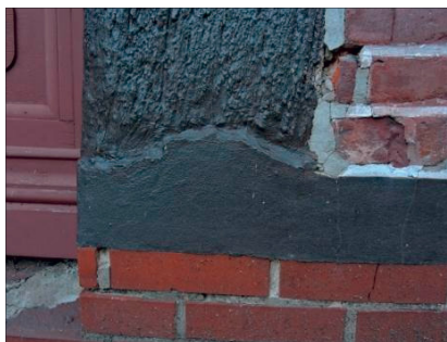
Abb. 3: Verlust der Schwelle aufgrund von Fäuleschäden und Ersatz aus Beton.
