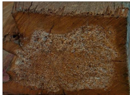
Abb. 31: Ausgebreiteter Hausporling: Weißfäuleschaden an einem Sparren mit massiver Innenfäule; der noch tragende Teil ist schmal geworden. Der erhebliche Fäuleschaden war von außen nicht sichtbar; Material von K. RENHAK (Benshausen).
