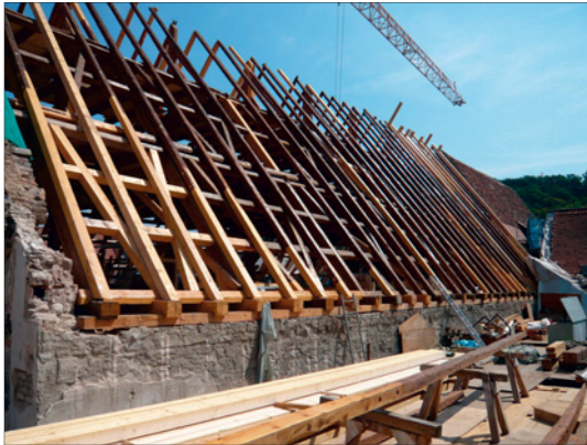
Abb. 5: Freiburg Augustinermuseum Wiedererrichten des Dachtragwerkes über dem Langhaus (Bildquelle: Firma Bennert)
