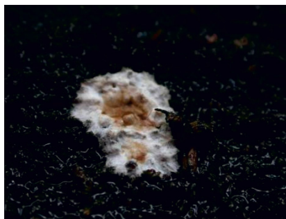
Abb. 11: Detail des kleine Fruchtkörpers des Braunen Kellerschwamms; an der Oberfläche steht das Wasser, da die Dachableitung nicht funktioniert.
