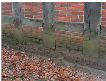
Abb. 38: Negativbeispiel: Schwellenbereich mit Moderfäulepilz-Befall; erkennbar ist, dass die Schwelle schon einmal ersetzt wurde; die Schnittstellen sind sichtbar (!); Spritzwasserzone am Schmutz gut erkennbar.
