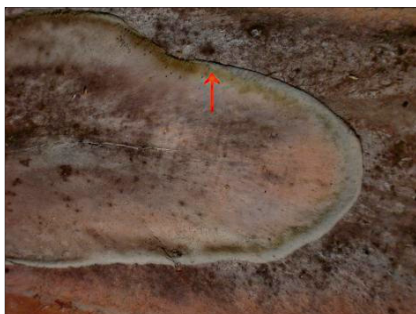
Abb. 23: grau-violettes Mycel des Echten Hausschwamms mit gelben Hemmflecken (†) auf einer verdeckten, verschimmelten Putzfläche im Bad; Maßstab: Bild 10 cm hoch
