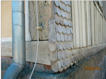
Abb. 2: Durch Schindelbehang geschützte Wetterseite eines Fachwerkgebäudes. Die Schindeln bestehen aus nicht dauerhaftem Rotbuchenholz und erreichen trotzdem eine lange Nutzungsdauer, weil sie so kleinformig sind, dass sie schnell trocknen. Weiterhin ist die Holzkonstruktion eine Steinlage über die Sockelkante angehoben, um Spritzwasser- und Schneeeinwirkung zu mindern.
