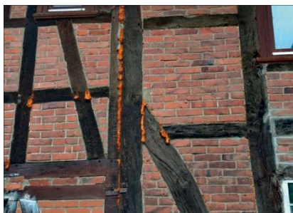
Abb. 57: Ritzen und Spalten wurden mit Bauschaum gefüllt, eingedrungenes Wasser kann nur schwer entweichen.
