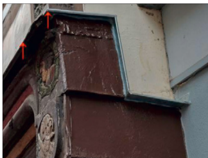
Abb. 55: Abtrocknung mit Tropfnasen (↑).
