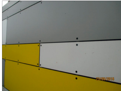
Abb. 3: Moderne Skelettkonstruktionen können auch mit modernen Witterungsschutzbekleidungen, wie Fassadensystemen aus HPL-Platten, versehen werden.
