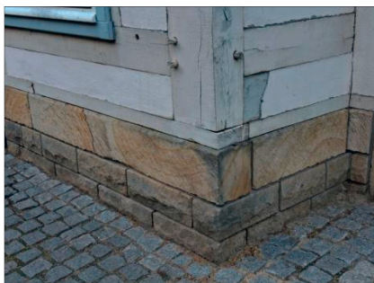
Abb. 2: Verlust der Schwelle aufgrund von Fäuleschäden und Ersatz aus Stein und Bohlen.
