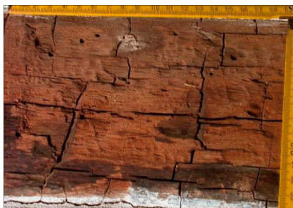
Abb. 4: Riegelschaden: Braunfäule mit Würfelbruch, verursacht durch den Braunen Kellerschwamm ( Coniophora puteana ).
