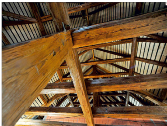
Abb. 6: Freiburg Augustinermuseum sichtbare historische Holzkonstruktion (Bildquelle: Firma Bennert)
