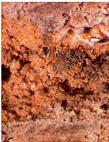
Abb. 42: Detail von Abb. 41 (siehe Kasten): Befall mit Moderfäulepilzen und kleinen Larven des Bunten Nagekäfers, erkennbar an den diskusförmigen Kotpartikeln (↑).
