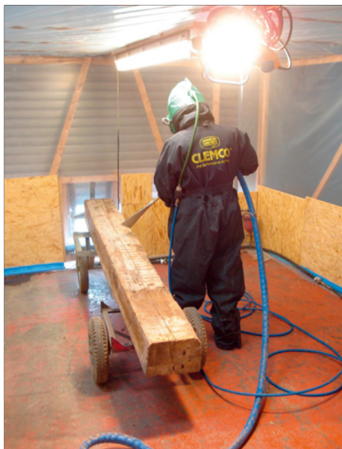
Abb. 3: Freiburg Augustinermuseum Schadstoff-dekontamination durch Trockeneisstrahlen in der Lagerhalle (Bildquelle: Firma Bennert)
