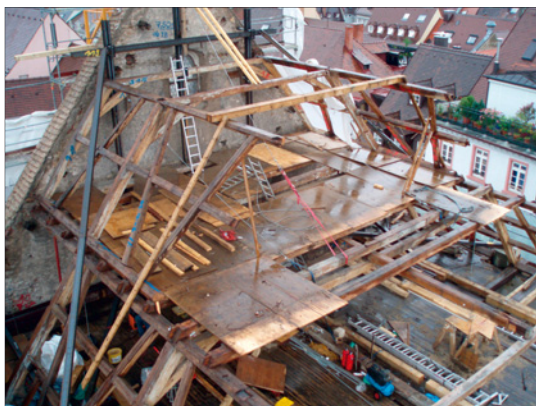
Abb. 1: Freiburg Augustinermuseum Rückbau des Dachtragwerkes über dem Langhaus (Bildquelle: Firma Bennert)
