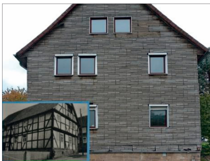
Abb. 52: Verstecktes Fachwerk; Eckbild zeigt historischen Zustand.
