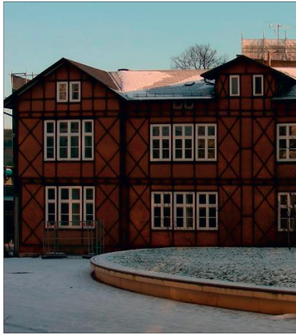
Abb. 19: Ein von außen intakt aussehendes Fachwerkhaus; es hatte eine Innendämmung, die zum Bauschaden führte; das Gebäude wurde abgerissen.
