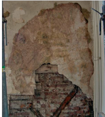
Abb. 20: Detail von Abb. 19 (Innenansicht): Innendämmung entfernt; Mycel mit Zuwachzone und Braunfäuleschaden sind sichtbar.
