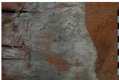
Abb. 26: Mycel des Echten Hausschwamms auf einer Dielenunterseite; typisches graues, lappiges Mycel mit Zuwachszone; Maßstab mit Zenti- und Millimetern.
