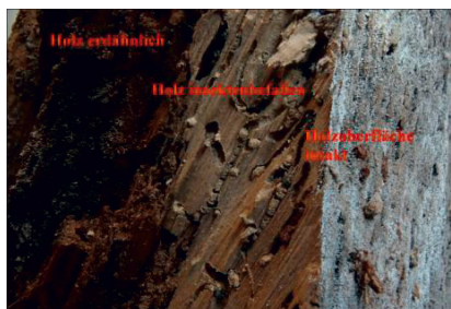
Abb. 33: Detail des Insekten- und Fäule-schadens mit einer auffällig intakten Oberfläche (rechts im Bild).
