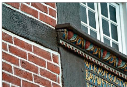
Abb. 49: Schönes Detail eines Fachwerkhouses, das der Wasserableitung dient.
