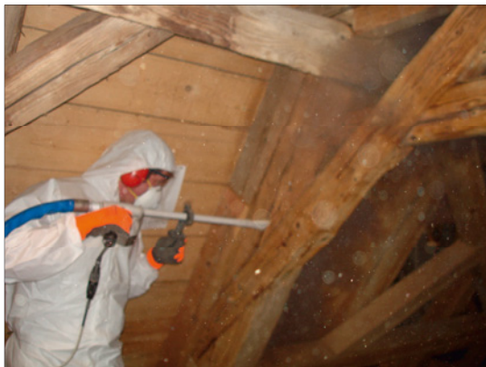
Abb. 16: Burg Ghandstein Schadstoffdekontamination (Bildquelle: Firma Bennert)
