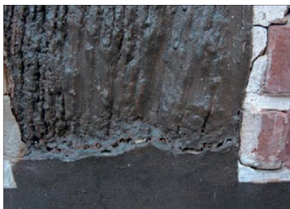
Abb. 56: Stiel mit Übergang zu einer Beton-Schwelle. Dem Quellen und Schwinden des Holzes kann die Dichtmasse nicht folgen und ist gerissen, dadurch dringt vermehrt Wasser ein, das kaum mehr entweichen kann.
