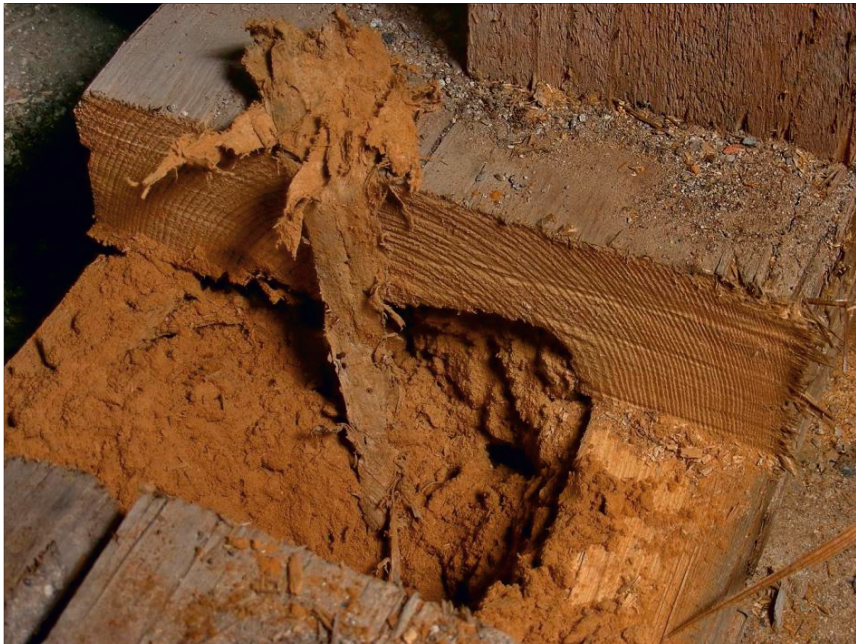
Abb. 18: Stränge und lappiges, braungraues Mycel des Echten Hausschwammes im Inneren eines Mauerbalkens (Innenfäule). Der Balken war dreiseitig ohne erkennbaren Schaden, luftumspült und klang nicht hohl. Das Innere zeigt eine massive Innenfäule (Braunfäule); Begleitschaden durch den Balkenkopf-Pochkäfer / Schwammholzkäfer ( Trypoxys carpinii ); trotz des massiven Myceleinwuchses wurde der luftumspülte Holzmantel nicht abgebaut.
