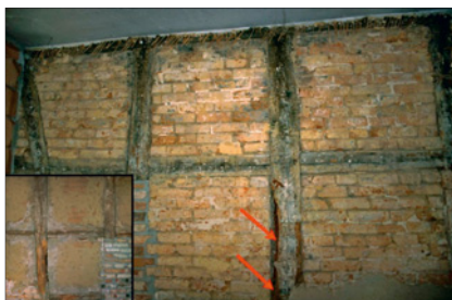
Abb. 25: Eine Fachwerk-Innenwand; einige Fehlstellen durch Fäule sichtbar (†); Eckbild zeigt Rückseite.
