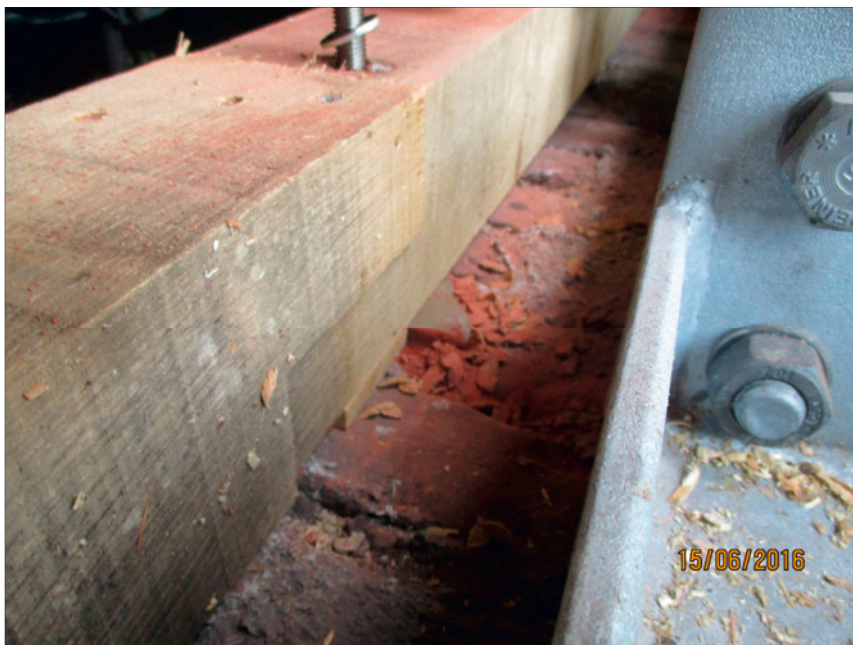
Abb. 5: Neue Fußpfette aus Eichenholz auf Abstandhaltern bei der Reparatur eines Hausschwamm-schadens an einem Kirchendach. Selbstverständlich wurden vor dem Verschließen der Konstruktion die Späne beseitigt.
