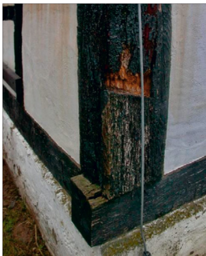
Abb. 8: Negativbeispiel: Zu knappe Reparatur am Ständer; der Ausgebreitete Hausporling war noch hinter der gesund erscheinenden Schnittkante vorhanden und breitet sich nach der Sanierung sowohl im neuen als auch im alten Holz weiter aus. Durch die neue Fuge an der Reparaturstelle dringt mehr Wasser in die Konstruktion ein als früher und der Pilzbefall kann höher steigen.
