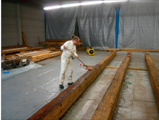
Abb. 4: Freiburg Augustinermuseum Maskierung der Hölzer (Bildquelle: Firma Bennert)
