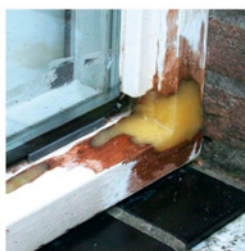
Ausbesserung mit Repair Care: erhalten statt austauschen
