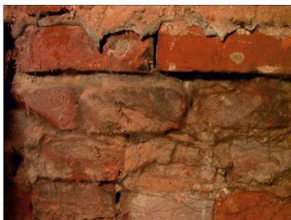
Abb. 12: Mycelien des Braunen Kellerschwammes an einer Wand; die braunen bis schwarzen Stränge liegen in einem dünnen Mycel.
