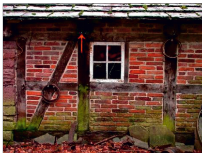
Abb. 10: Schaden an einem Sparrenkopf einer Schuppendecke auf der Westseite; der Schaden greift auf die Fachwerk-Konstruktion über.
