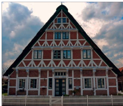
Abb. 1: Norddeutsches Fachwerkhaus von 1618 im Alten Land an der Elbe; Ausfachungen aus Ziegelsteinen; auskragende Geschosse schützen die unterliegenden.
