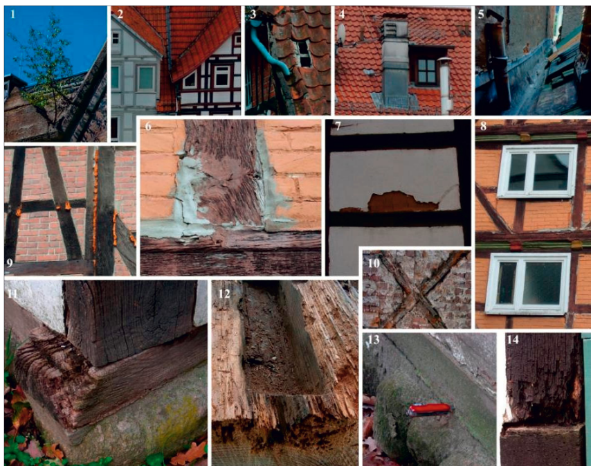
Abb. 58: Typische Schadensschwerpunkte im Sichtfachwerkbau:
