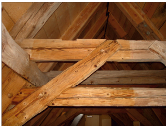
Abb. 17: Burg Ghandstein erzieltes Reinigungsergebnis Schadstoffdekontamination (Bildquelle: Firma Bennert)
