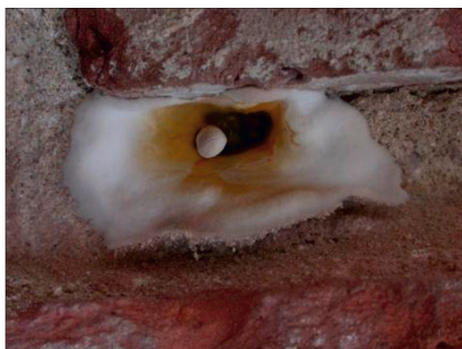
Abb. 27: Echter Hausschwamm: Fruchtkörperbildung an einem Packer; Mycel wächst durch das Rohr des Packers.
