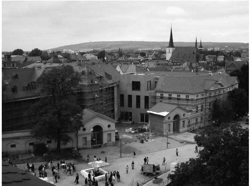
Blick auf das neue Studienzentrum. Links, eingerüstet, das Rote Schloss mit der Bibliotheksverwaltung. Im Zentrum das neue Eingangsgebäude. Hinter den hohen Fenstern liegt der Hauptlesesaal. In dem anderen eingerüsteten Gebäudekomplex, einer Dreiflügelanlage mit dem Gelben Schloss, sind vor allem die Freihandbereiche untergebracht. Der Bücherkubus, auf dem Bild nicht zu erkennen, befindet sich in der Mitte dieser Anlage. Unterhalb der Straße liegt der Lesebereich Park. Nicht sichtbar ist das Tiefmagazin (links, unter dem Platz der Demokratie). Foto: Markus Goldammer
