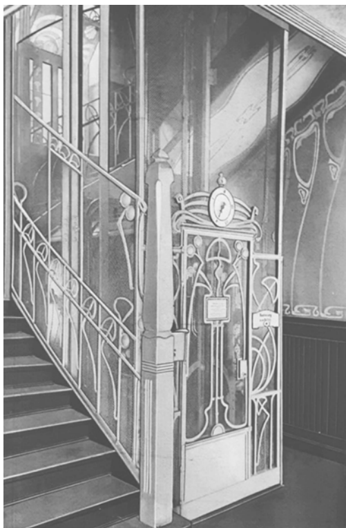
Abb. 2: Personenaufzug im Gebäude von Herrn Bau-meister Schütz, Kassel, Maschinenfabrik Unruh und Liebig, 1910.
