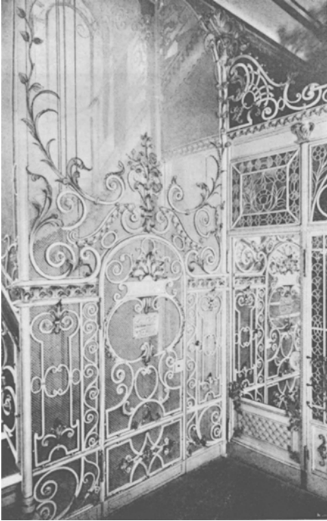
Abb. 1: Personenaufzug im Kaiserhotel, Berlin, Maschinenfabrik Carl Flohr, 1898.
