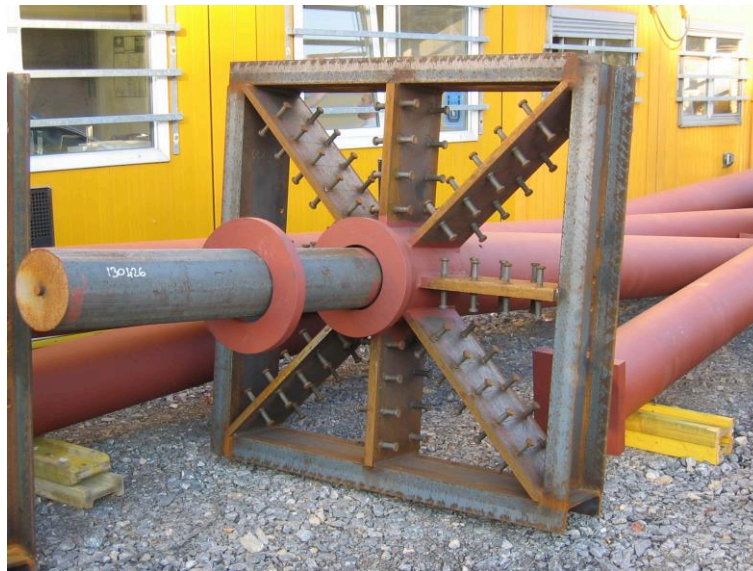
Bild 2-25: Praxisbeispiel für eine Verbundstütze mit Stahlpilz [73]
