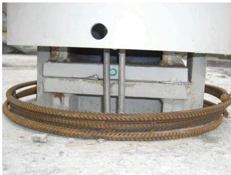
Bild 1-6: Stoß der eingestellten Stahlprofile oberhalb der Decke [13]
