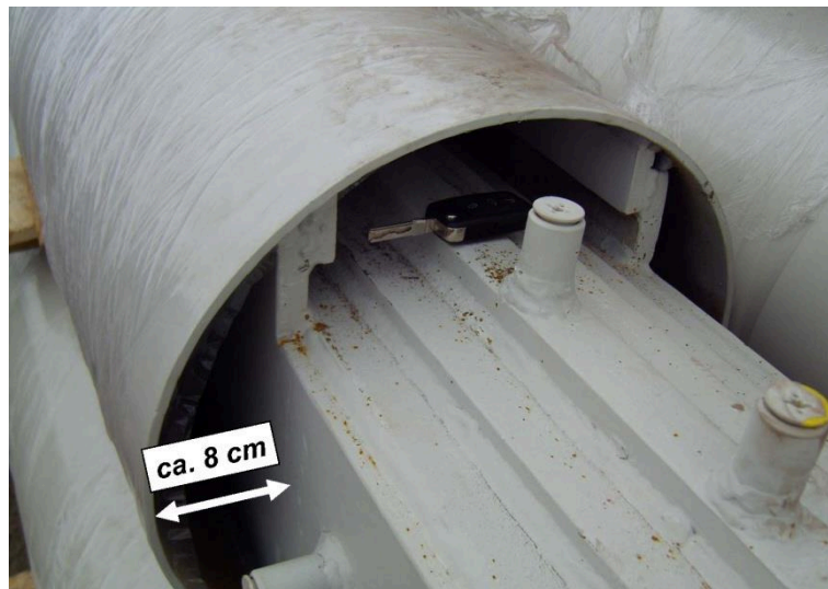
Bild 1-7: Beispiel für die Ausführung einer Verbundstütze mit großem Kern (aus [15])
