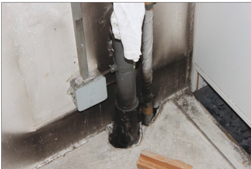
Foto 7: Offener Deckendurchbruch
