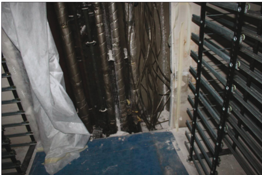
Foto 6: Verrauchter Schacht in einer Nutzungseinheit
