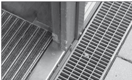
Abb. 2: Gitterrostrinnen sind stark durchlässig und reflektieren nur wenig Spritzwasser.
