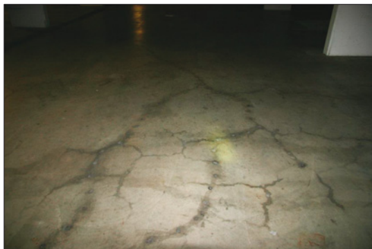
Abb. 6: Rissbild Bodenplatte einer Tiefgarage im Grundwasser
