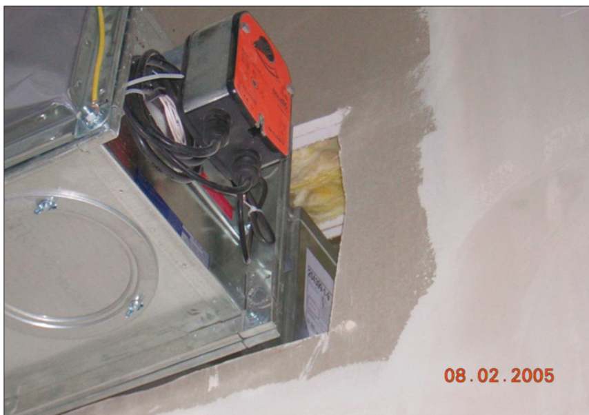
Foto 15: „Einbau“ einer Brandschutzklappe
