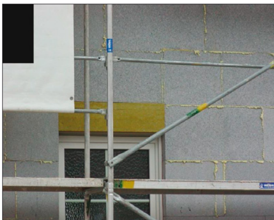
Abb. 2: Verlegen der Dämmplatten
