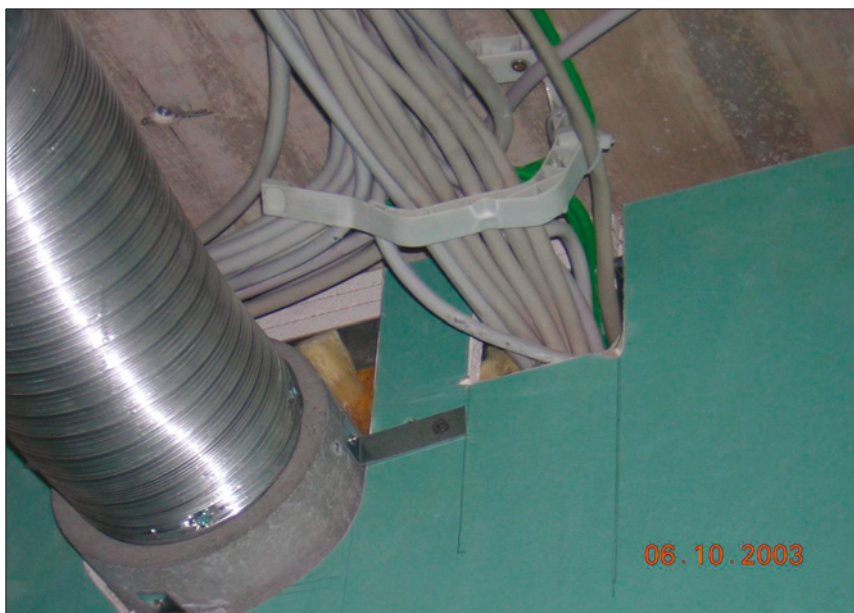
Foto 17: Keine fachgerechte Abschottung möglich
