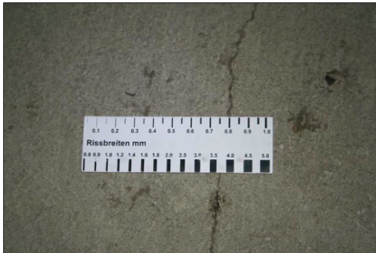
Abb. 9: Rissbreiten bis zu 0,8 mm
