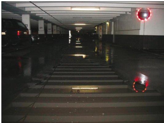
Abb. 10: Großflächige Seen in einer Tiefgarage ohne ausreichendes Gefälle und ohne funktionierende Entwässerung
