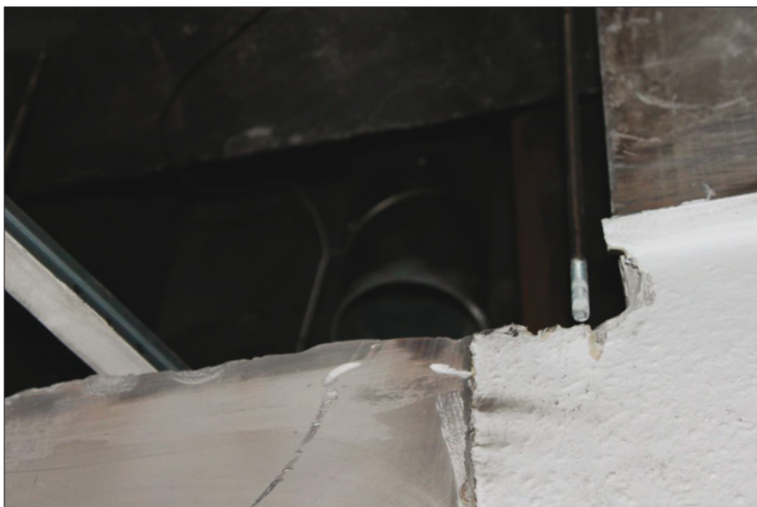
Foto 5: Sichtbarer offener Schacht in Decke über KG
