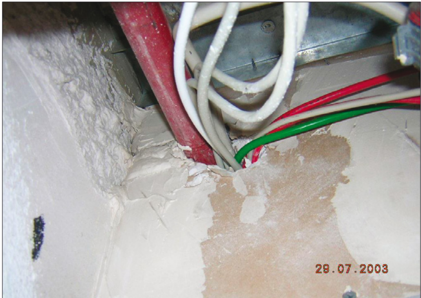
Foto 9: Fehlende Kabelschottung
