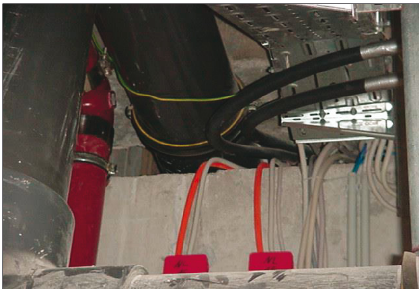
Foto 18: Keine fachgerechte Abschottung möglich
