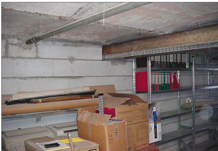
Foto 20: Stahlträger gemeinsam mit Kabeltrasse durch Brandwand
