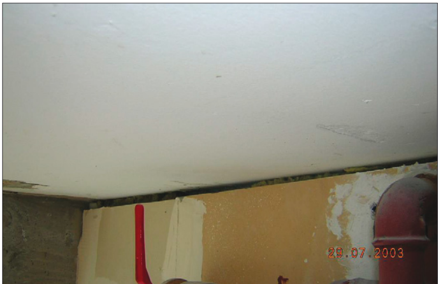
Foto 10: Trennwand unter Decke zu kurz
