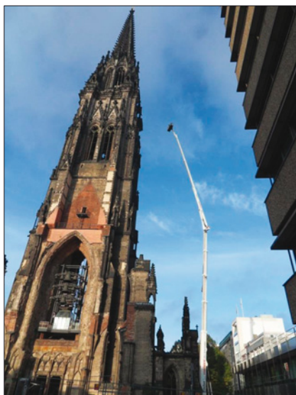
Abb. 8: Einsatz einer 88-m-Arbeitsbühne am Nikolaikirchturm in Hamburg, für den oberen Teil der 147 Meter hohen Turmspitze wurde ein Helikopter eingesetzt.
