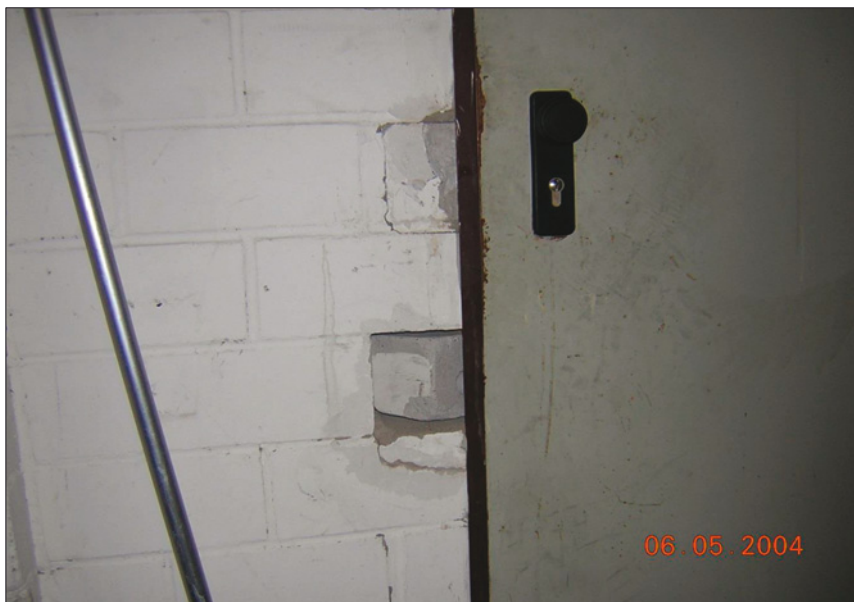
Foto 16: Einbau T30-Tür, lose Steine
