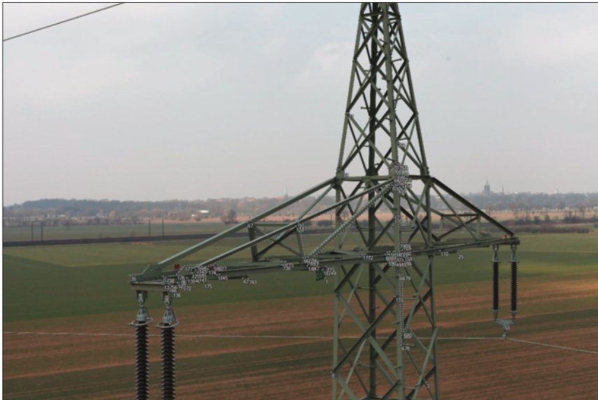
Abb. 15: Freileitungsmast mit markierten Messpunkten
