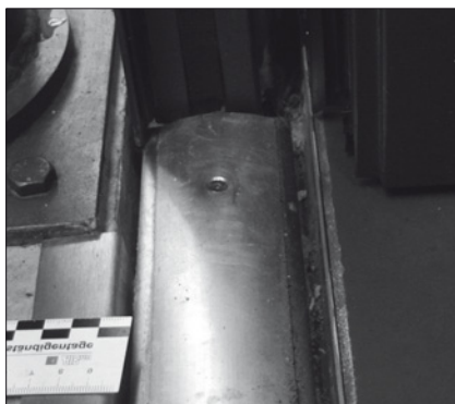
Abb. 5: Anwendungsbeispiel mit doppelter Schlitzrinne, links die Situation nach dem Einbau der für Wartungen abnehmbaren Schwellenabdeckung. Rechts die Prinzipskizze der Entwässerungsführung, getrennt nach Maßnahmen in Abhängigkeit der Anforderungen an den Wärmeschutz.
