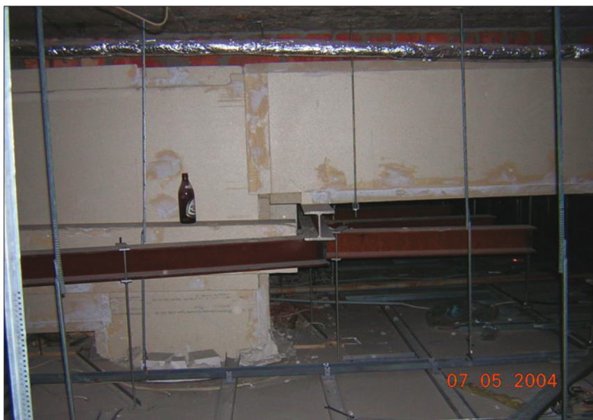
Foto 19: Stahlträger als Tragwerk nicht geschützt in Zwischendecke
