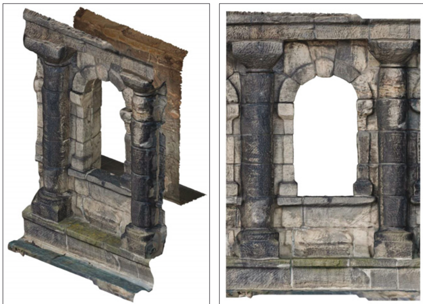
Abb. 14: Porta Nigra Trier, Fensterdetail: links das vermaschte und texturierte 3D-Oberflächenmodell, rechts Orthofotoansicht von außen
