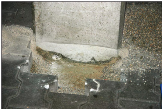
Abb. 15: Fehlende Hohlkehle und Beschichtung führten in der Stütze bereits nach weniger als fünf Jahren Nutzung zu Chloridkonzentrationen von über 1 %, bezogen auf den Zementanteil
