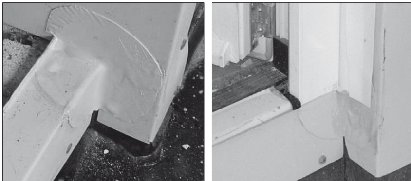
Abb. 4: Anwendungsbeispiel für das Unterfahren der Türschwelle, hier mit einer Kunststoffbahn, die auf einem Verbundblech nach innen geführt und von innen angeschlossen wird. Auf dem Foto links ist die Situation vor Einbau der Tür dargestellt. Für den Wärmeschutz ist das seitliche Blech thermisch zwischen Innen- und Außenbereich zu trennen oder zu dämmen. Rechts nach dem Einbau der Tür, aber noch vor der Verlegung des Dachaufbaus.
