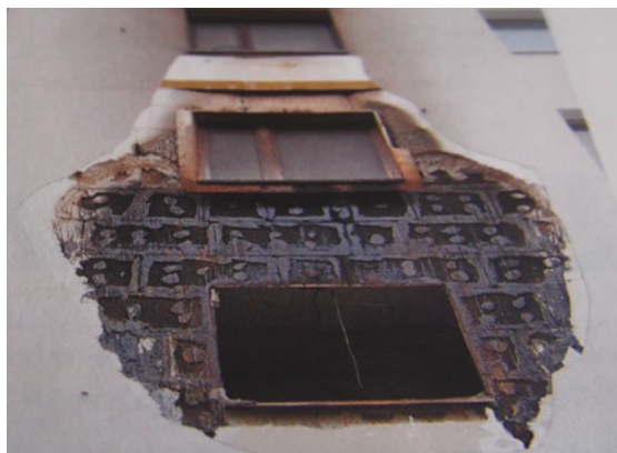
Abb. 3: Fehlerhafter Brandriegel
