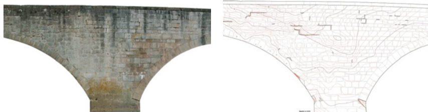
Abb. 4: Straßenbrücke in Mulfingen über die Jagst: Bildplan und Umzeichnung und Deformationen. Es wurden auch alle Bogenuntersichten abgewickelt dargestellt.
