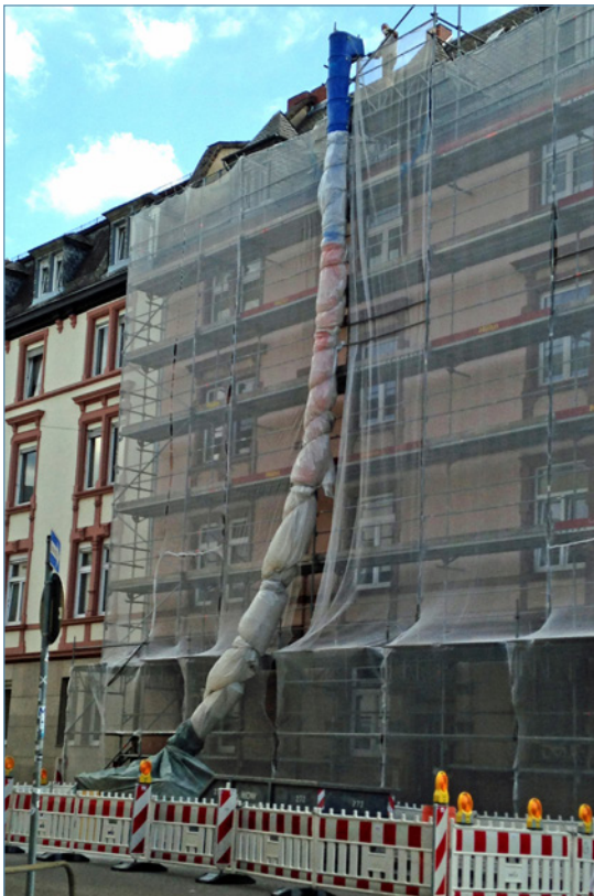
Abbildung 4: Schuttrutschen und -container sind dicht umhüllt
