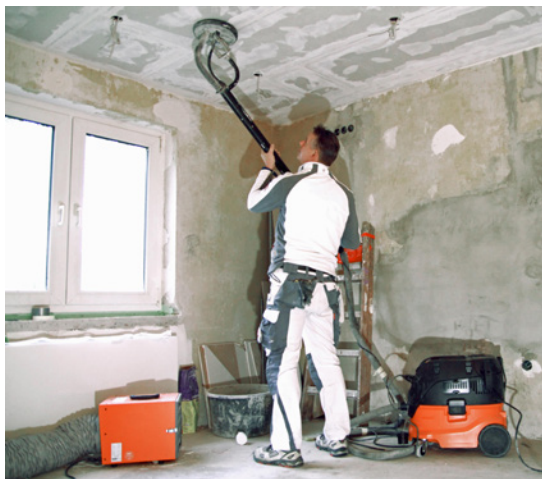
Abbildung 24: Luftreiner (links) und Bau-Entstauber im Einsatz
