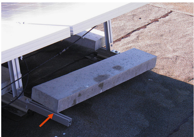
Bild 48: Balance-Akt – Lagesicherheit der Beschwerung unzureichend
