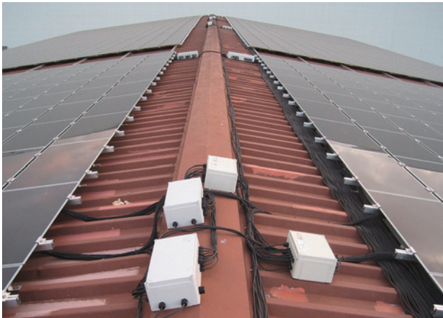
Bild 62: ungeschützte, auf Dachhaut aufliegende Leitungen entsprechen nicht den anerkannten Regeln der Technik.
