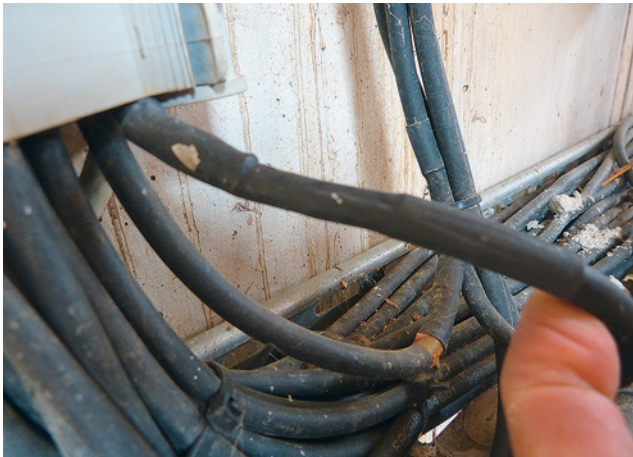
Bild 75: nicht statthafte Leitungsverlängerungen und Isolierung mittels Schrumpfschlauch
