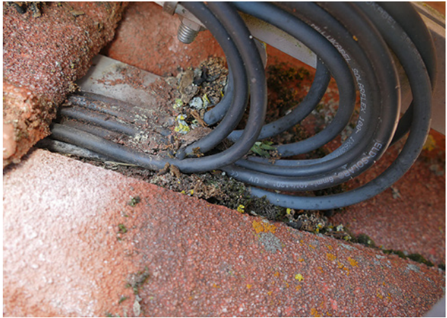
Bild 76: durch Ziegel gequetschte Leitungen
