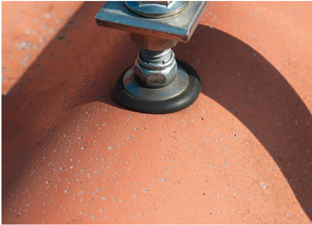
Bild 45: ... und zu fest angezogene Stockschraube mit Überbeanspruchung der Dichtung und Oberwelle der Dacheindeckung
