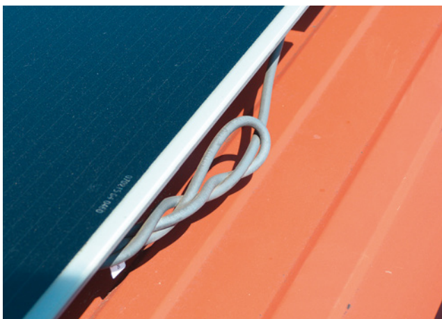
Bild 60: verbleichtes Kabel (ehemals schwarze Farbe) an einer drei Jahre alten Anlage
