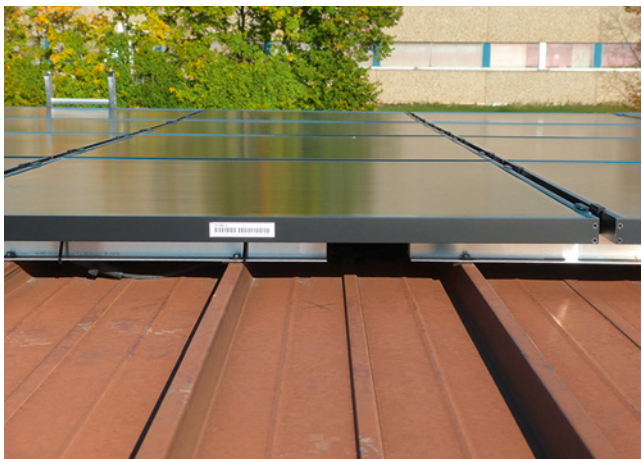
Bild 51: falsche Anordnung einer Dehnungsfuge unterhalb einer Modulreihe
