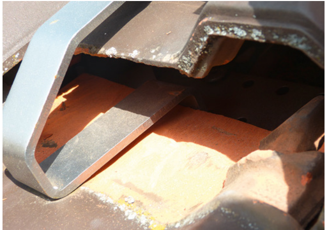
Bild 37: Komplett ausgeschliffene Kopfverfaltung am Ziegel begünstigt den Einrieb von Niederschlag.
