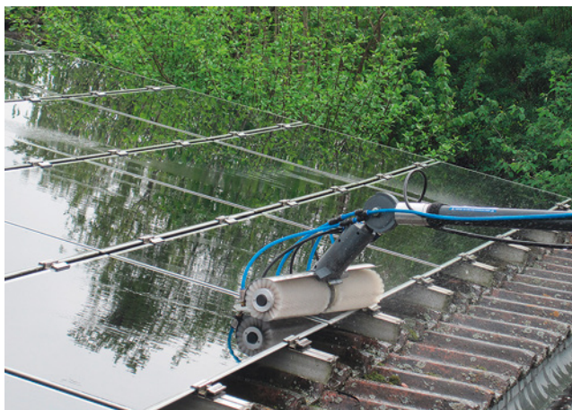
Bild 185: professionelle Reinigung mit aufbereitetem Wasser
