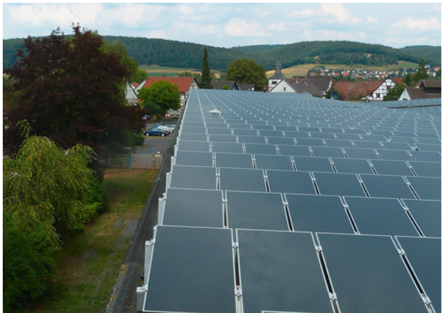
Bild 18: Modulmontage bis an exponierte Stelle am Dachrand – Absturzsicherung?
