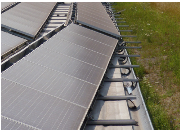
Bild 50: Lageverschiebung von sogenannten Leichtbausystemen
