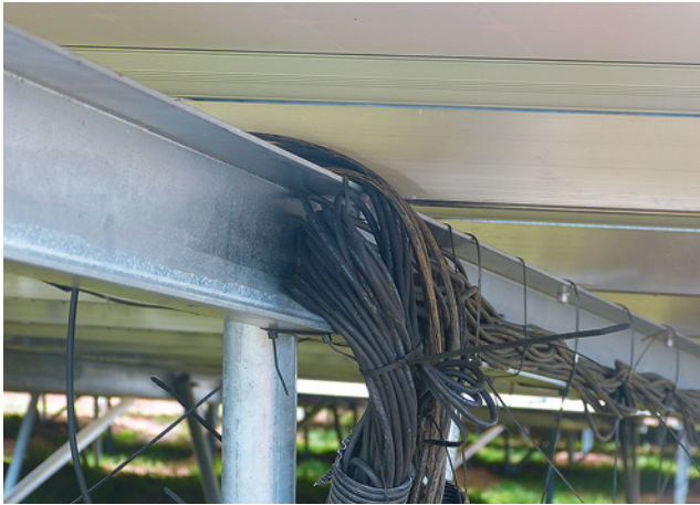
Bild 66: keine dauerhafte Leitungsbefestigung – ein Abreißen ist vorprogrammiert
