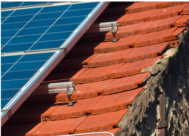
Bild 40: Stockschraubenbefestigung bei Dachziegel geht selten gut
