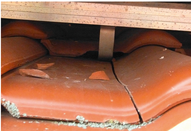
Bild 36: Aufliegende Dachhaken begünstigen Ziegelbruch.
