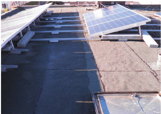
Bild 47: unterschiedliche Beschwerungsanordnungen ohne feste und dauerhafte Auflagerung
