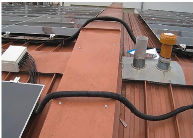
Bild 137: ohne zusätzlichen Schutz überführte Kabelbündel bei einer Brandschutzwand
