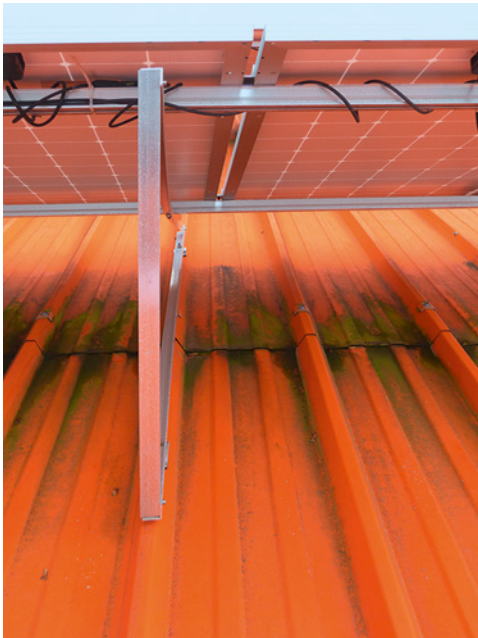
Bild 30: verbogene Ständerkonstruktion, zu schwache Querschnitte
