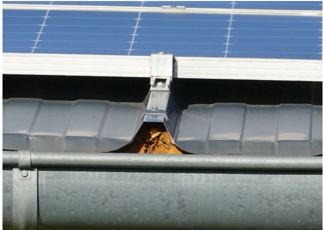
Bild 43: Die Befestigung auf der Oberschale des Sandwichelementes ist nach Bauregelliste nicht geregelt.
