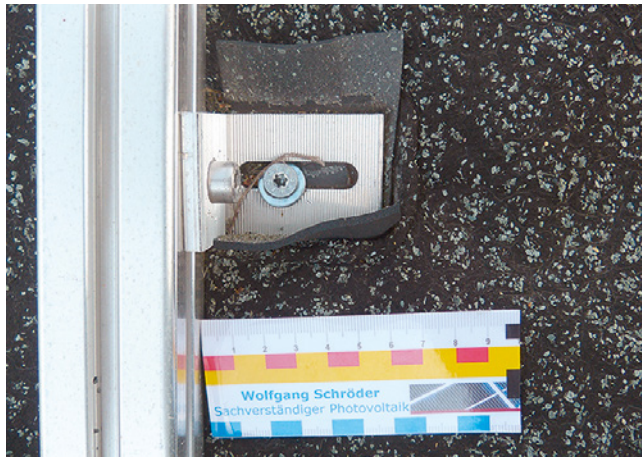
Bild 155: direktes Durchschrauben einer Abdichtungsbahn; der darunter gelegte Elastomerstreifen ist hier nur Kosmetik, das Dach ist undicht
