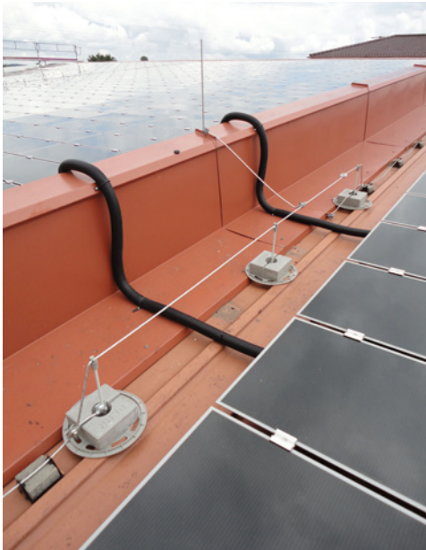
Bild 133: Trotz Brücke des Blitzableiters kein Trennungsabstand, da Dachblech auf dem gleichen Potenzial wie Blitzschutz liegt.
