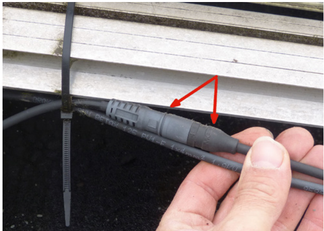
Bild 89: unterschiedliche Steckerfabrikate
