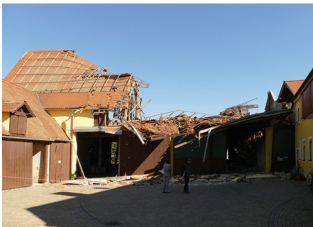
Bild 27: mangelhafte Tragfähigkeit des Gebäudes führt nicht selten zum plötzlichen Versagen
