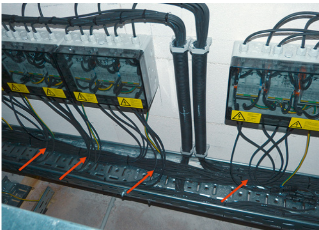
Bild 134: Vermischte Verlegung von Leitungen vor dem Überspannungsschutz (»schmutzige Leitungen«) und nach dem Überspannungsschutz (»saubere Leitungen«) können die Schutzwirkung durch Spannungseinkopplung wieder aufheben.
