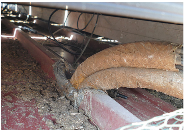
Bild 78: mangelhafte Leitungsdurchführung an Trapezblechdach
