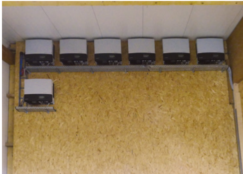
Bild 120: zu geringer Abstand zur oberen Begrenzung, dadurch erheblicher Wärmestau – in Verbindung mit Holzdecke in brandschutztechnischer Hinsicht problematisch
