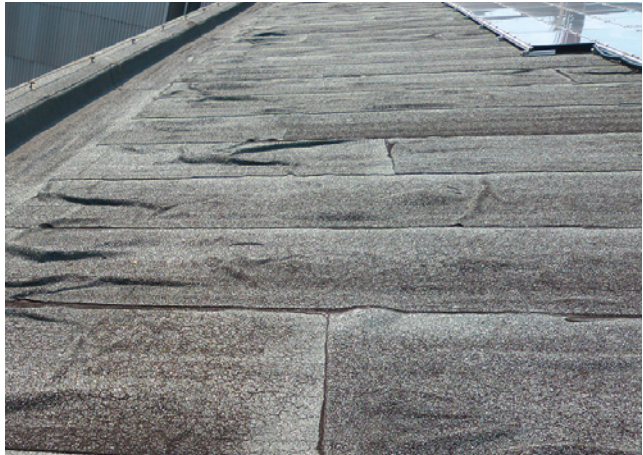
Bild 150: kritischer Zustand einer Flachdachabdichtung – zumindest in diesem Zustand nicht für den Bau einer Photovoltaikanlage geeignet
