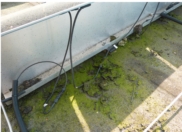
Bild 63: Leitungen und Stecker in einem bereits vermoosten Stauwasserbereich auf einem Flachdach
