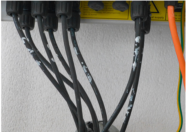
Bild 142: nicht entzifferbare Stringbeschriftung
