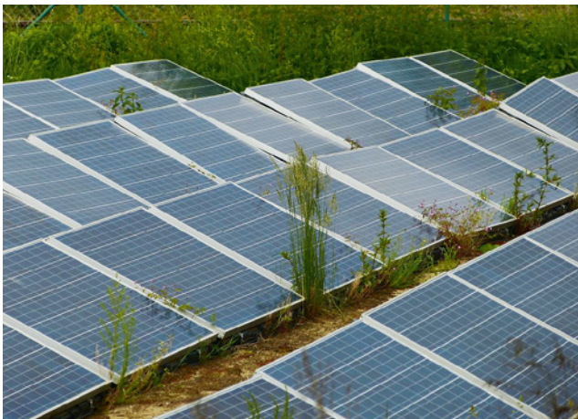
Bild 23: Bewuchs durch fehlende oder regelmäßige Grünpflege
