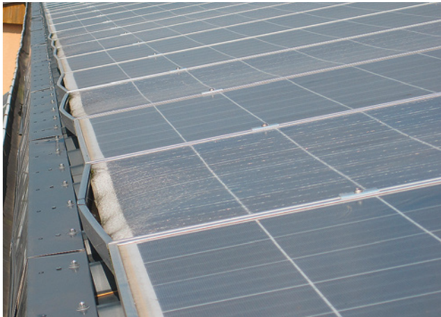
Bild 113: Schneedruckscha- den
