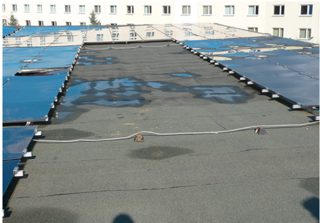
Bild 130: oftmals anzutreffen: überbauter äußerer Blitzschutz
