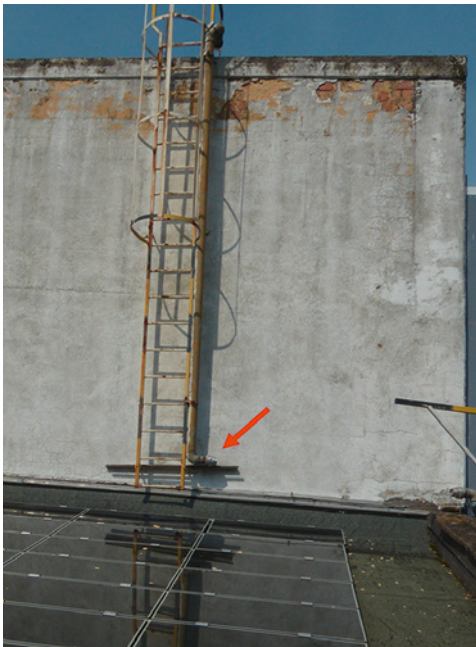
Bild 138: mit Modulen zugebauer Dachzugang mit stationärer Löschwasserzufuhr
