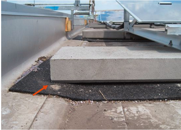
Bild 151: Punktueller Auflager im Abdichtungsrandbereich führt früher oder später zu Schäden.
