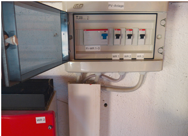
Bild 144: einfache aber übersichtliche Anlagenkennzeichnung
