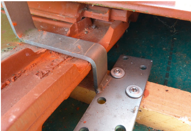
Bild 35: nicht fachgerechte Bearbeitung des Ziegels (per Hand ausgeschlagen, nicht gefräst)
