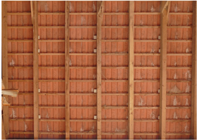
Bild 33: Situation vor Ort mit lastfreiem Dachsparren, ohne über alle Sparren verteilt angeordnete Befestigungspunkte
