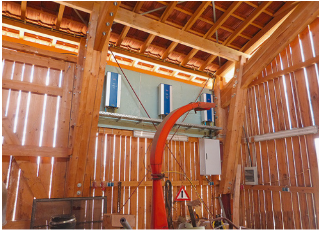
Bild 121: immer wieder problematisch: Wechselrichter in landwirtschaftlichen Gebäuden
