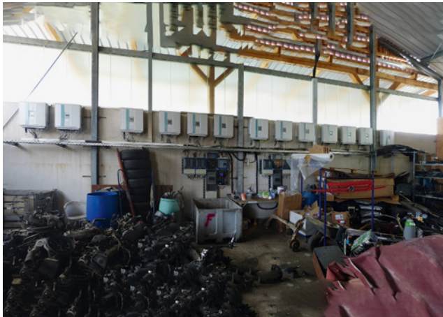
Bild 122: Problematisches Umfeld, nicht nur für die Wechselrichter, sondern für die gesamte elektrische Anlage.
