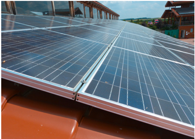
Bild 54: problematisch: Klemmbefestigung mit Beilagscheibe
