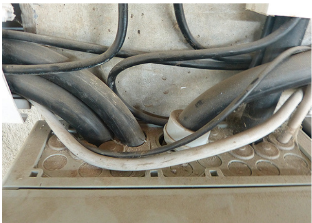
Bild 125: unsachgemäße Kabeleinführungen heben die Schutzklasse des Verteilergehäuses auf
