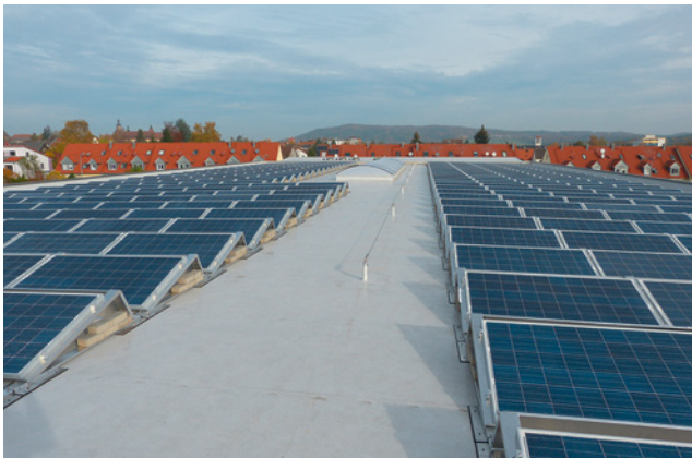
Bild 16: Seltener Anblick: Flachdach mit Sicherungseinrichtung
