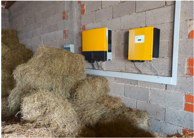
Bild 135: oftmals anzutreffen: problematische Wechselrichter- montagen in landwirtschaft- lichen Gebäuden
