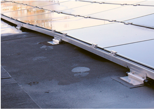
Bild 153: immer kritisch: punktuelle Auflager auf Bitumenbahnen
