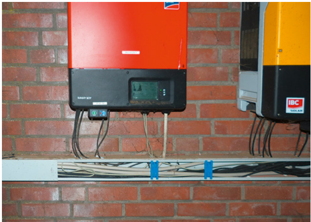
Bild 124: vermischte Leitungsverlegung (DC-AC-Datenleitung)
