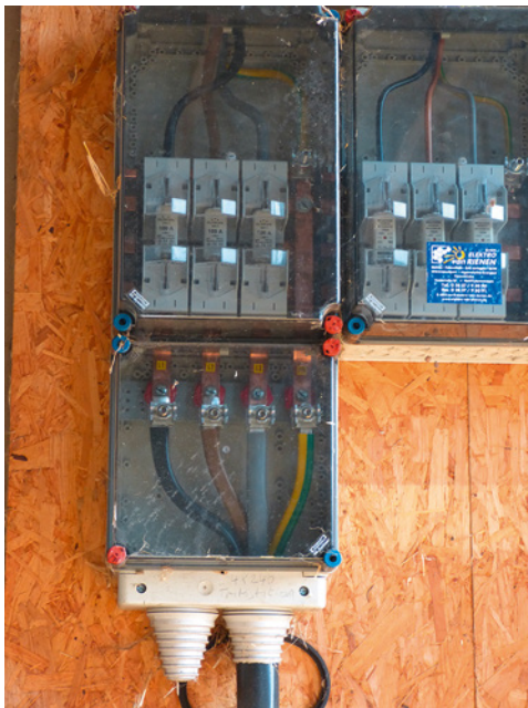
Bild 128: problematisch: PEN-Leiter an einer PV- Unterverteilung in einem landwirtschaftlichen Betrieb; dazu noch fehlende Kennzeichnung
