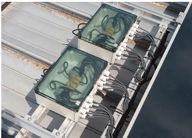
Bild 146: zuvor genannter Warnhinweis fehlt hier
