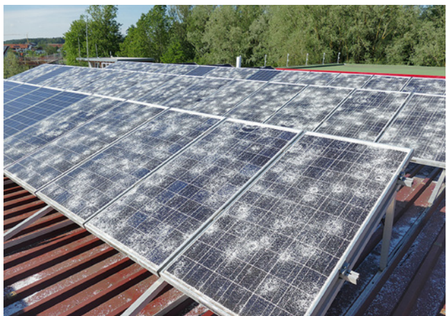
Bild 111: Hagelschaden
