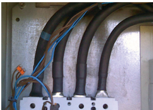
Bild 167: Auffällige Erwärmung einer Leitung (vermutlich zu hoher Widerstand an einem fehlerhaften Leitungsanschluss)
