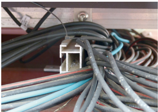
Bild 57: Bei so viel Kabelgewirr kann man sicherlich nicht von einer kurzschluss sicheren Verlegung sprechen.
