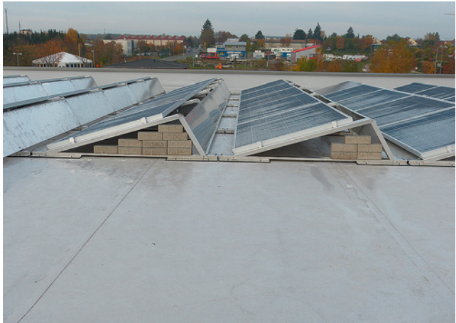
Bild 46: nicht standsicher aufgeschichtete Pflastersteine in unterschiedlicher Anzahl
