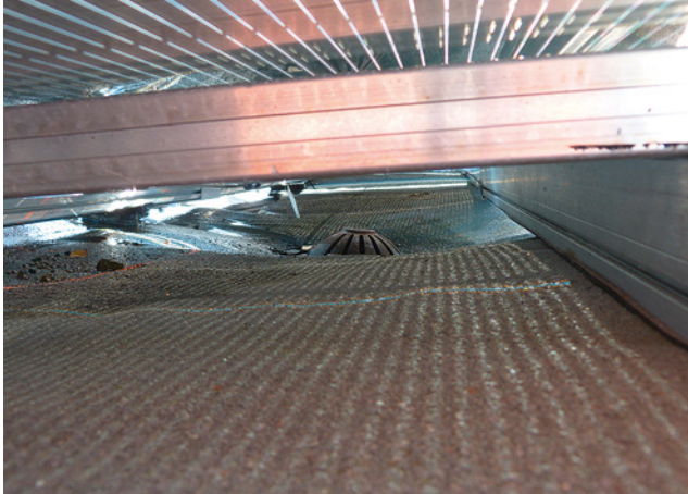
Bild 152: überbaute Dachabläufe – keine Chance auf Wartung
