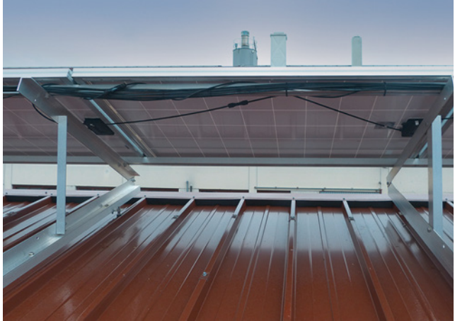
Bild 72: quer verstringte Module mit von der Anschlussdose gegenläufiger und auf Zug befestigter Kabelführung
