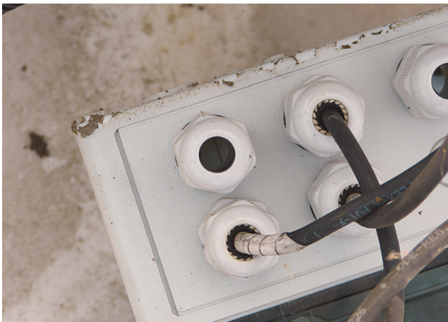
Bild 84: nicht verschlossene oder nicht zum Kabelquerschnitt passende Kabeldurchführungen
