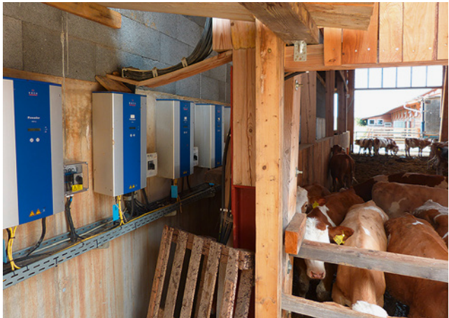
Bild 136: nicht nur wegen des Brandschutzes und schwierigen Zugangs zu den Wechselrichtern problematisch – Tiere können sehr neugierig sein
