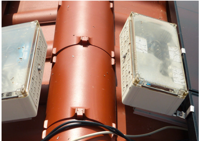
Bild 85: Kondenswasserbildung in Generatoranschlusskasten bei gleichzeitigen ungeschützten, exponierten Montageort
