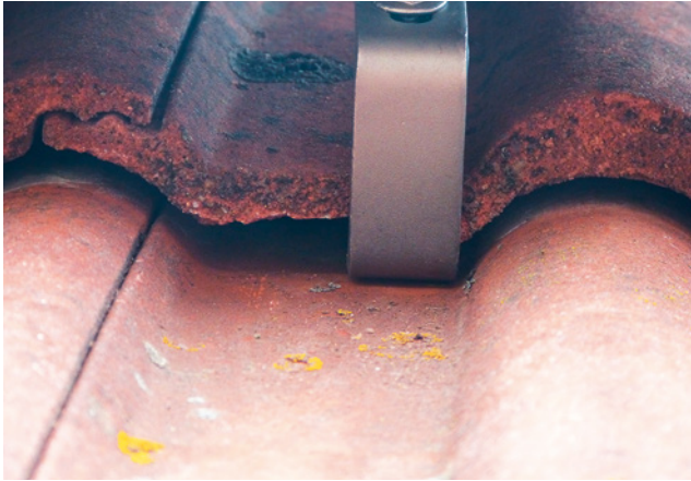
Bild 39: Falsche Dachhakenhöhe beeinträchtigt Regensicherheit.
