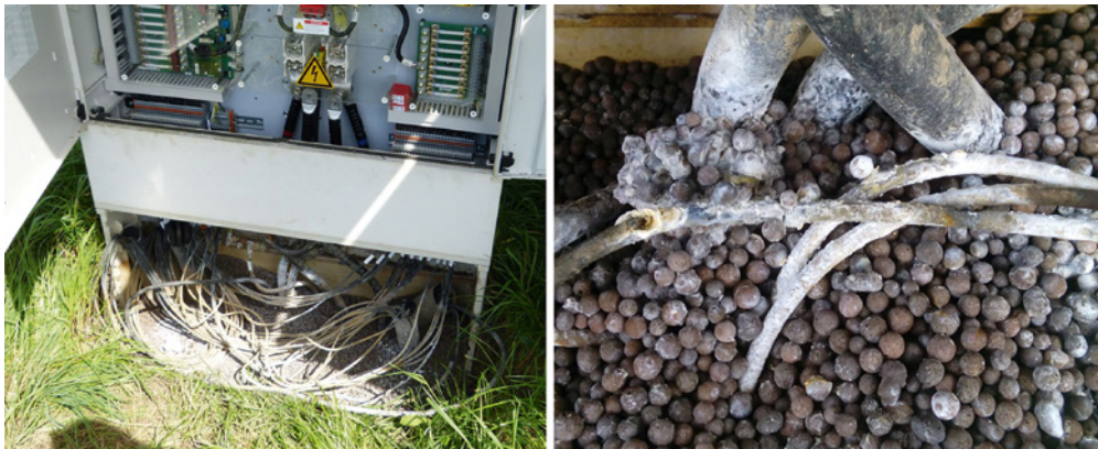
Bild 70: durchgeschlagene Strangleitungen aufgrund Dauerfeuchte im Bereich GAK-Einführung
