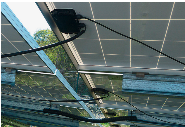
Bild 156: ein nicht seltener Anblick bei Freifeldanlagen: hängende Leitungen mit Überbeanspruchung im Bereich der Modulanschlussdose
