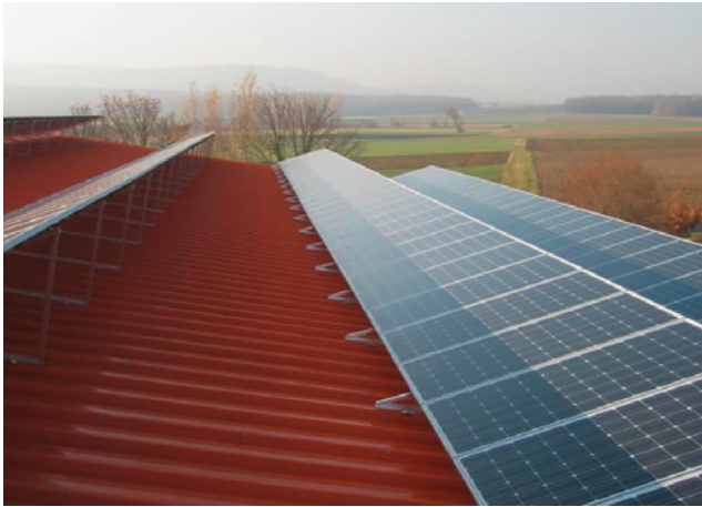
Bild 22: Zu geringer Reihenabstand und Hochkantmontage der Module bewirken »Vollverschattung« der Module.
