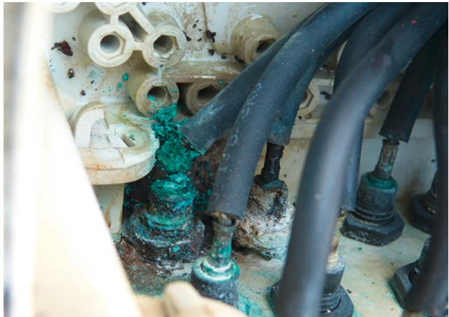
Bild 86: Korrodierte Leitungsanschlüsse (Grünspanbildung) in einem Generatorverteilergehäuse; aufgrund von angesammeltem Kondenswasser entstand ein Kurzschluss, der das Abschmoren einer Leitung zur Folge hatte.
