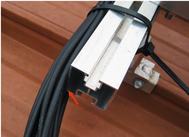
Bild 58: häufige Beanstandung: Leitungen an scharfen Metallkanten anliegend
