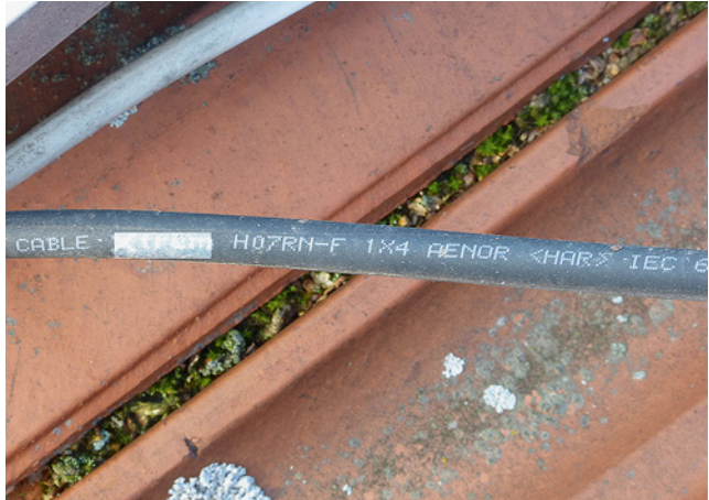
Bild 81: problematisch: Gummischlauchleitungen auf Dachflächen
