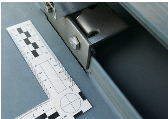
Bild 42: Temperaturbewegungen begünstigen Schäden an Auffaltung einer Titanzink-Blecheindeckung
