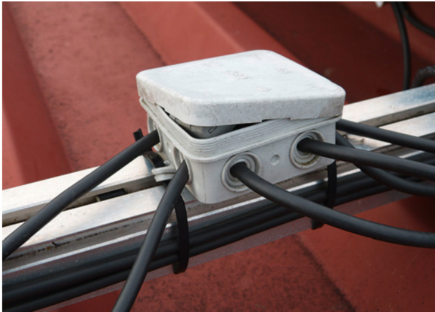
Bild 87: nicht geeignete Ausführung eines Generatoranschlusskastens mit nicht fest schließendem Deckel
