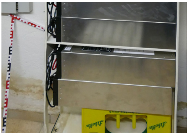
Bild 158: Schadensfall aus Überschwemmung bei bodennah aufgestellten Batteriemodulen
