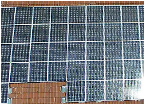
Bild 166: Achtung: Reflexionen (hier Sonne) können das Thermografieergebnis verfälschen
