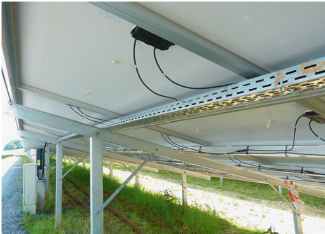
Bild 67: gutes Beispiel einer fachgerechten Leitungsverlegung bei Leitungsbündelungen und deren Schutz
