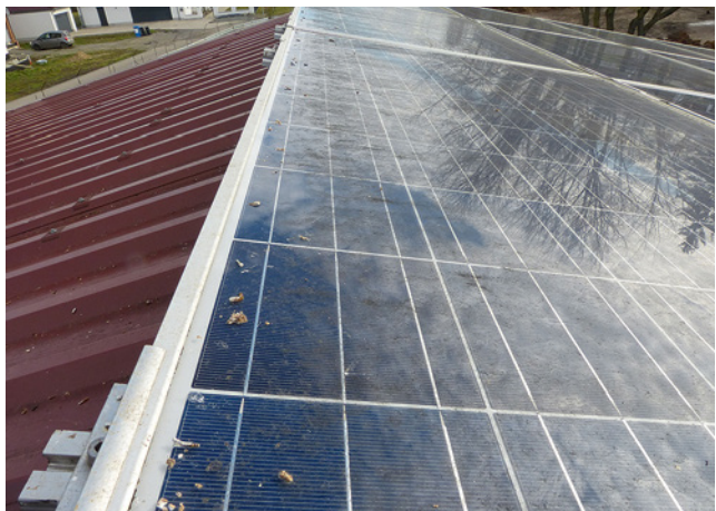
Bild 181: Über den First ragende Module laden Vögel zum Verweilen ein – mit Folgen.
