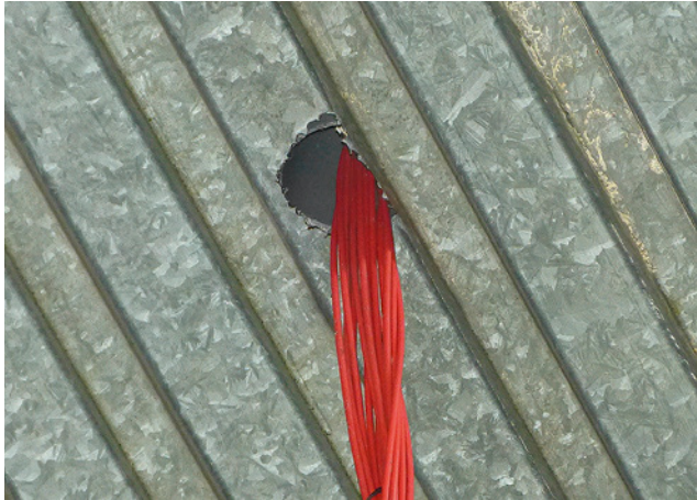
Bild 79: Leitungsbündel an ungeschützten, durch Aufbohren scharfen Metallkanten anliegend
