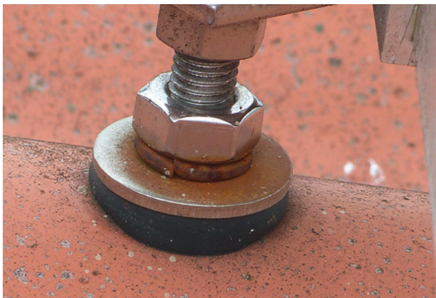
Bild 25: Fehlerhafte Materialauswahl (auch ungewollt) – hier korrodierte blanker Sprengring – beeinflusst die Dauerhaftigkeit des gesamten Bauteiles der Befestigung (Stockschraube).
