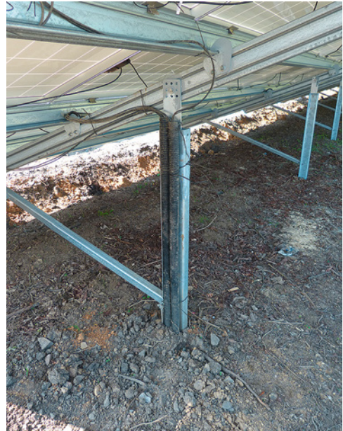
Bild 68: nur mit Kunststoffrohren geschützte Kabelabgänge bei Freifeldanlagen – insbesondere eine Gefahr bei Mäharbeiten
