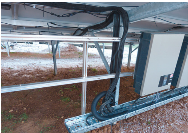
Bild 65: Nicht ausreichend befestigte Kabelbündelungen und ungeschützt über Metallkanten geführte Leitungen verkürzen deren Dauerhaftigkeit.
