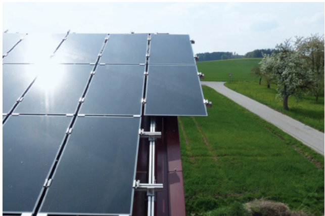
Bild 34: Über den Dachrand hinaus geführte Modulkonstruktion - schadensanfällig.
