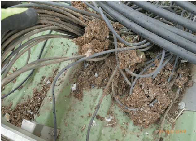
Bild 83: Taubenkot führt zu Leitungsbeschädigungen durch Verätzung
