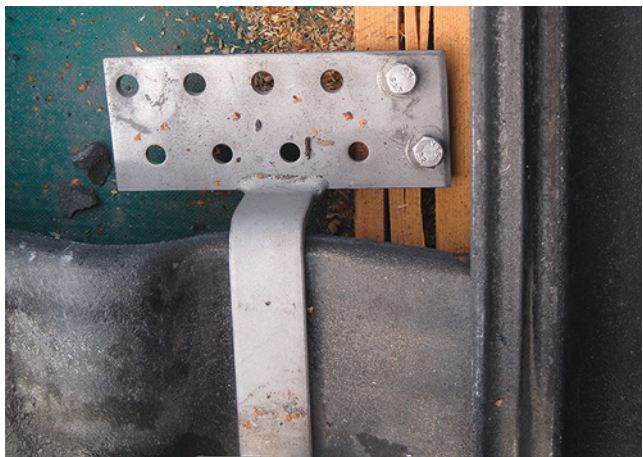
Bild 38: fachtechnisch nicht diskussionswürdige Dachhakenbefestigung
