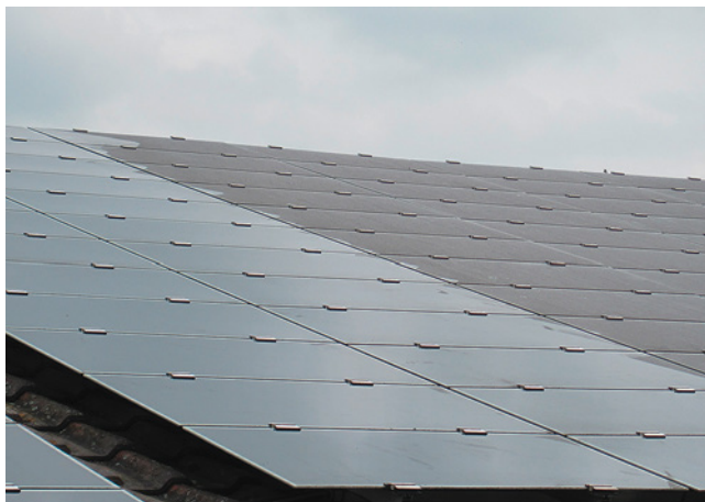
Bild 183: rd. 10 % Ertragsverbesserung nach erfolgter Reinigung bei dieser Beispielanlage
