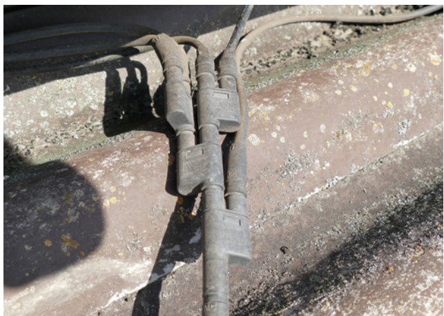
Bild 90: nicht geeignete Parallelverschaltung mit auf der Dachhaut liegenden und unzähligen Abzweigsteckern (nachlassende Steckfestigkeit durch Eigengewicht und mechanische Beanspruchung)
