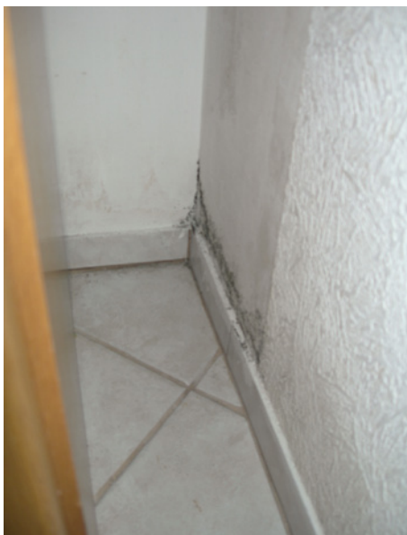
Abb. 6-11 Innenecke als Wärmebrücke zum unbeheizten Keller mit Schimmelpilzbefall
