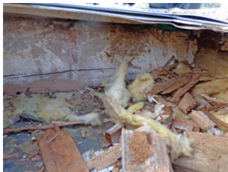
Abb. 8-17 Blick in das ausgeräumte Gefach mit der zerstörten Schalung oberhalb der Dampfsperre
