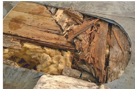
Abb. 8-10 Zerstörte Holzschalung unterhalb einer Kunststoff-Dachabdichtung
