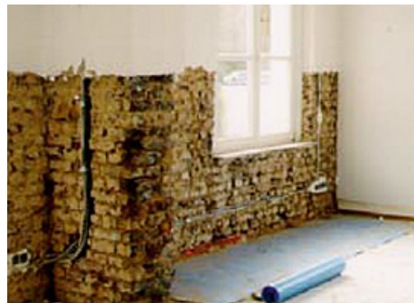
Abb. 10-46 Die Sanierungsarbeiten wurden gemäß DIN 68800 Teil 4 vorgenommen und erstreckten sich auch über die angrenzenden Wohnräume. Die Sanierungskosten beliefen sich auf ca. 35 000 €
