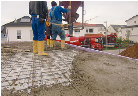
Abb. 10-27 Betonieren einer Betondecke
