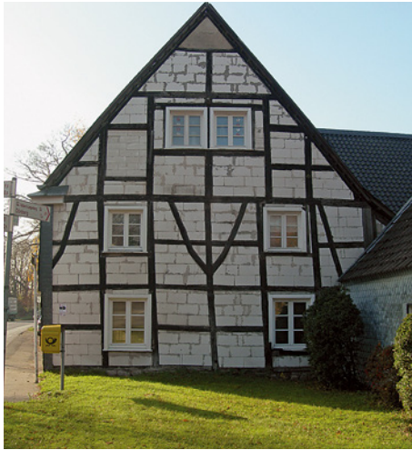
Abb. 8-14 Giebelwand eines Fachwerkhäuses mit ungeschützter Ausmauerung aus Porenbetonsteinen
