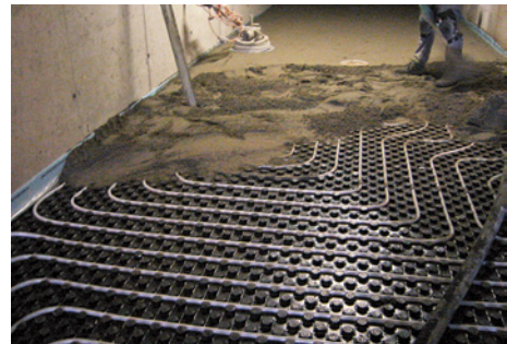
Abb. 10-28 Verlegung von Heizstrich
