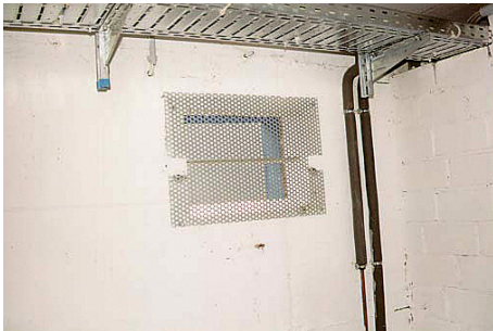
Abb. 6-23 Dieses Kellerfenster wurde nur mit einem Mäuseschutzgitter versehen
