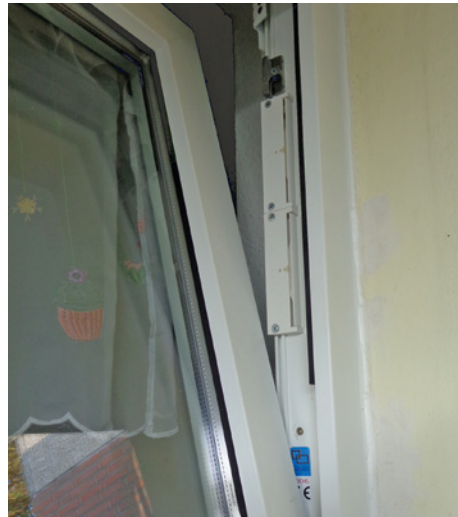
Abb. 6-19 Fensterfalzlüfter als Öffnung zum Nachführen von frischer Luft in eine Küche
