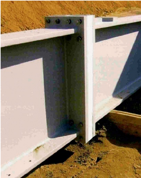
Abb. 4-23 Detail des Fassadendurchstoßpunkts der Stahlkonstruktion mit thermischer Trennung (Krieger Architekten/Ingenieure, Velbert, mit IPL Ingenieurplanung Leichtbau GmbH, Radolfzell)
