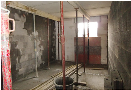
Abb. 10-34 Die Baukonstruktion ist durch Regeneintrag stark durchnässt
