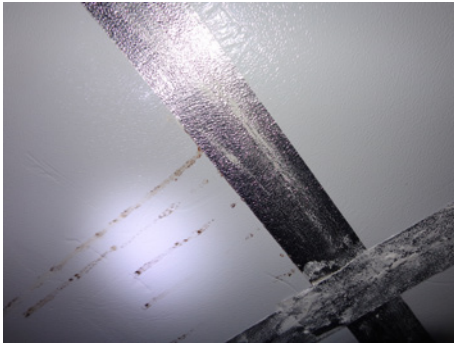
Abb. 4-37 Dampfdichte Fugendichtbänder auf einer aluminiumkaschierten Dämmplatte. Die Ablaufspuren zeigen Undichtigkeit im Stoßbereich an.
