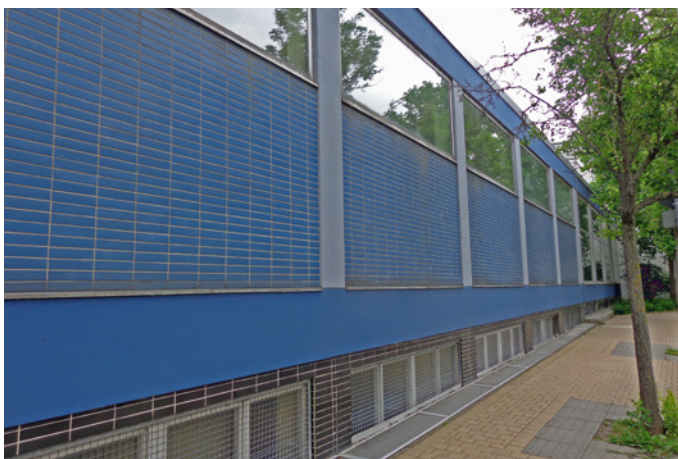
Abb. 5-3 Beispiel einer Turnhalle mit einer »inhomogenen« Ziegel-Beton-Fassadenkonstruktion und freistehenden Pfeilern
