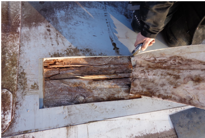
Abb. 8-6 Zerstörte Schalung durch eingeschlossene Feuchtigkeit unterhalb einer Kunststoffbahn eines Flachdachs
