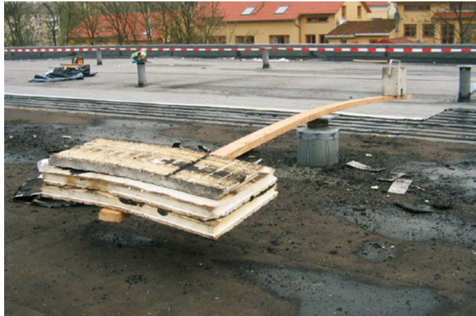
Abb. 8-5 Durchfeuchtete EPS-Dämmung auf einem Flachdach
