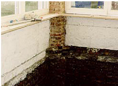
Abb. 10-45 Die Stahlbeton-Bodenplatte und der Verputz wurden rückgebaut, um die erforderlichen Sanierungsmaßnahmen vornehmen zu können
