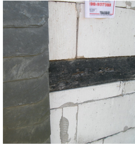
Abb. 8-15 Anschluss von Porenbetonstein auf Holzriegel ohne vorbeugenden konstruktiven Regenschutz
