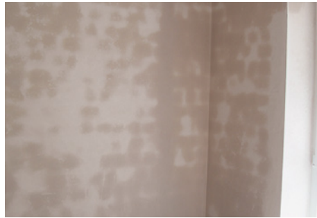
Abb. 10-35 Restfeuchte in einer verputzten Wand
