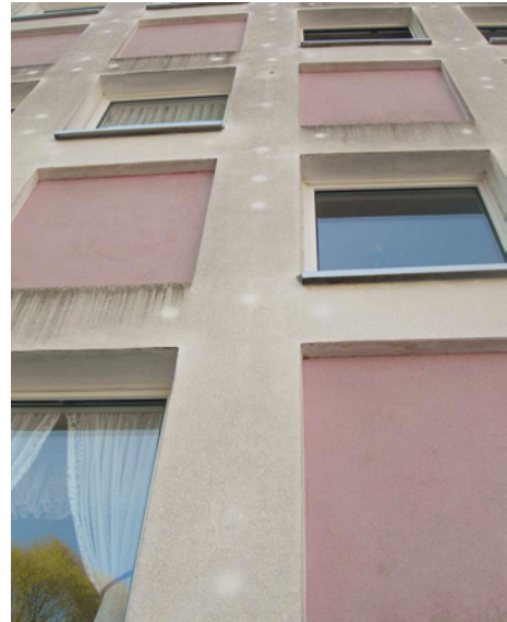
Abb. 3-2 Aufgrund des erhöhten Wärmestroms sind die Tellerdübel deutlich im Wärmedämmverbundsystem erkennbar. Die in diesem Bereich höhere Oberflächentemperatur führt zur schnelleren Trocknung des Putzes und verhindert damit einen Befall mit Algen.
