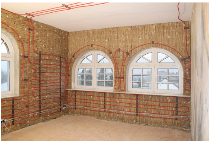
Abb. 10-17 Wandheizung in einem Denkmal (Quelle: WEM Wandheizung)
