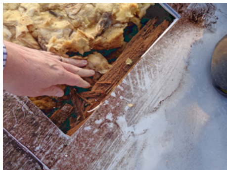
Abb. 8-16 Zerstörte Holzschalung auf einem Flachdach unterhalb einer Kunststoffdachabdichtung
