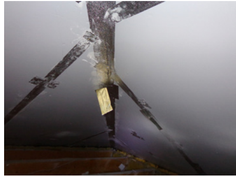
Abb. 4-38 Nach Jahren verliert der Kleber der Aluminium-Fugendichtbänder seine Wirkung und löst sich eigenständig.
