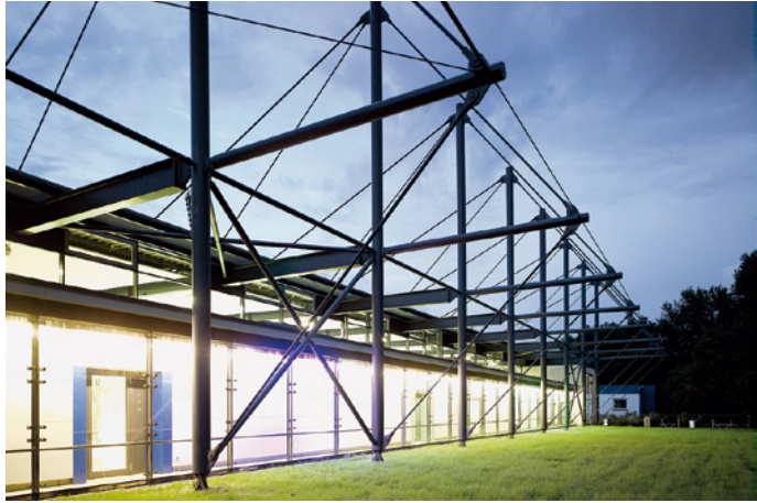
Abb. 4-22 Stahlkonstruktion mit thermischer Trennung in der Fassadenebene des Schwimmstadions Duisburg-Wedau (Krieger Architekten/Ingenieure, Velbert, mit IPL Ingenieurplanung Leichtbau GmbH, Radolfzell)
