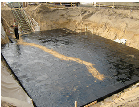
Abb. 10-18 Druckfeste Perimeterdämmung aus Schaumglas unter einer Bodenplatte (Quelle: Deutsche Foamglas GmbH)
