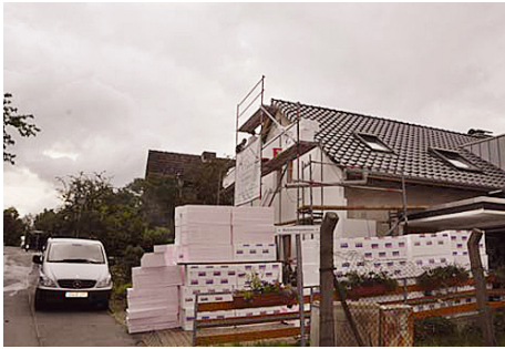
Abb. 10-32 Herstellung eines WdVS. Die zwischenlagerten Dämmplatten sind mit Kunststofffolien gegen Regen geschützt.
