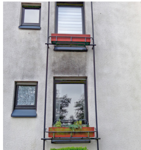
Abb. 10-7 Fenstersturz mit Pilzbefall aufgrund des Mieterverhaltens durch Dauerkippplüftung
