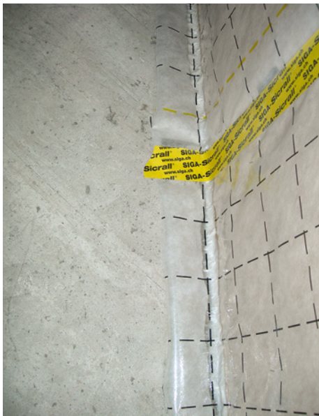
Abb. 4-35 Ausführung einer raumseitigen verklebten Folie im Dachbereich
