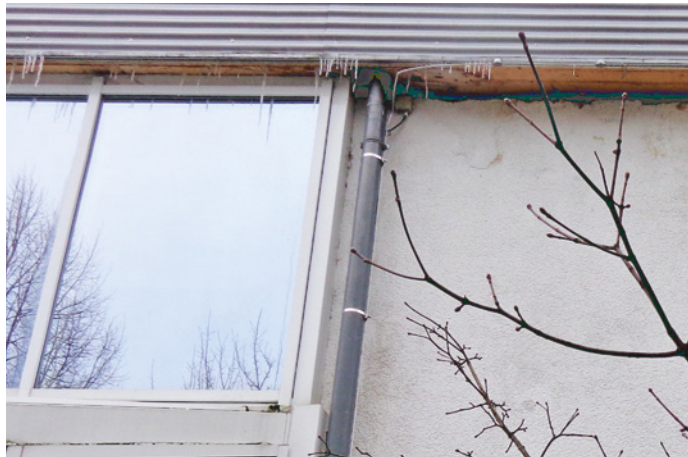
Abb. 4-32 Putzschäden und Eiszapfenbildung an der Unterkante der Blechverkleidung als Folge von Leckagen in der Luftdichtheitsebene eines Hallenbads
