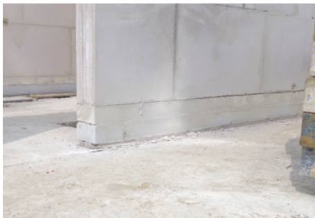
Abb. 10-29 Eine bei Regen ungeschützte Kimmsteinlage auf dem Rohboden einer offenen Baustelle.
