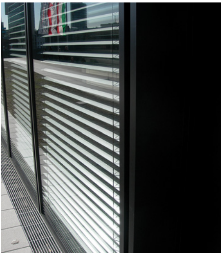
Abb. 9-1 Innenseitige helle Sonnenschutzlamellen mindern die einstrahlende Sonnenenergie um 20 %
