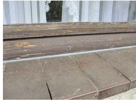
Abb. 6-5 Über das Abflussröhrchen erfolgt die Entwässerung auf die Außenfensterbank
