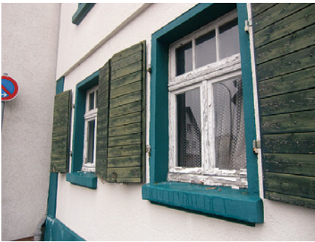
Abb. 6-2 Fenster aus den 1950er-Jahren mit Einscheibenverglasung
