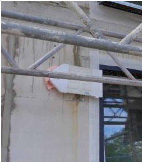
Abb. 6-18 Vormontierter Außenluftdurchlass (ALD) für erhöhte Anforderungen an den Schallschutz gegen Außenlärm im Wohnungsbau
