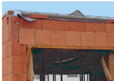
Abb. 10-30 Mauerwerkskrone mit Folienabdeckung als Schutz gegen Regenwasser
