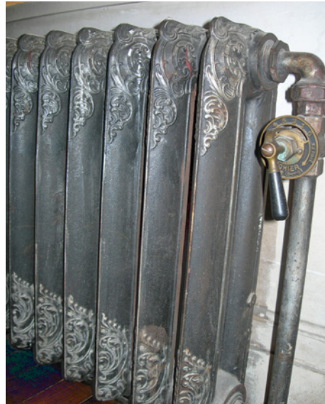
Abb. 6-27 Gussradiator – Wärmeübertragung mit einem höheren Anteil an langwelliger Strahlungswärme
