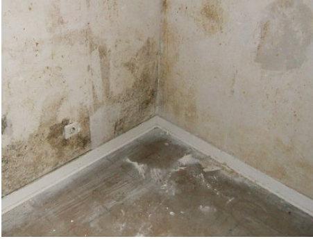
Abb. 4-15 Geometrische Wärmebrücke in Raumecke und oberhalb des Fußbodens ...
