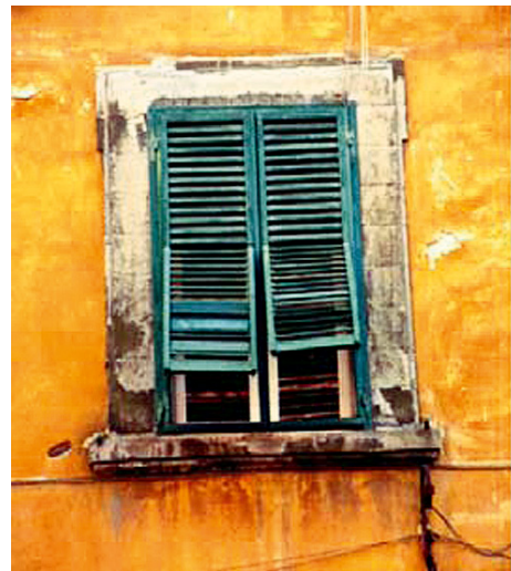
Abb. 9-2 Außen liegende Fensterläden mindern die einstrahlende Sonnenenergie um 70 %
