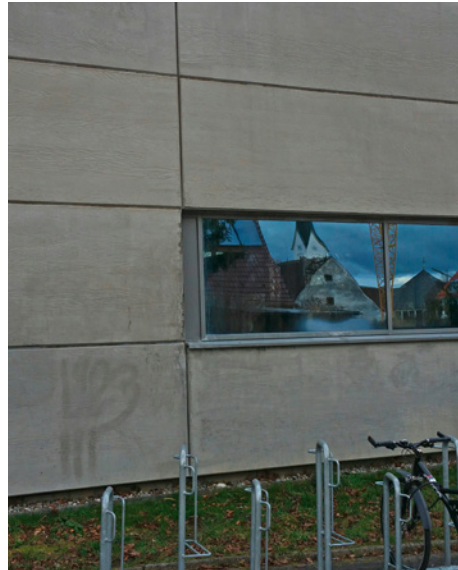
Abb. 4-43 Hallenbad mit einer vorgehängten Sichtbetonfassade. Im Bereich des oberen Fensteranschlusses hat die Konvektion der warmen Hallenluft bereits zu einem Schaden an den Sichtbetonelementen geführt.
