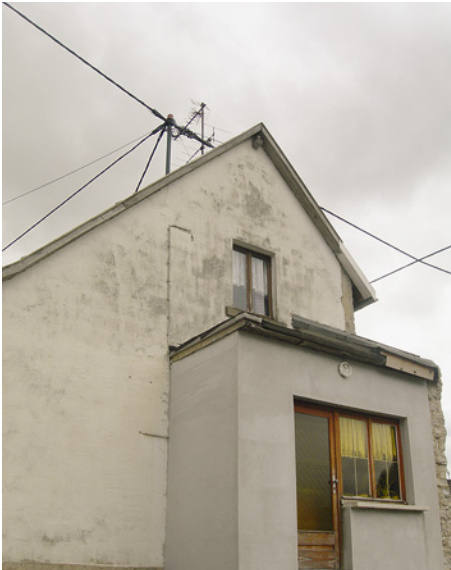
Abb. 3-1 Unterschiedlicher Wärmedurchgang der Bauteile Stein und Fuge bei einer Giebelwand eines Wohnhauses
