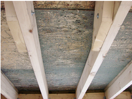
Abb. 10-39 Starker Schimmelpilzbefall in Dachkonstruktion eines Neubaus
