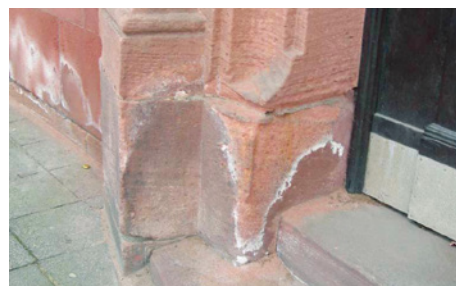
Abb. 8-20 Natursteinsockel mit Salzschäden durch die Verwendung von Tausalzen
