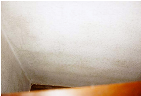
Abb. 7-3: Schimmelpilzbefall in einer Raumecke, begünstigt durch eine geometrische Wärmebrücke
