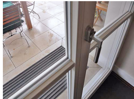
Abb. 6-3 Modernes Fenster mit hochwertiger Wärmeschutzverglasung
