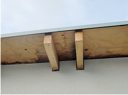
Abb. 10-37 Schimmelpilzbefall an Dachüberstand
