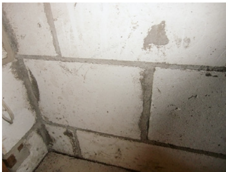
Abb. 4-8 Hier wurde Porenbetonmauerwerk nicht verklebt, sondern mit einem ungeeigneten Mörtel vermauert.
