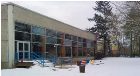
Abb. 4-44 Glasfassade eines Hallenbades. Der massive Sockel bildet die Außenseite des Rohrgangs. Bauzeit-typisch wurde die Außenwand des Rohrgangs als unge-dämmte Betonwand ausgeführt.
