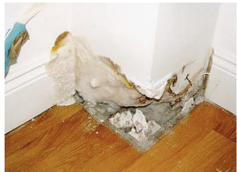
Abb. 10-42 Hinter der Fußleiste fanden sich stark entwickelte Myzelstränge
