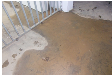
Abb. 6-24 Aufgrund dadurch verursachter Sommerkondensation wurde der Boden durch ausfallendes Tauwasser überflutet
