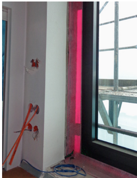
Abb. 4-36 Raumseitige Dichtbänder bei einer Fenster-sanierung
