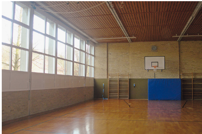
Abb. 9-14 Sporthalle, großes Raumvolumen mit geringer Wärmespeicherkapazität. Die Konstruktion der Wände geht nur zu einem Teil in die Bilanzierung ein. Der Gebäudetyp zählt zur leichten Bauart.
