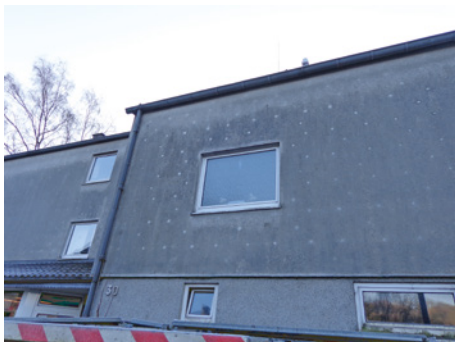
Abb. 10-9 Befallene Putzfassade. Die Anzahl der Tellerdübel lässt sich gut nachvollziehen
