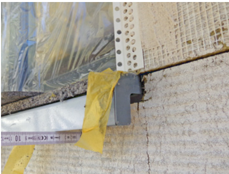
Abb. 10-2 Vorbereitetes Wärmedämmverbundsystem mit Kunststoffgewebeeinlage in der Putzebene und Putzschiene.
