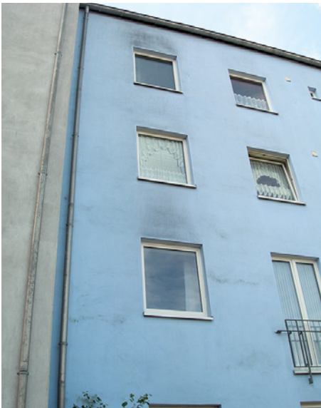
Abb. 6-21 Mikrobakterieller Befall im ersten und dritten Obergeschoss durch dauerhaftes Kipplüften auf der wärmedämmten Außenseite einer Fassade
