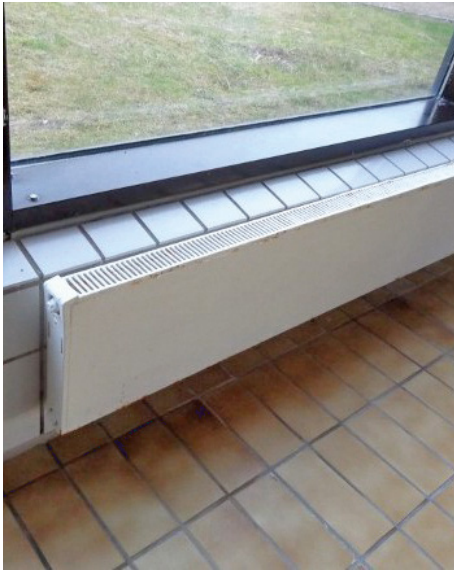
Abb. 6-26 Konvektor vor einer Glasfassade
