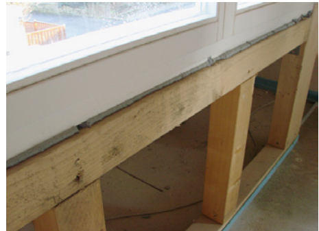
Abb. 10-40 Schimmelpilzbefall an Holzkonstruktion
