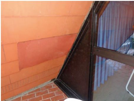
Abb. 4-39 Anschluss eines Fensterelements an eine hinterlüftete Fassade
