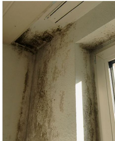
Abb. 6-22 Stark entwickelter Schimmelpilzbefall im Fensterbereich, hervorgerufen durch ständiges Kipplüften
