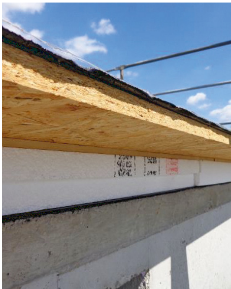
Abb. 4-18 Thermisch getrennte Konstruktion einer Attika mit EPS-Dämmung
