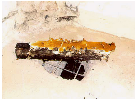
Abb. 10-44 Dieser Stützbalken der verlorenen Schalung war von Myzel und Fruchtkörpern des echten Hausschwamms überwachsen. Das Holz war bereits völlig zersetzt und wies keinerlei Stabilität mehr auf
