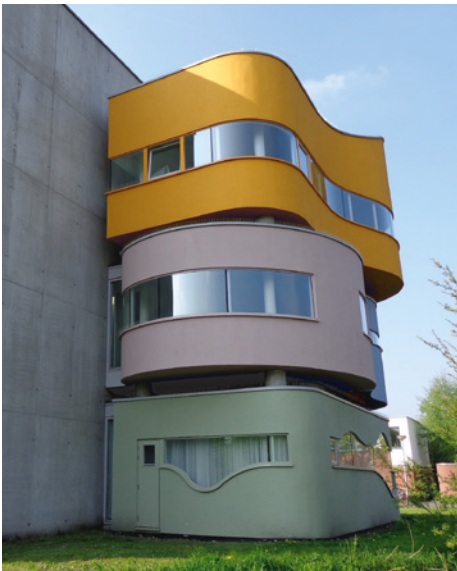
Abb. 4-4 Beispiel eines Wohnhauses, bei dem die wärmeübertragende Hüllfläche, durch die Trennung der Geschossdecken, maximiert wurde
