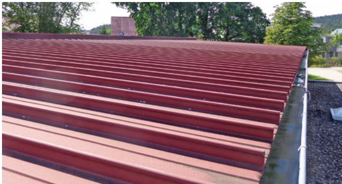
Abb. 8-13 Hinterlüftetes Metalldach an dessen Unterseite Sekundätauwasser ausfallen kann
