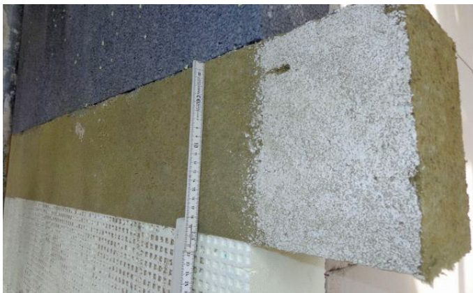
Abb. 10-11 Brandriegel aus Mineralwolle in einer gedämmten Fassade aus Polystyrol-Dämmplatten
