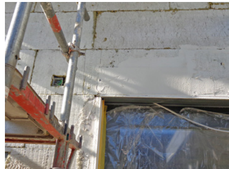
Abb. 10-3 WDVS mit fehlender Bewehrung im Eckbereich, um Spannungsrisse vorzubeugen.
