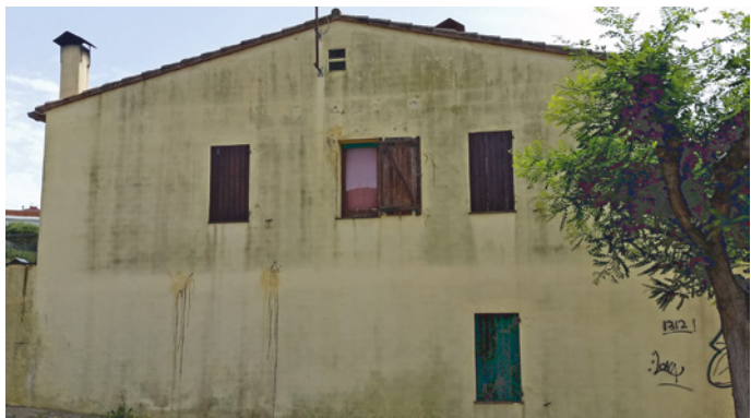
Abb. 4-7 Eine ungedämmte Außenwand, bei der durch Verschmutzungen deutlich der Unterschied der Wärmeleitfähigkeit zwischen Fuge und Stein, sowie der einbindenden Deckenplatte zu erkennen ist.
