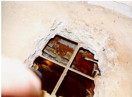
Abb. 10-43 Die Beton-Bodenplatte wurde geöffnet. Der darunter liegende Hohlraum war übersät mit Myzel und Fruchtkörpern des echten Hausschwamms
