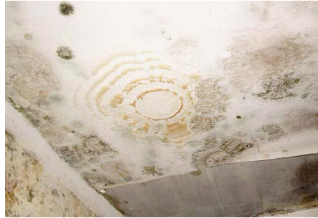
Abb. 7-2: Deutlich sichtbare Ringbildung der Ausbreitung eines Schimmelpilzes
