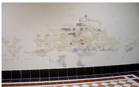
Abb. 8-19 Typisches Erscheinungsbild von Zerstörungen der Putzstruktur bei hygroskopisch aktiven Salzen in einer Mauerwerkswand
