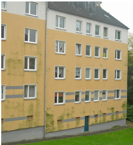
Abb. 10-6 Die Nähe zu Grünanlagen begünstigt den Befall mit Algen
