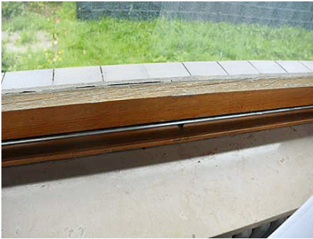
Abb. 6-4 Fenster mit Einscheibenverglasung, Kondensatfangrinne und Abflussröhrchen
