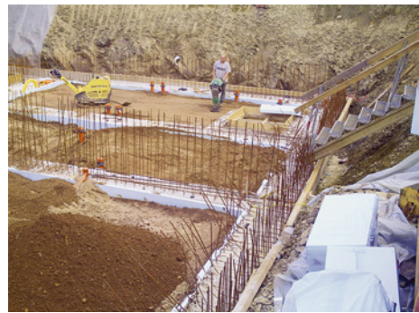
Abb. 10-19 Druckfeste Perimeterdämmung aus XPS als Flankendämmung an Streifenfundamenten
