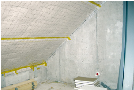
Abb. 8-9 Dampfsperre mit abgeklebten Überlappungen in den Stößen und an den Anschlüssen zur Betongiebelwand
