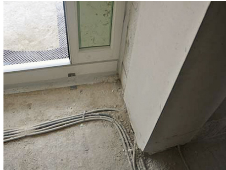
Abb. 6-7 ... Haustüren rundum mit Dichtbändern luftdicht an den Baukörper angeschlossen und eingeputzt.
