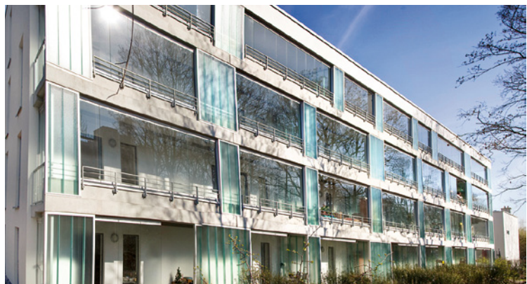
Abb. 4-20 Auskragende Balkonplatten in einem Wohnhaus in Erfttal (Agirbas/Wienstroer Architektur und Stadtplanung)
