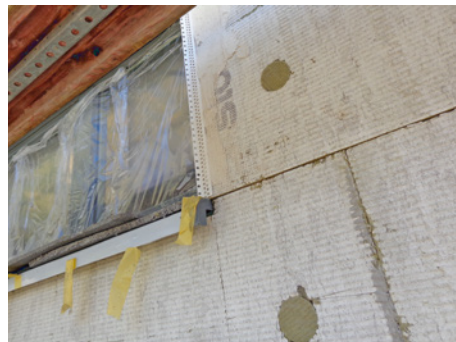
Abb. 10-10 Zur Vorbeugung werden Tellerdübel eingelassen und überdämmt
