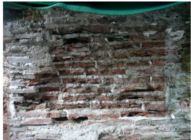
Abb. 19: Raum 13a, Musterfläche mit der Beschichtung aus Cyclododecan
