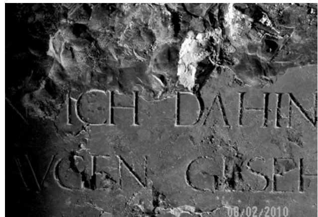
Abb. 15: Kalksteinoberfläche mit Schäden am Ulrichmonument
