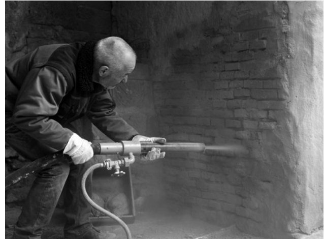
Abb. 11: Vorversuch für die Verarbeitung der Antragsmasse mit einer Trockenspritzanlage der Fa. Mader.
