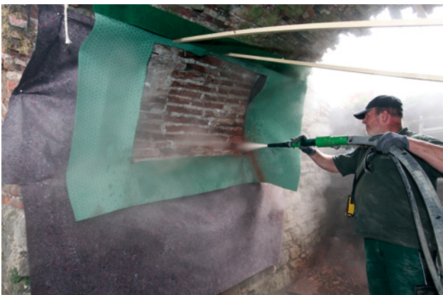
Abb. 20: Raum 13a, Musterfläche, Beschichtung im Trockenspritzverfahren
