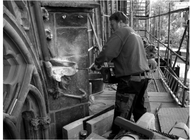
Abb. 20: Anbohren des Bestandsstumpfes „Fabelwesen“
