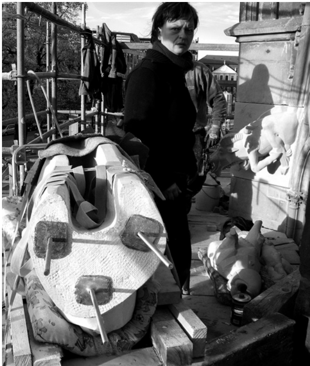
Abb. 23: Detail „Löwe“: eingeklebte Ankerstangen mit Abstandshaltern (Walzblei)
