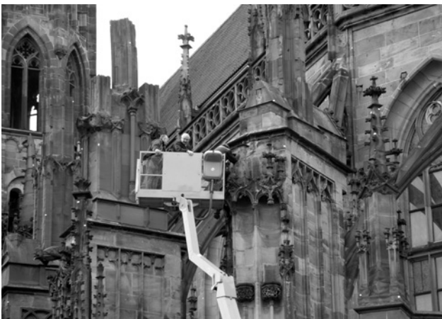
Abb. 6: Hubsteigerbefahrung
