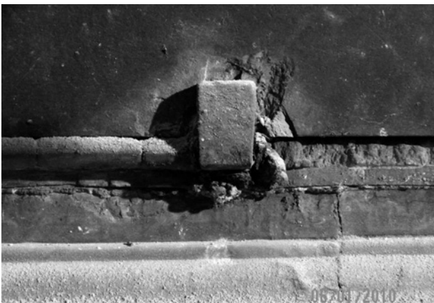
Abb. 18: Rostschädigung am Kalkstein und Alabaster, Ulrichmonument
