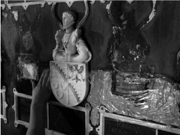
Abb. 22: Reinigungskompressen und Reinigung am Ulrichmonument
