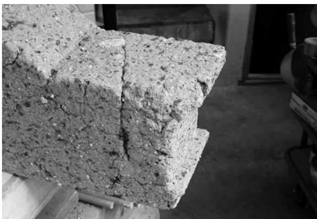
Abb. 19, 20: Schäden an den Werksteinen
