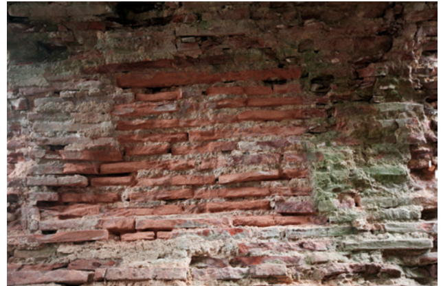
Abb. 23: Endzustand der ganzen Musterfläche nach dem Absaugen der Mörtelreste
