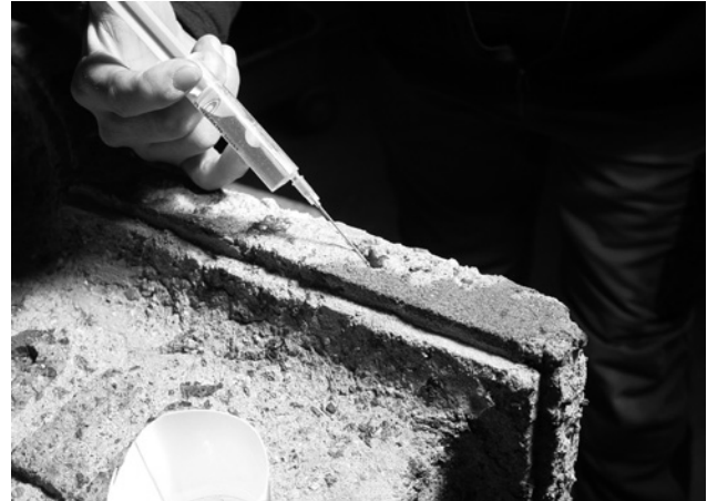
Abb. 22: Verfüllen von breiten Rissen
