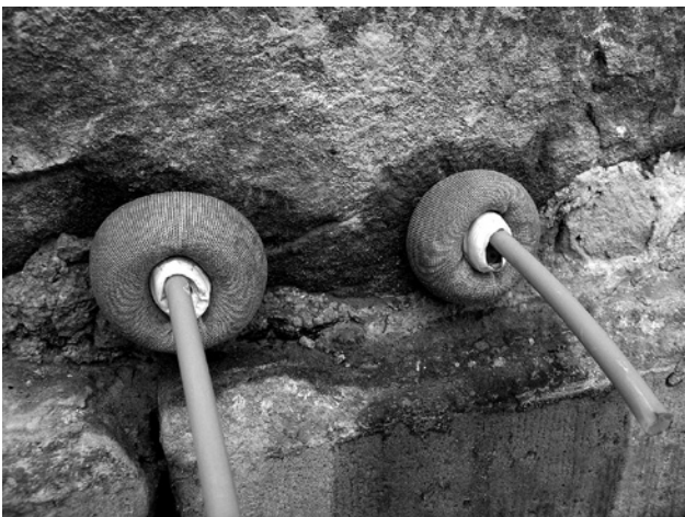
Abb. 5: aufgeblähter Gewebestrumpf (Bauvorhaben Ilmenau, historisches Amtshaus)
