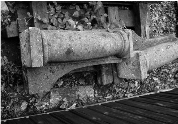
Abb. 13: unsachgemäß gelagerte Werksteine
