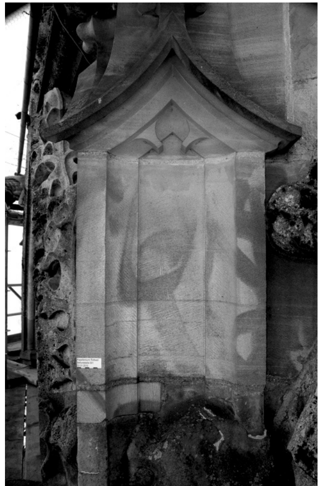
Abb. 2: Kapellenturm, Oktogonbereich, Vorzustand hydrophobierter Kordeler Sandstein mit abgedunkelten Streifenbildungen
