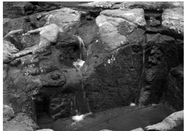
Abb. 4: Fuente de Lavapatas. Schäden durch Verlust der Oberflächen treten bevorzugt in den austrocknenden bzw. wechselfeuchten Bereichen auf. Zonen unterschiedlicher Durchfeuchtung geben sich durch Unterschiede im Bewuchs zu erkennen.
