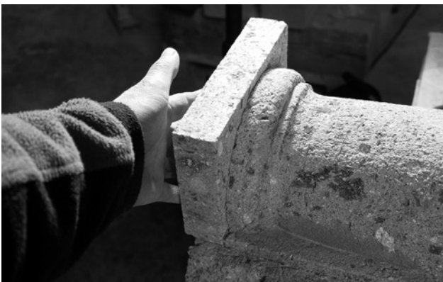
Abb. 27: Anpassen einer Vierung
