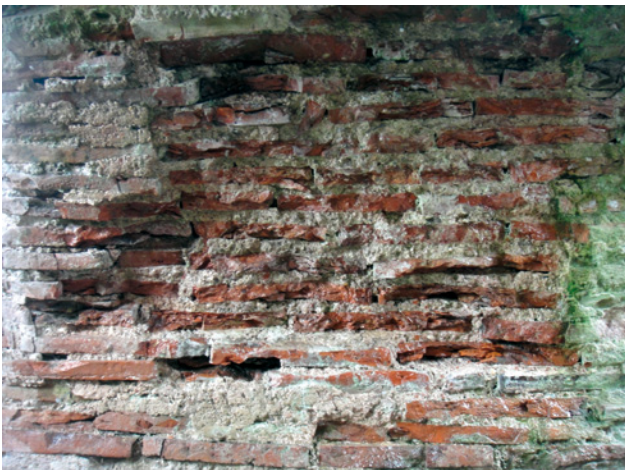
Abb. 18: Raum 13a, Musterfläche nach Abnahme von biologischem Bewuchs
