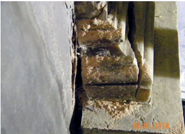
Abb. 10: Salzsäure-Schädigung am Alabaster und Kalkstein, Pilaster des Ulrichmonumentes
