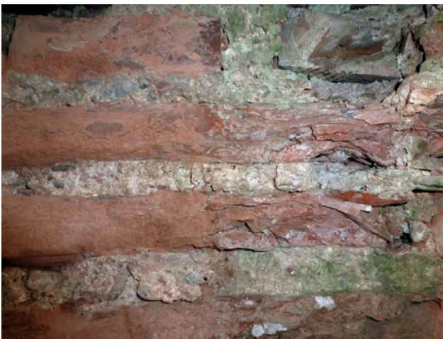
Abb. 26: Detail vom Endzustand an der Schnittstelle zwischen bearbeiteter Fläche und dem Vorzustand. Photo: Michael Auras
