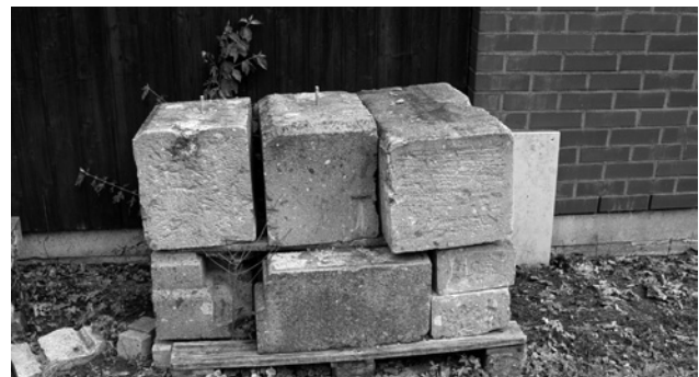
Abb. 12: unsachgemäß gelagerte Werksteine
