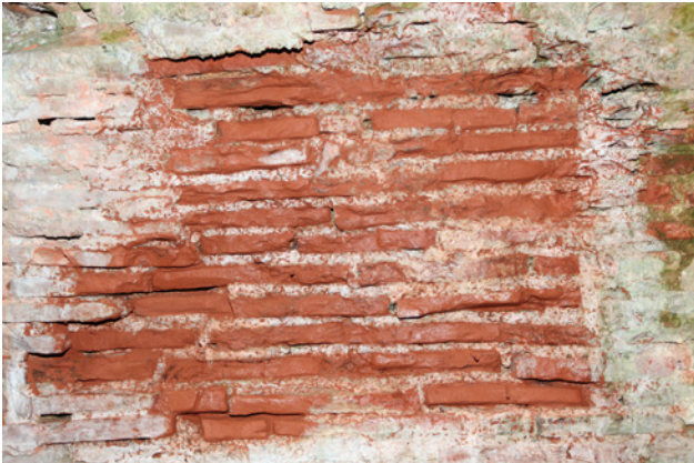
Abb. 22: Raum 13a, Musterfläche nach einer ersten Abnahme der Mörtelüberschüsse
