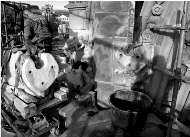
Abb. 21: Bestandsstumpf und Neuteil des „Löwen“
