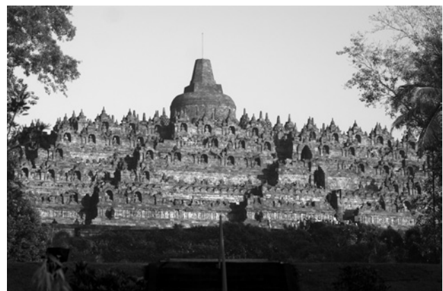
Abb. 7: Candi Borobudur. Erbaut aus basaltischen und andesitischen Laven, die von den umliegenden Vulkanen, darunter dem 25 km entfernten, hochaktiven Merapi (links) gefördert wurden.
