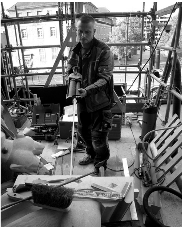
Abb. 22: Hybridmörtelinjektion des „Flughundes“
