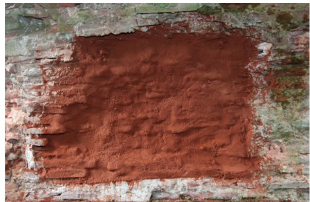
Abb. 21: Raum 13a, Musterfläche nach der Beschichtung
