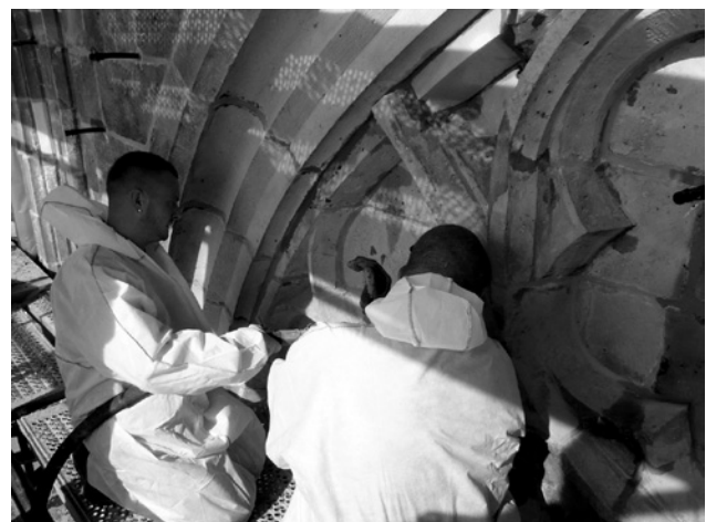
Abb. 12: Injektion des Mauerwerkes
