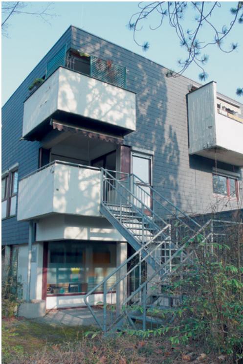
Abb. 4.3: 2.baulicher Rettungsweg aus dem Obergeschoss einer Kita
