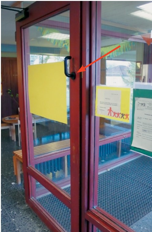
Abb. 4.5: Erhöhter Drückerbeschlag an Haupteingangstür Kita
