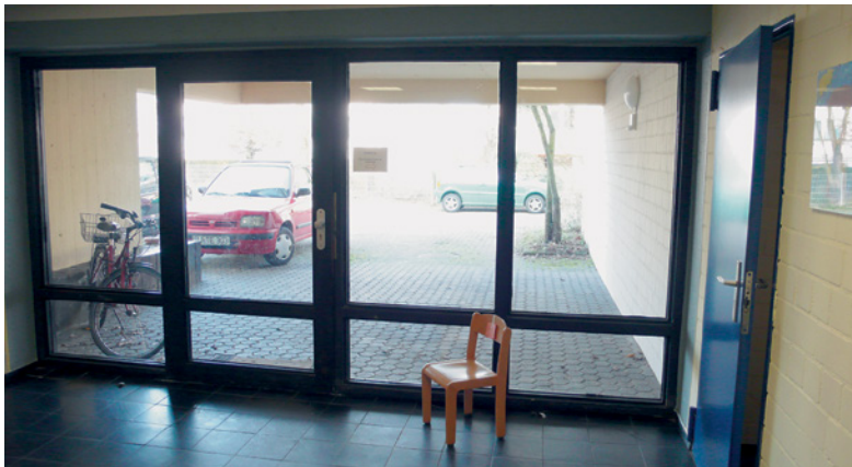
Abb. 5.1: verschlossene Außentür ohne Notfallentriegelung ...
