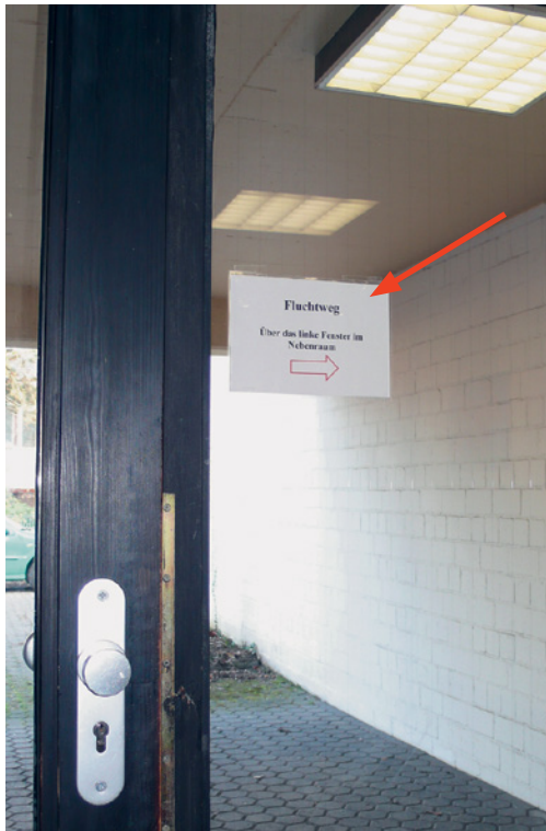
Abb. 5.2: ... aber mit Hinweisschild »Fluchtweg über linkes Fenster im Nebenraum«.
