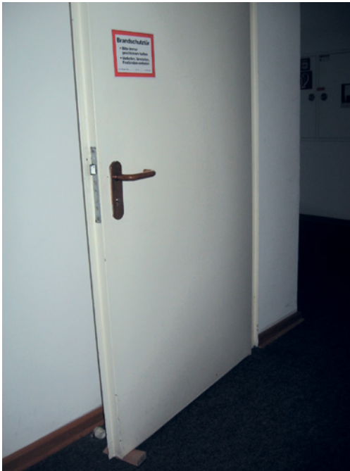
Abb. 5.3: Brandschutztür mit Holzkeil offengehalten – die Funktion der Türe ist somit erloschen und stellt eine konkrete Gefahr dar; siehe Kapitel 2.5
