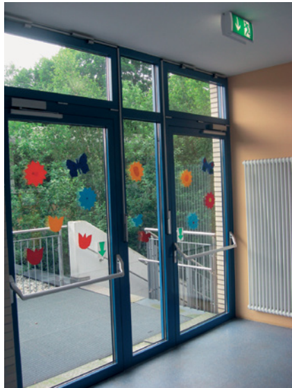
Abb. 4.6: Fluchttüre für 2. Rettungsweg im OG mit Anti-Panik-Beschlag
