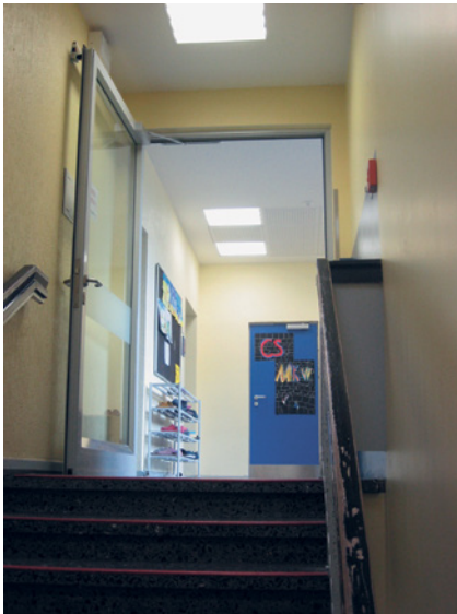
Abb. 4.9 und Abb. 4.10: Brandschutztüren mit Feststellanlagen zur brandschutztechnischen Abtrennung von Nutzungseinheit und notwendiger Treppe
