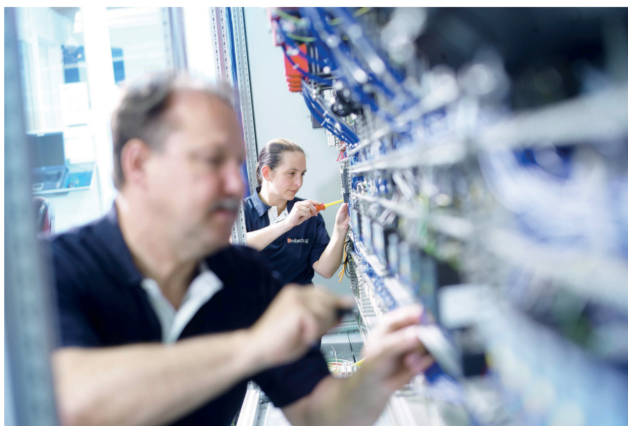
Damit ein Schaltschrank beim Kunden tatsächlich auf Antrieb funktioniert, muss er bereits beim Hersteller vollständig geprüft und für den Einsatz vorbereitet sein. Bild: Unitechnik
