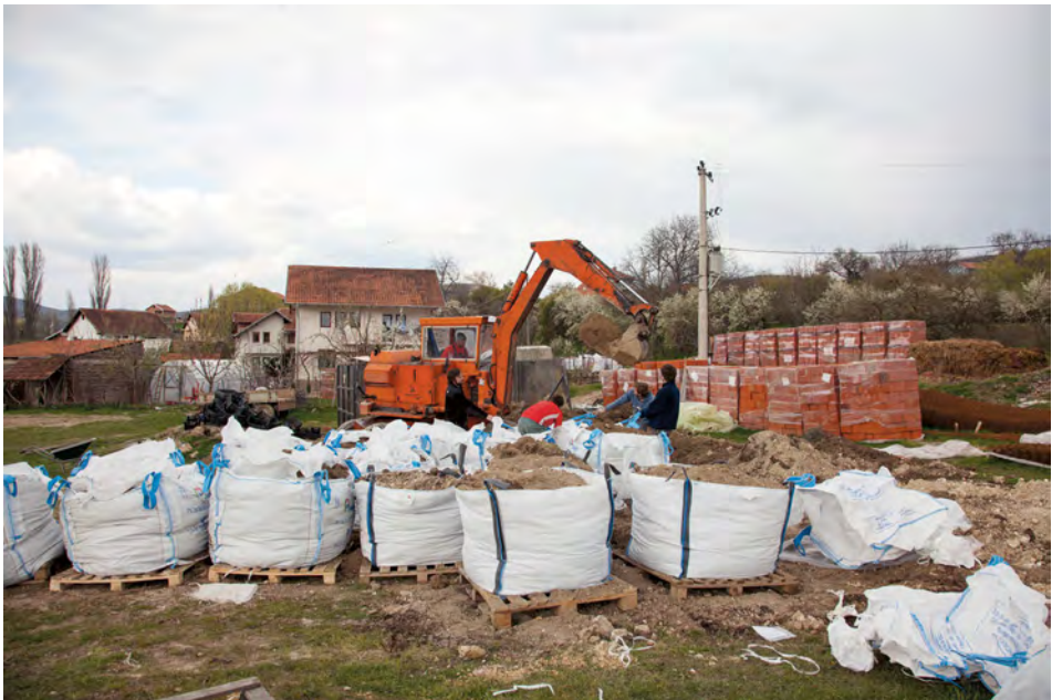
Abb. 49–50 Petrit Halilaj, Kostërrc (CH) , 2011 (Fotografien Entstehungsprozess; oben: hinterlassenes Loch durch die Erdentnahme in Kostërrc; unten: Beladung der Taschen mit Erde für Abtransport)
