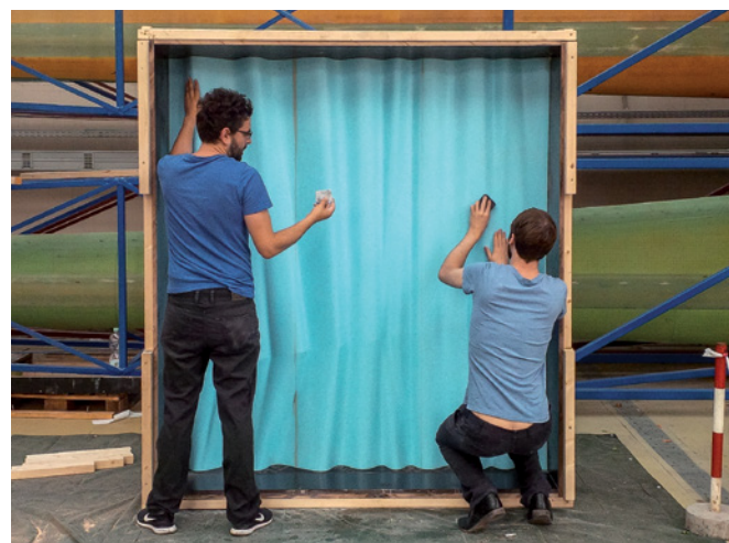
Bild 8-11 Bearbeitung des Schalungskörpers aus Polystyrol (Foto: Lukas Specks)
