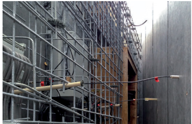
Bild 9-13 Small House I, Multiringensorelektroden (MRSE) für das Bauwerksmonitoring (Foto: Fachbereich Architektur und Fachbereich Bauingenieurwesen der TU Kaiserslautern)
