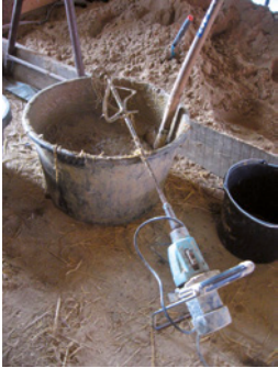
Beim Herstellen des Putzes mit einem Handrührwerk
