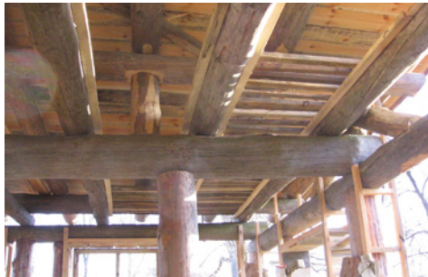
Ablängen der Staken aus rindenfreien Holzresten (links); Einlegen der Staken in die Balkendecke
