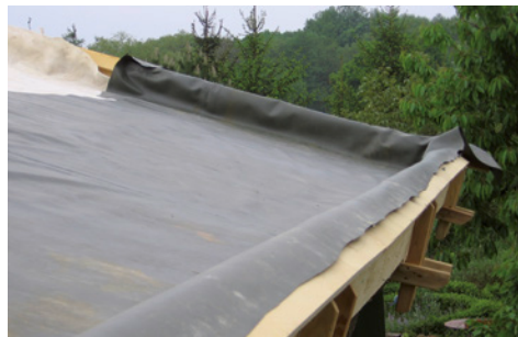
Polyestervlies, als Trenn- und Schutzschicht zwischen Dach und PE-Folie (links); großzügig ausgelegte PE-Bahn
