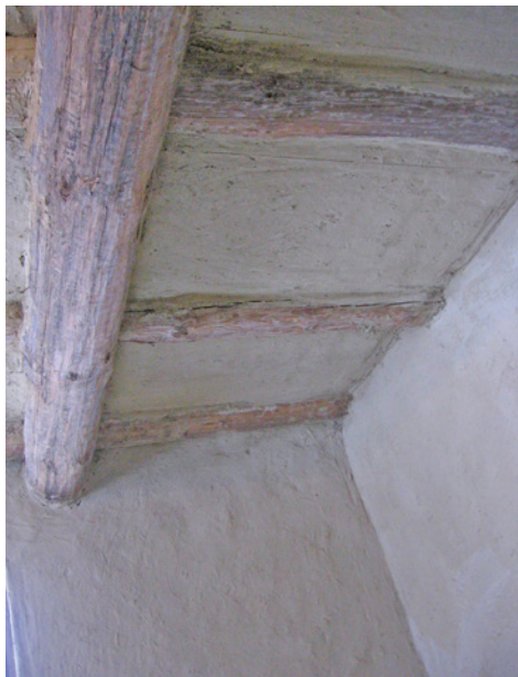
Verputzte und grundierte Decke mit Unterzug und noch nicht gereinigten Deckenbalken
