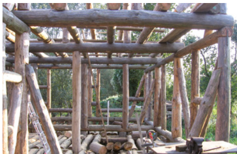
Deckenbalken im Balkenlager (links); Deckenbalken auf dem Ringanker
