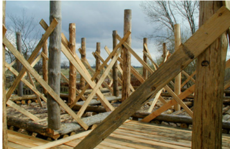
Mit Schalbrettern ausgewinkelte Stiele (oben) und nette Helfer (unten) beim Aufrichten der Stiele
