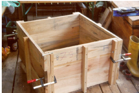
Schalkkasten 75 × 75 cm (links); Schalkkästen für das Tagespensum
