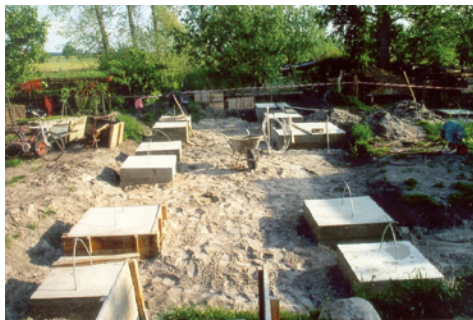
Ein- und ausgeschalte Punktfundamente
