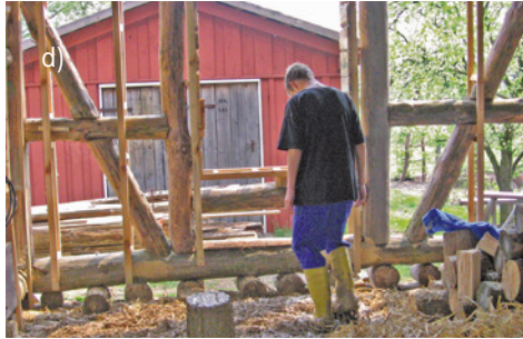
Leichtlehm wird direkt auf der Rundholzfüllung der Bodenplatte angesetzt (links); Mischvorgang »zu Fuß«
