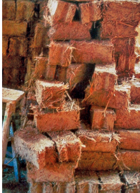
Selbst gepresste Strohleichtlehmsteine
