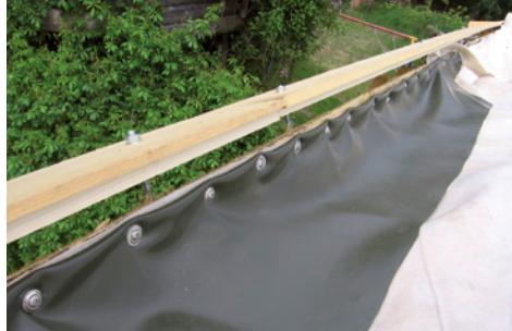
Umgeklappte PE-Folie über dem Schutzvlies (links); rostfreie Spenglerschrauben
