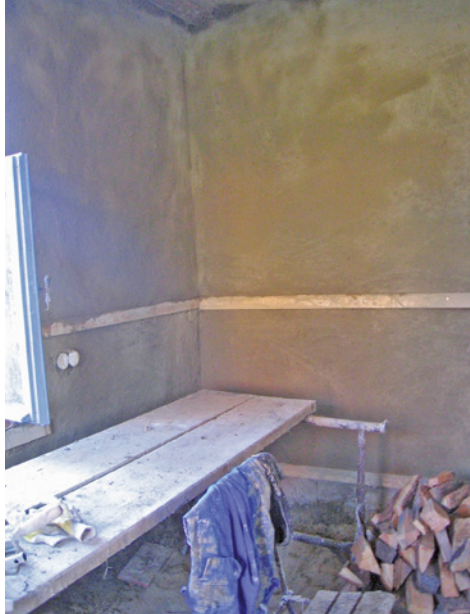
Putzutensilien (links); Frisch verputzte Wand mit Befestigungsleisten für die Wandverkleidung
