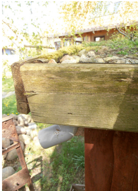
Als Drainagerohr umfunktioniertes HT-Abflussrohr
