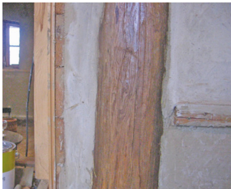
Gereinigte (links) und geölte Fachwerkstütze
