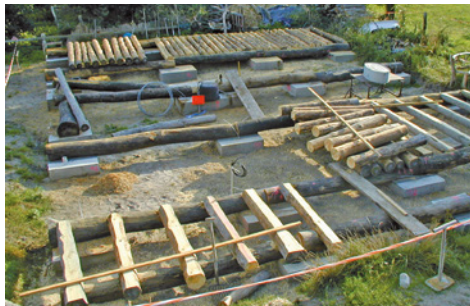
Punktfundamente mit aufgelegten Unterzügen (Eiche) und in diese eingelegte Rundholzfüllung (Kiefer) (links); Punktfundamente mit Unterzügen (Eiche) und Rundholzfüllung (Kiefer) im Vordergrund: die Lagerhölzer für die Veranda
