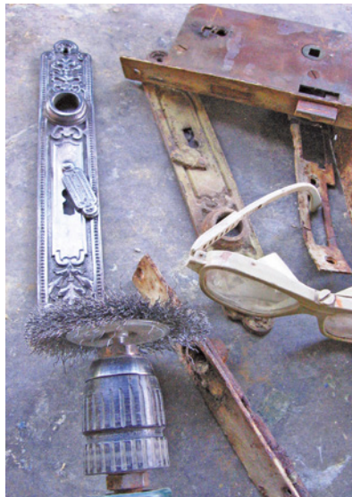
Aufarbeitung der Beschlge (links) und des Schlosses
