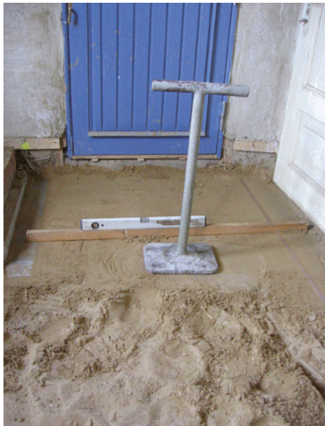
Ausrichten der Bezugslatten: Abziehen und Verdichten des Pflasteruntergrundes auf zwei ausgerichteten Latten
