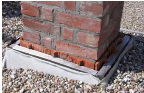
Filterkies der Körnung 8–16 mm als »grundlegender« Substratbestandteil (links); Filterkies der Körnung 16–32 mm im Ortgang- und Trauf- sowie im Schornsteinbereich
