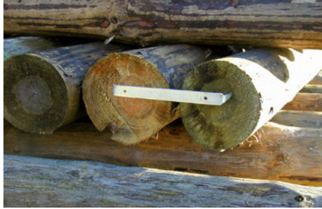
Holzlager auf dem Ringanker (links); Sicherung mit Bauklammern
