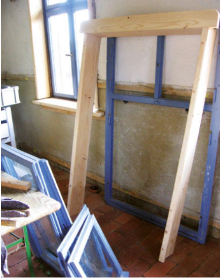
Zu montierende innere Fenstereinfassung (links); Ausrichtung und Fixierung der Fensterverkleidung (Laibung im Innenbereich)
