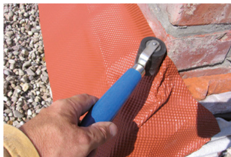
Ankleben des zugeschnittenen Seitenteils (links); Fixieren mit Andruckrolle
