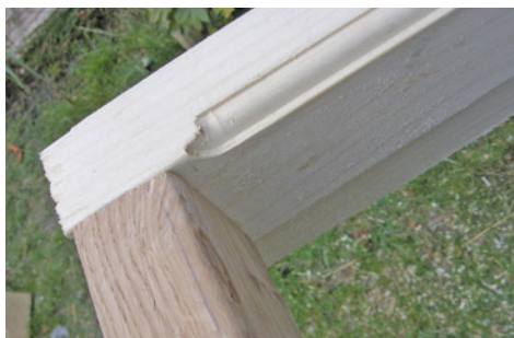
Zarge ausgesägt (links); Verbindung Schwelle–Zarge
