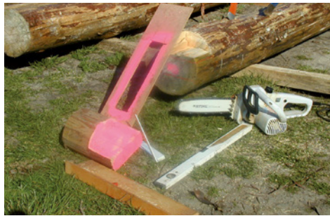
Die Schablonen für den Stiel und den Zapfen (links); Anprobe und Nacharbeiten des Zapfens
