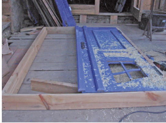
Beim Einpassen der Zarge an die Tür
