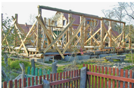
Ausgewinkelte Fachwerkwand mit Rähm (Ringanker)
