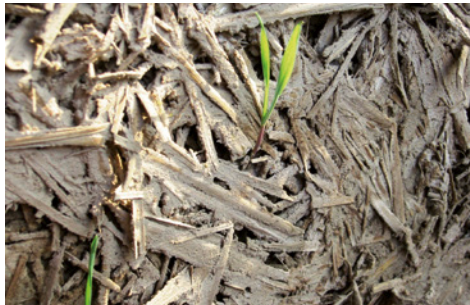
Beim Ausstopfen eines Faches (links); Getreidekeim in der Wand
