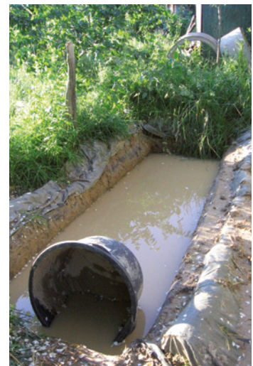
Befüllen der Sumpfrube mit Grubenlehm (links); gewässerter Grubenlehm (mitte); entleerte Sumpfrube
