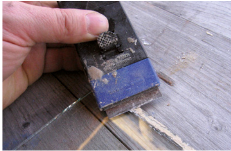
Alte Fenster auf dem Müllplatz eines Fensterbauers (links); Glasreinigung mit einem Ceranfeldreiniger
