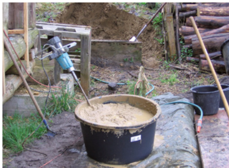
Einschlämmen mit einem Handrührwerk
