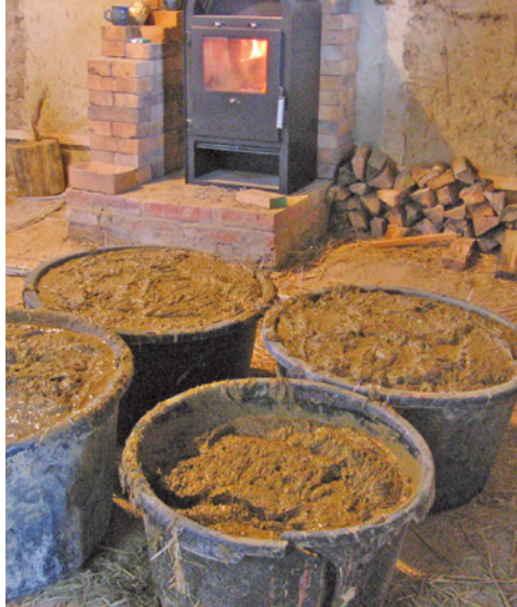
Bei der Zugabe von Häckselstroh (links); fertig angesetzte Putzmischung
