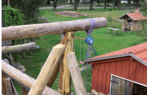
Kettenzug am Ende des Firstes (links); Verlängerter First mit Kettenzug
