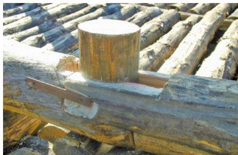
Die Passprobe der Stiel-Nachbildung
