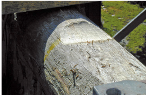
Runde Balken müssen in runden Auflagen gelagert werden.
