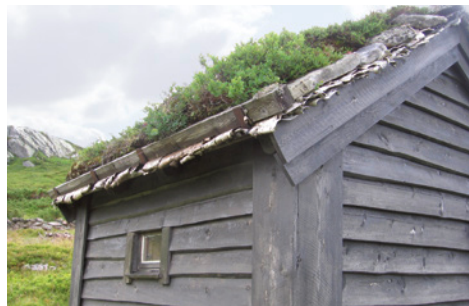
Häuser mit Grasdach in der Telemark (Süd-Norwegen); Abdichtung mit Birkenrinde im Trauf- und Ortgangbereich (rechts)
