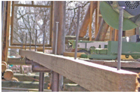
Die vorbereiteten, vorgebohrten und mit Nägeln versehenen Lagerhölzer
