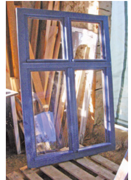
Fenster, über hundert Jahre alt, restauriert und bereit für den Einbau (oben); das Aufarbeiten von alten Beschlägen ist eine sehr schöne und lohnende Arbeit (unten)
