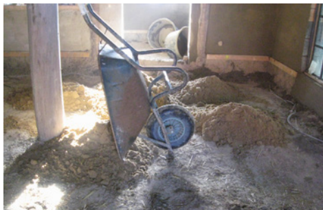
Ausgefachtes Wandsegment und Leichtlehmestrich auf einem Teil der Holzbodenplatte (links); Lagerschicht für den Bodenbelag
