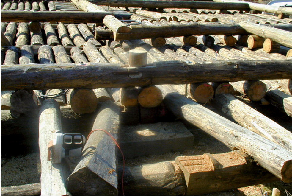
Punktfundamente, Unterzüge aus Eiche, Rundholzfüllungen, Schwellen mit Gewindebolzen- verankerung und Abstandshaltern aus Holzabschnitten
