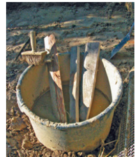
Einschlämmen in einer Mörtelwanne
