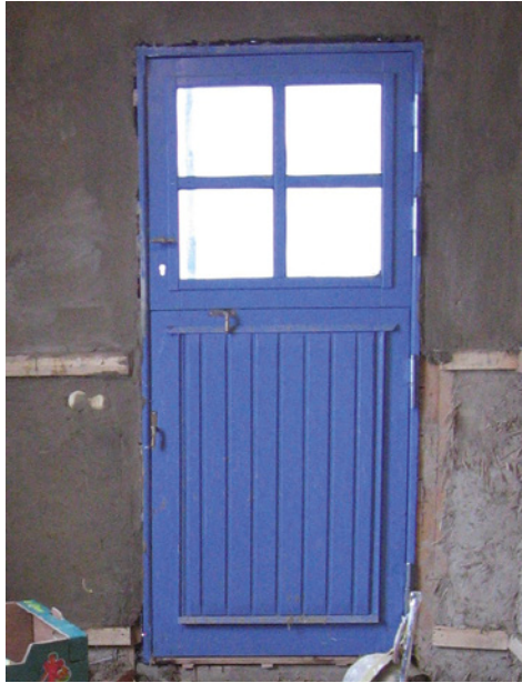
Rohbauöffnung (links); eingebaute Klöntür
