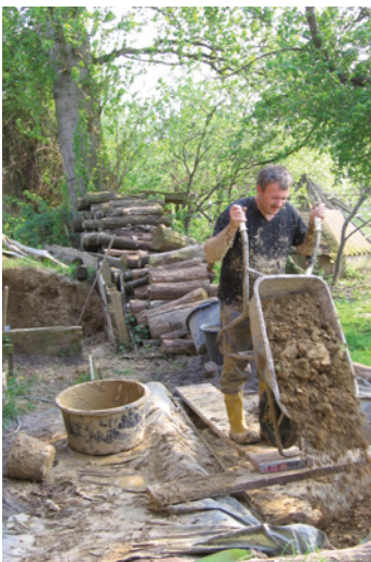
Befüllen der Sumpfrube mit Grubenlehm (links); gewässerter Grubenlehm (mitte); entleerte Sumpfrube
