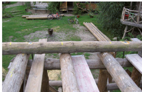
Die Mittelpfette, welche hier auf den Deckenbalken aufliegt, wird mit einer Rundstahlverbindung am Ringanker montiert
