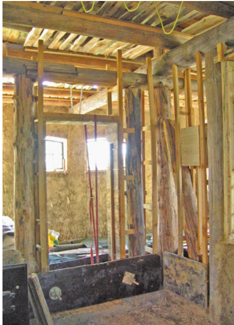
Eingeschalter Rohbaukasten einer zur Zeit nicht benötigten Türöffnung
