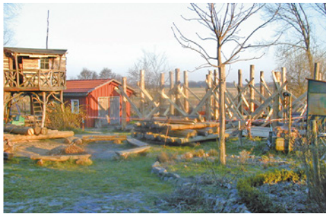
Ausrichten der Stiele mit einer Drachenschnur (links)
