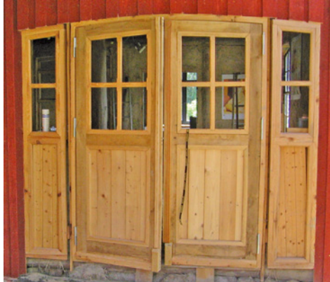
Aus einer Dachlatte wird ein Fensterkreuz (links); Fertiges Tor (unbehandelt)
