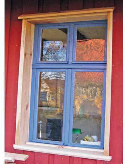
Fensterlaibung ohne (links) und mit Holzverkleidung (im Rohbau, mitte); Fertig montiertes Fenster
