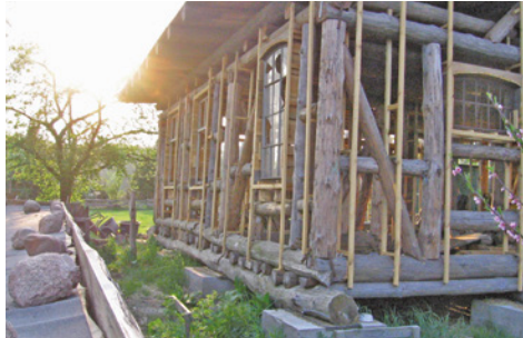
Rohbauöffnungen für die Fenster
