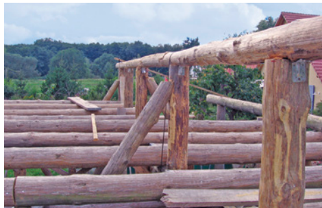
Firstpfette (links); Firstpfette mit aufliegenden Sparren
