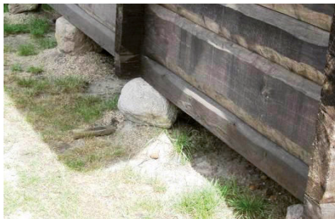
Gründung eines Spreewaldhauses auf Punktfundamenten [Fotos: Th. Stöber]
