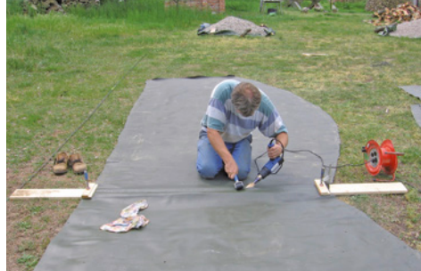
Beim Überlappschweißen (links); Vorsicht mit dem Kabel!
