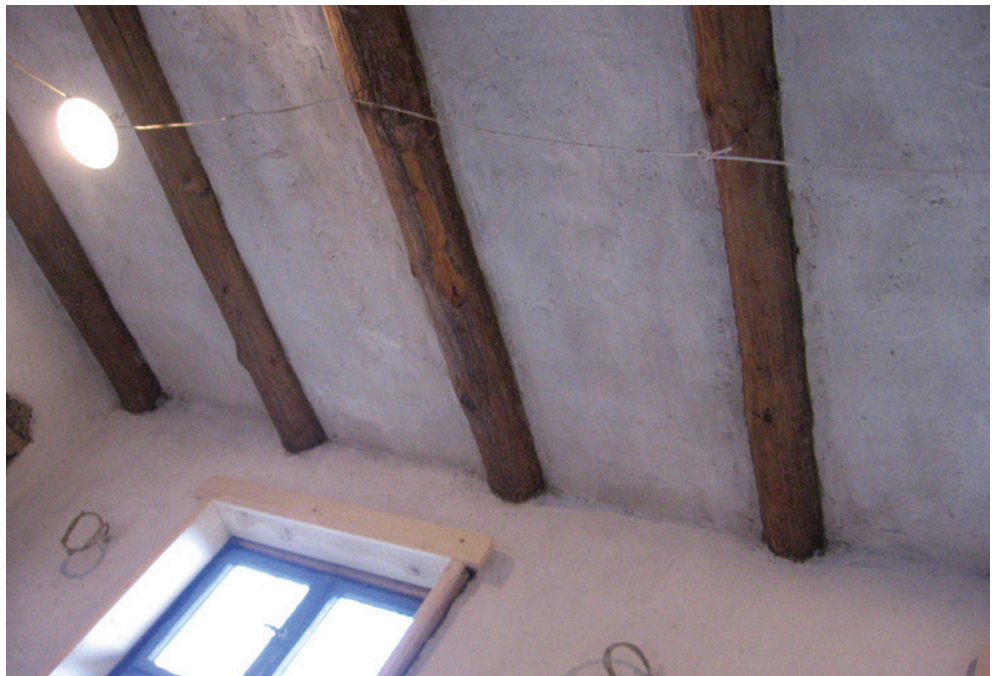
Gekalkte Wickeldecke mit geölten Deckenbalken
