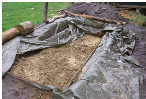
Befüllen der Sumpfrube mit Grubenlehm (links); gewässerter Grubenlehm (mitte); entleerte Sumpfrube
