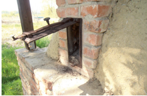
Backofen, Ansicht von hinten (links); Schornstein-Reinigungsöffnung
