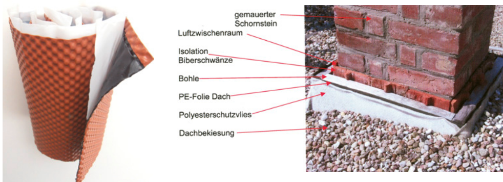
Flexible Abdichtung (links); Schornsteinkopf noch ohne Schornsteinverwahrung
