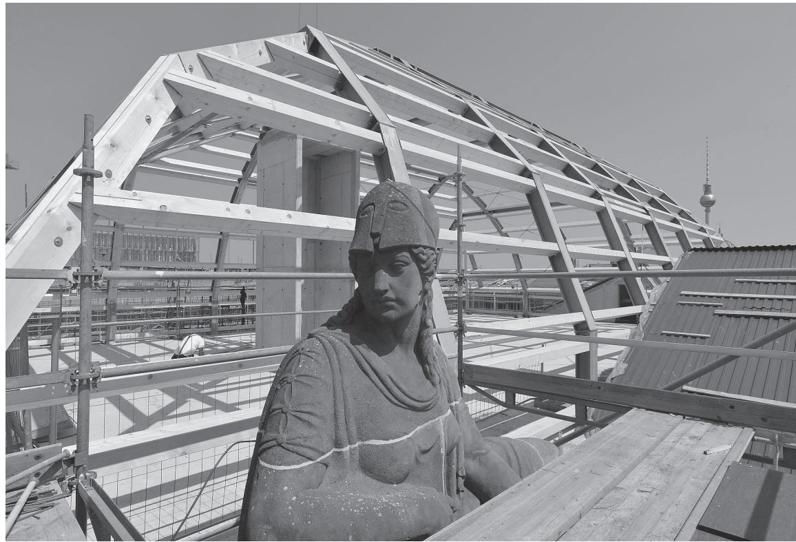
5 Der Wiederaufbau der Kuppel über dem Hauptportal Unter den Linden vor dem Richtfest für die Kuppel im Juli 2013
