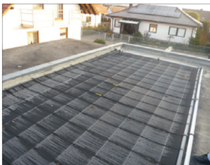
Abb. 1: Solarabsorber
