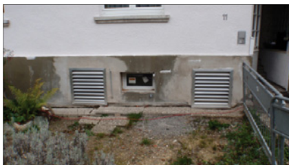
Abb. 18: Ausblasöffnungen einer im Gebäude-Innern aufgestellten Wärmepumpe
