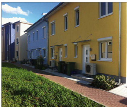
Abb. 17: Geräuschbelästigungen durch im Freien angeordnete Wärmepumpen
