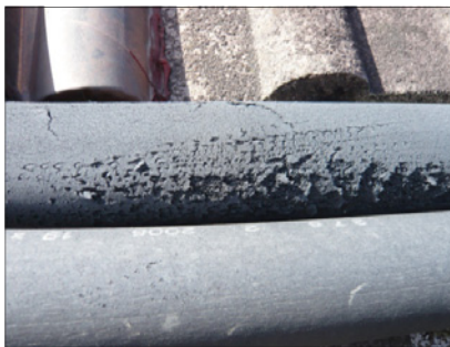
Abb. 10: Alterung der Wärmedämmung durch Sonneneinstrahlung
