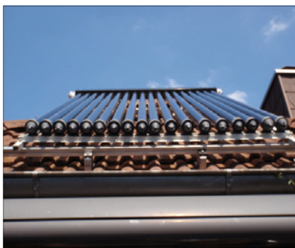
Abb. 3: Vakuum-Röhrenkollektor
