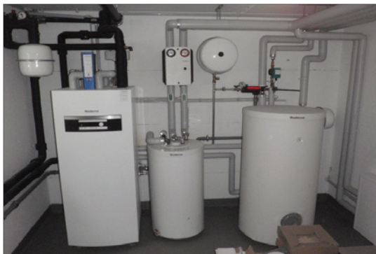
Abb. 15: Sole/Wasser-Wärmepumpe mit Pufferspeicher und Trinkwassererwärmer
