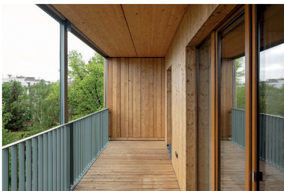
Bild 5 Bei Holzfassaden können die Dämmschichten – im Gegensatz zur Massivfassade aus Beton oder Mauerziegel – in die Konstruktion integriert wer- den. (Foto: Andreas Meichsner)
