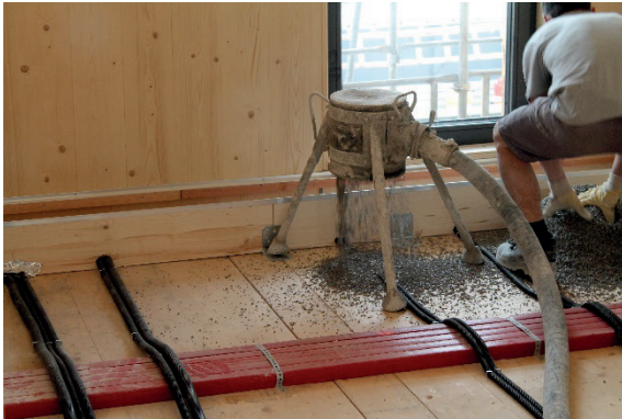
Bild 5 Einbringung einer Splittschüttung und Überdeckung von Rohrleitungen auf der Rohdecke (Foto: Lattke Architekten)
