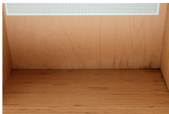
Bild 4 Buchen-FSH-Deckenuntersicht: nach Behandlung mit Oxalsäure (Foto: Lattke Architekten)
