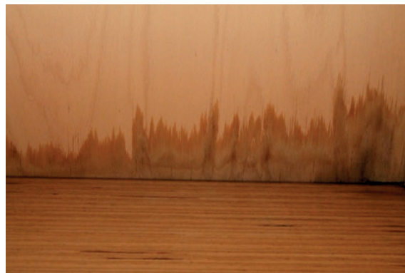
Bild 3 Buchen-FSH-Deckenuntersicht: Verfärbung durch Feuchtigkeit (Foto: Lattke Architekten)
