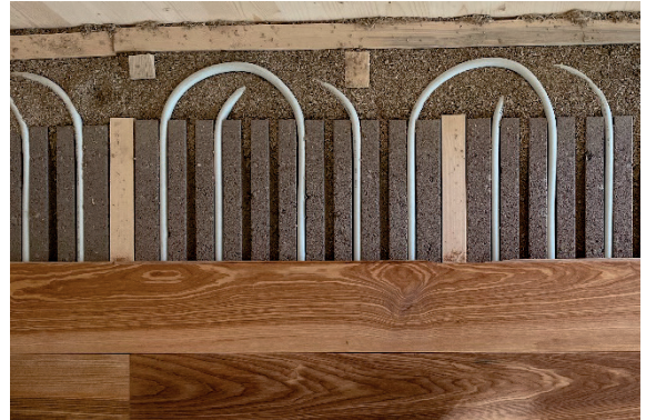
Bild 7 Bodenaufbau: Parkettdielen (Esche) auf Holzleisten des Trockenestrichs verschraubt; zementgebundene Holzsnitzelschüttung als Ausgleich in den Randbereichen (Foto: Lattke Architekten)
