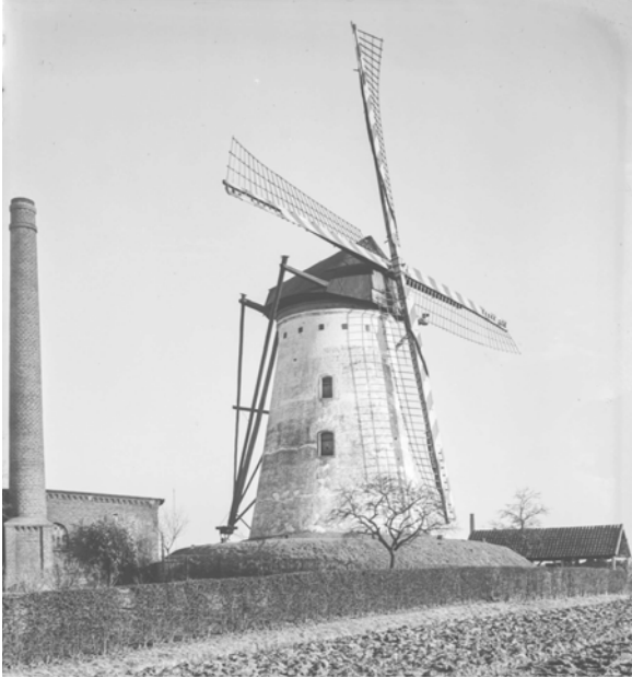
Abb. 3: Ölmühle in Kalkar-Grieth, nach 1800, Foto 1930.
