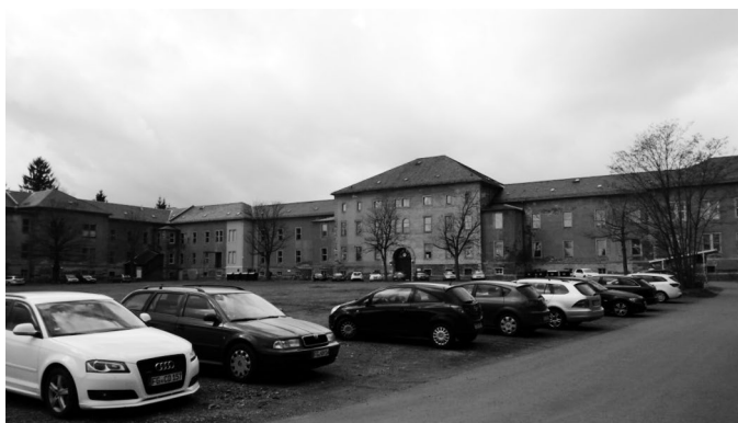
Abbildung 8: Gebäudekomplex in der Lessingstraße, in dem sich das zentrale Depot der Kustodie befindet
