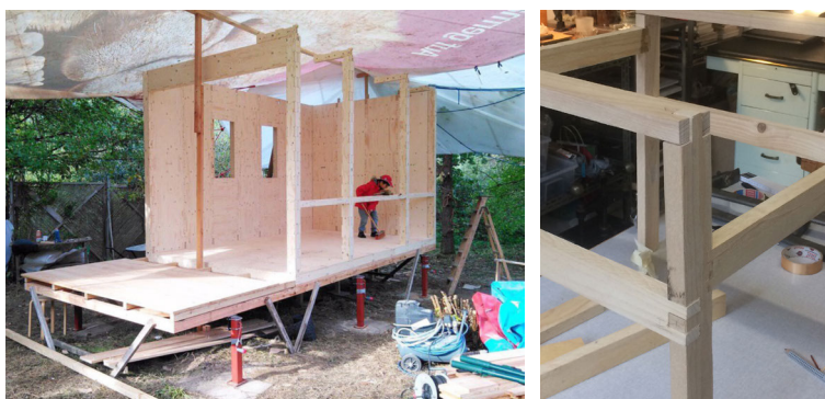
Abb. 7/8: Das linke Bild zeigt den Zusammenbau eines ersten Prototyps für ein CNC-gefrästes Tiny House bei WBZ. Auf dem rechten Bild dokumentiere ich zeitgleich die neu erlernte Steckverbindung für das Grundgestell meines Stuhls, den ich während des Lockdowns baue.
