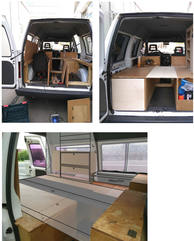
Abb. 21/22/23: Planung und Umbau an der HGK Basel, 2019.
