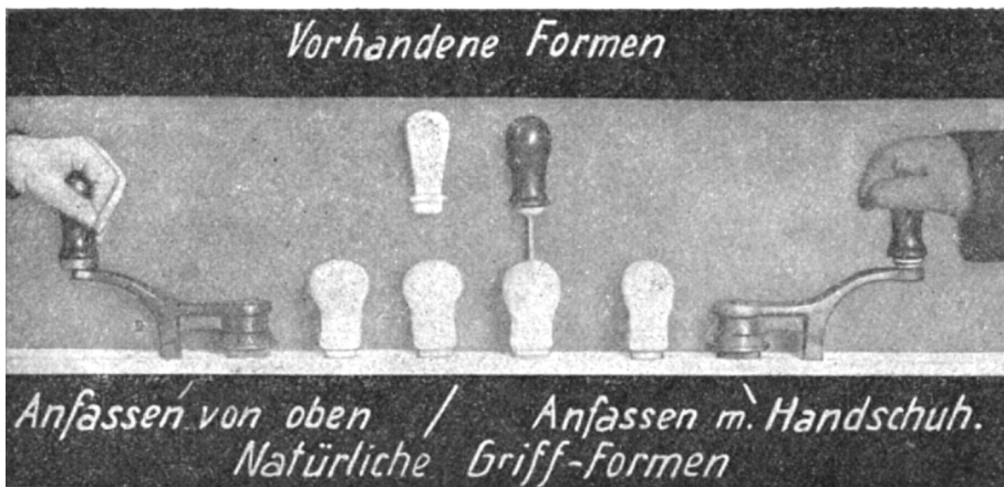
Abb. 3. Die Ermittlung der natürlichen Griffform eines Bedienungsmittels. Quelle: Karl August Tramm, Psychotechnik und Taylor-System. Bd. 1, Berlin u. Heidelberg 1921, S. 49
