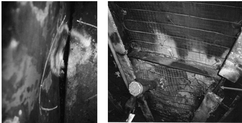
Bild 2: Links: Spalt an einer Konusecke (Filter innen) Rechts: abisolierter Filterrumpf mit Undichtheiten im Konusteil (roter Pfeil)
