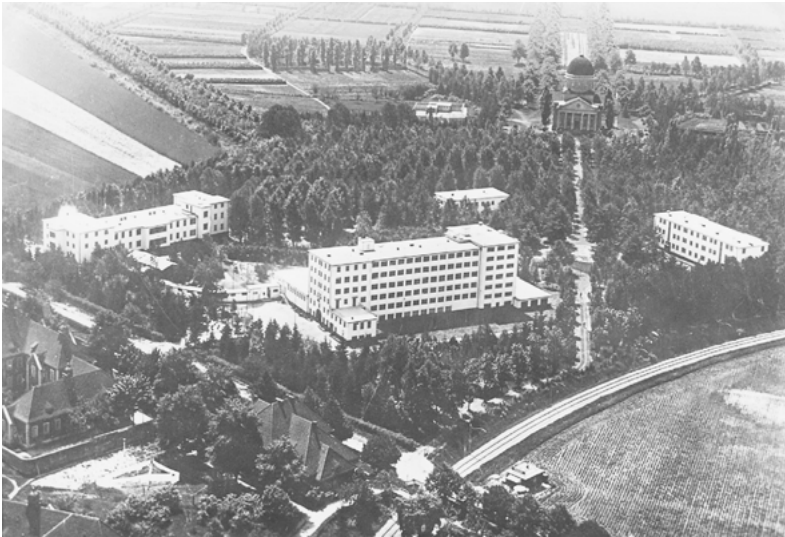
Abb. III.2: Sicht auf das Gelände des Bucher Instituts mit der ehemaligen Kapelle
