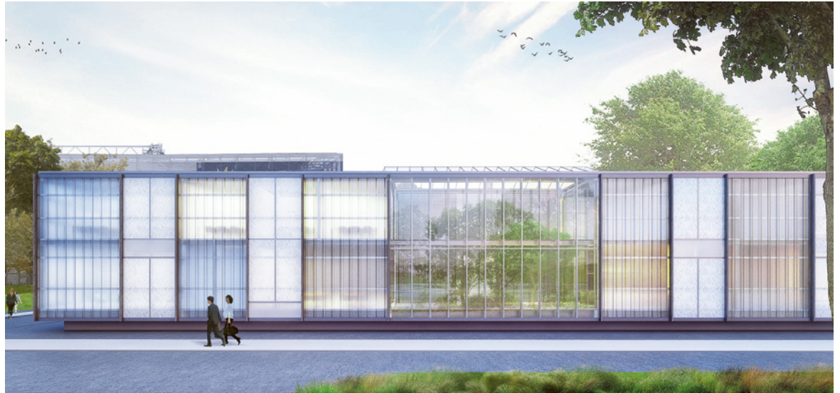
ABB. 8 Die Fassade des 3000 m 2 großen Pavillons besteht aus Lagermaterialien in Standardgröße, die mit Klemmsystemen montiert werden.
