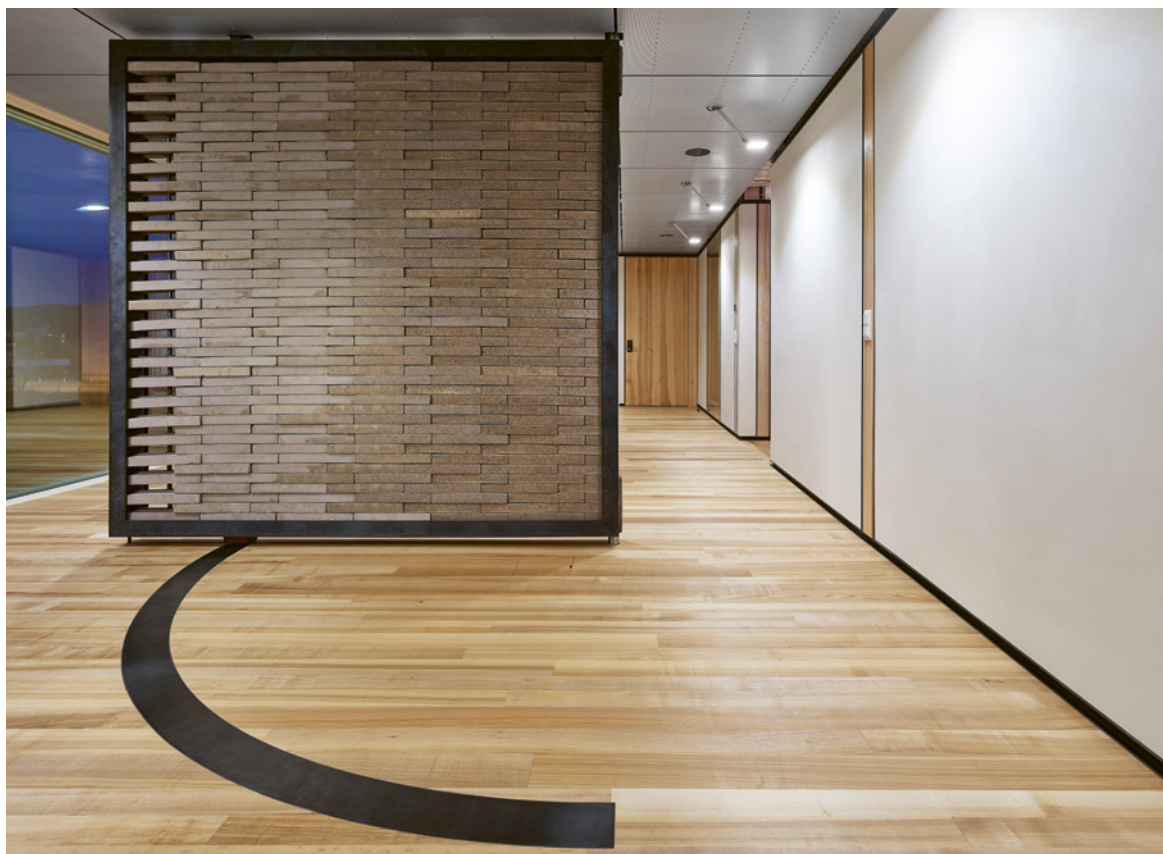
ABB. 12 Die Ziegelsteine der Drehwand in der UMAR-Unit bestehen aus mineralischen Bauabfällen, klein gemahlen und farblich neu kombiniert.
