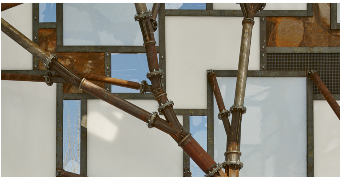
ABB. 2 Innenansicht der Fassade des Mehr.WERT.Pavillons aus wiederverwendetem Stahl und wiederverwertetem Glas
