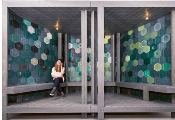
ABB. 6 In der Kombination aus Pretty-Plastic und handelsüblichen grauen Recycling-Kunststoffpaneelen aus Pferdeställen konnten Innenelemente fast vollständig aus wiederverwertetem Kunststoffabfall hergestellt werden.
