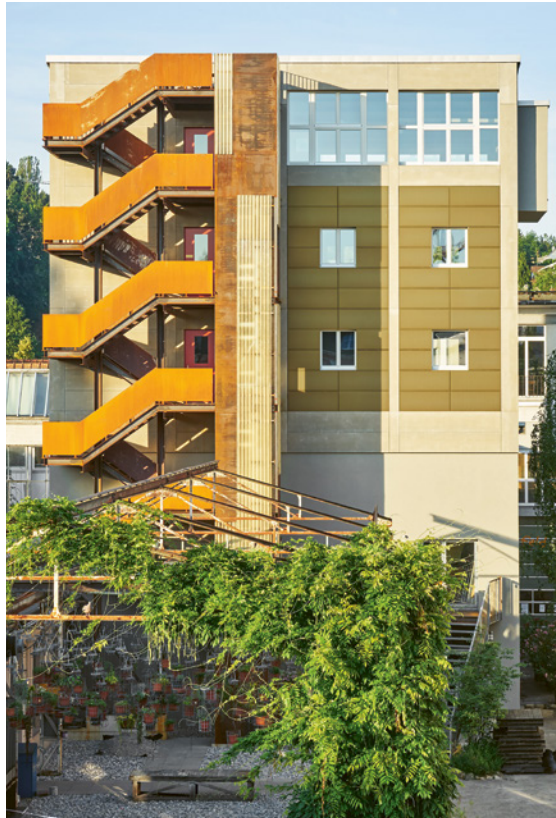
ABB.3 Gundeldinger Feld, Silo: Fassade aus wiederverwendetem Material und farbiger PV-Anlage
