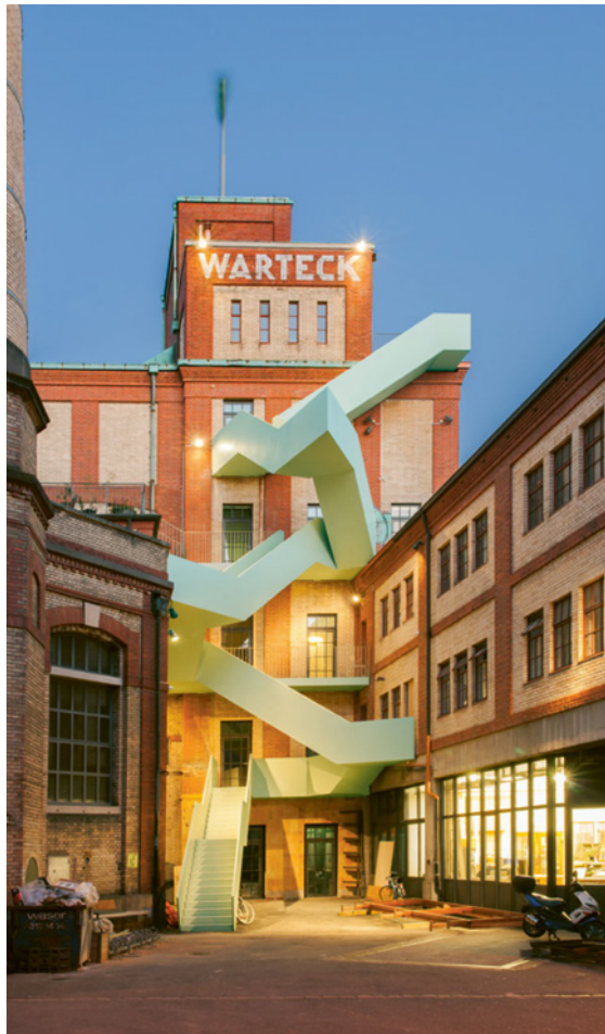
ABB. 5 Werkraum Wardeck, Basel: Einzug von Ebenen in ehemalige Malzsilos, erschlossen durch eine Außentreppe
