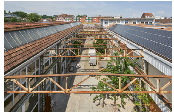
ABB. 8 Gundeldinger Feld, Basel: Schaffung von Innenhöfen durch das Wegnehmen der Dachhaut unter Erhalt der Tragstruktur der ursprünglichen Werkhallen
