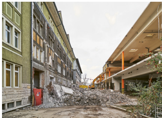
ABB. 17 Lysbüchel, Basel: Rückbau um zwei Gebäudeachsen zur Erstellung einer autofreien Durchwegung (Schneise) zwischen Schulgebäude (links) und ELYS (rechts) ins neue Quartier Volta Nord (ein Projekt von Immobilien Basel Stadt)
