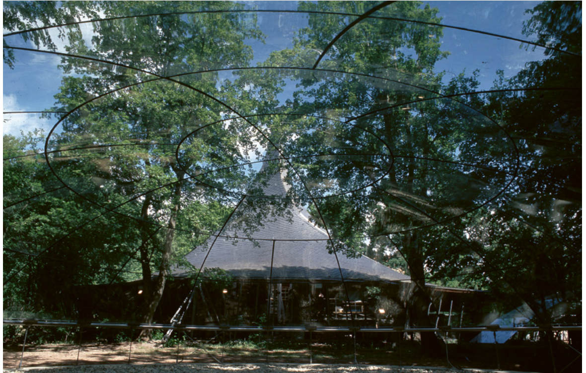
ABB. 1 Die Stuttgarter Glasschale wurde ohne jegliche metallischen Verbindungselemente realisiert. Im Hintergrund ist das Institutsgebäude des ILEK zu sehen.
