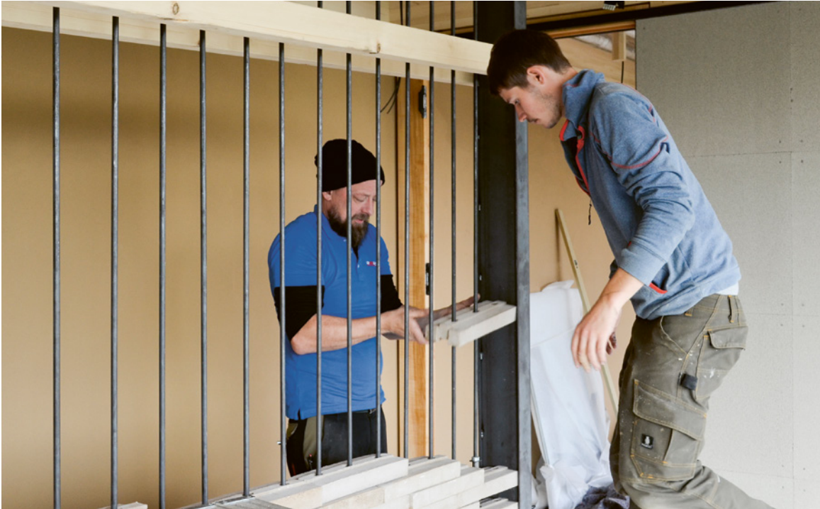
ABB. 11 Die innovativen Ziegelsteine sind mörtelfrei gefügt, sodass sie direkt und schadensfrei wiederverwendbar sind.
