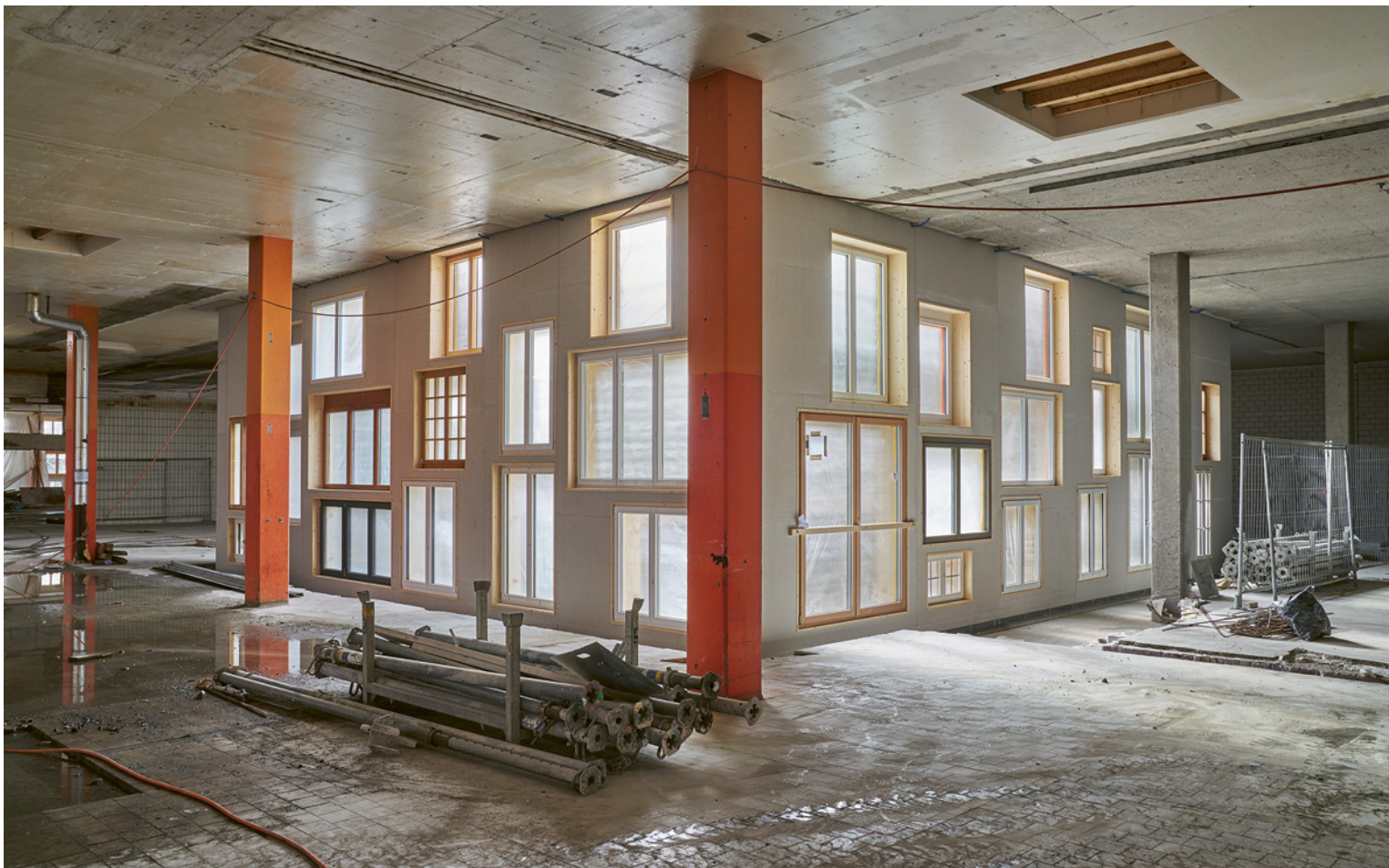
▲ ABB. 10 ELYS, Basel: Um Licht in den bestehenden Baukörper zu transportieren, wird ein Innenhof geschaffen.
