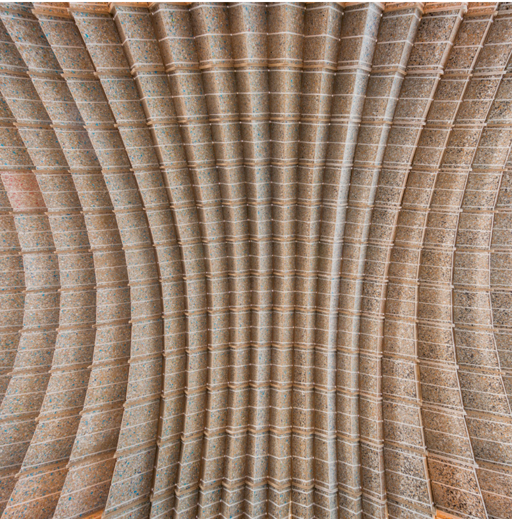
ABB. 7 Untersicht der nur auf Druck belasteten Schale
