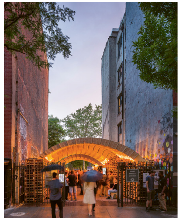
ABB. 9 Das Material ist aufgrund seiner Zusammensetzung wasserabweisend. Durch die Anordnung der einzelnen Platten auf der Oberseite der Schale in Form eines überlappenden Schuppenkleids konnte auf Silikone oder Kleber verzichtet werden.
