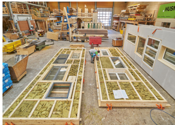
ABB. 20 Vorfabrizierte Holzrahmenelemente aus Altholz mit Abschnitten aus weiterverwertetem Dämmmaterial und Lagerfenstern
