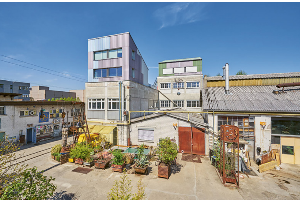
▼ ABB. 7 Walzwerk, Münchenstein: Aufstockungen mit wiederverwendeten Fassadenblechen
