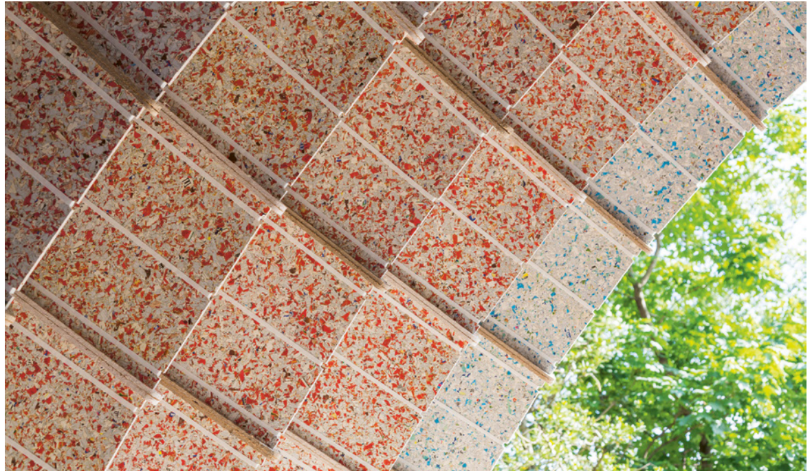
ABB. 4 Die Oberfläche der Platten offenbart die Geschichte des Rohstoffes: Orange für Orangensaft, Blau für Milch und Schwarz für Wein.
