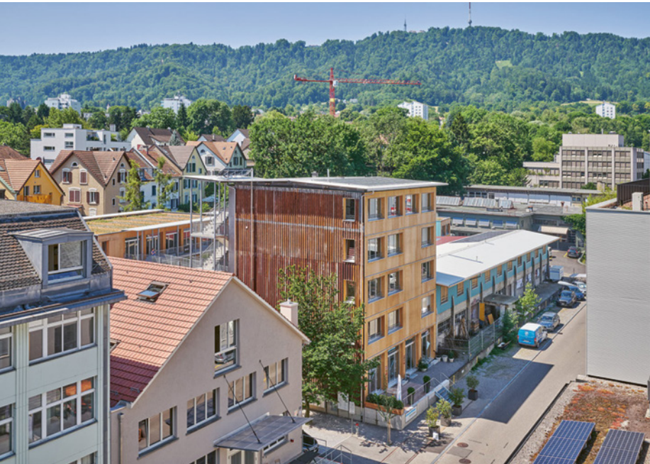
▲ ABB. 12 Werkhof Binz, Zürich: Nachverdichtung ohne Verlust des Bestehenden, neue Baukörper und Aufstockung in Holzmodulbauweise; auch die Strategien »Wegnehmen«, »Seinlassen« und »Reparieren« wurden angewendet.
