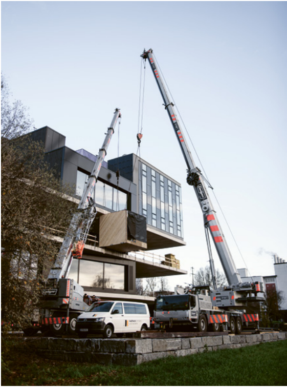
◀ ABB.5 Beim Einbau der Unit wurden die Module mithilfe von zwei Autokränen innerhalb eines Tages in Position gehoben.
