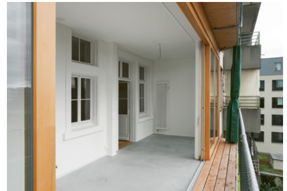
ABB. 6 Güterstrasse 81, Basel: Anbau in Holzbauweise unter Erhalt der Hinterhof-Fassade hinter dem Anbau
